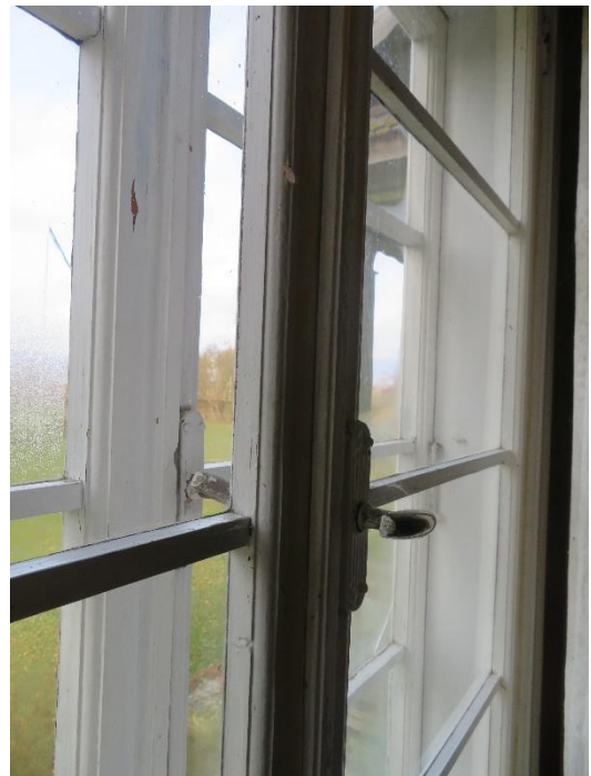
119 Elumaja esimese korruse akende ehitusaegsed sulused (autori foto)
