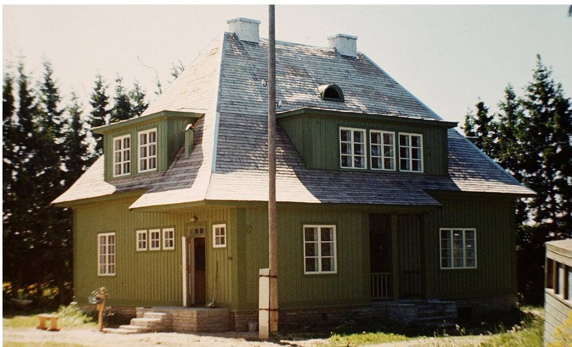
28 Aedla elumaja 1976 peale Lahemaa tellitud kapitaalremonti. Esimese korruse köögi aken on valmistatud vale ruudujaotusega (diapositiiv, Anu Kotli erakogu).
