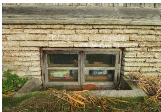
52-53 Vasakul vaade tagafassaadi keldri paekivitrepiga sissepääsule. All keldri kaheraamsed aknad 1975. aastast. (Autori fotod)
