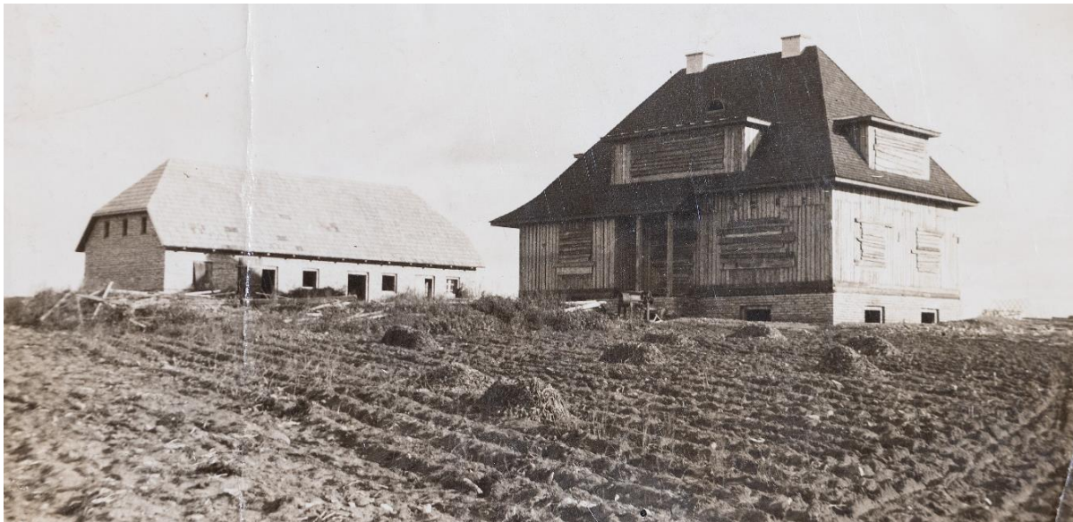
35 Aedla hooned 1931, mil aknaid ja uksi veel ees ei olnud. Elamul puudub laudis ja näha on püstpalkidest seinakonstruktsioon. (Perekond Nõva erakogu)
