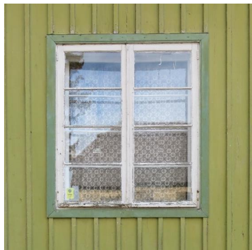
45-47 Vasakul esimese korruse idapoolse nurgatua restaureerimist vajav idafassaadi poolne algupärane aken (veenina vajab väljavahetamist). Üleval esimese korruse keskmise toa lõuna-fassaadile avanev 2020.a. restaureeritud algne aken. All algsed sulused esimese korruse elutoa aknal.
