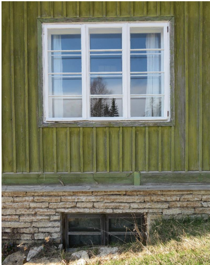
45-47 Vasakul esimese korruse idapoolse nurgatua restaureerimist vajav idafassaadi poolne algupärane aken (veenina vajab väljavahetamist). Üleval esimese korruse keskmise toa lõuna-fassaadile avanev 2020.a. restaureeritud algne aken. All algsed sulused esimese korruse elutoa aknal.
