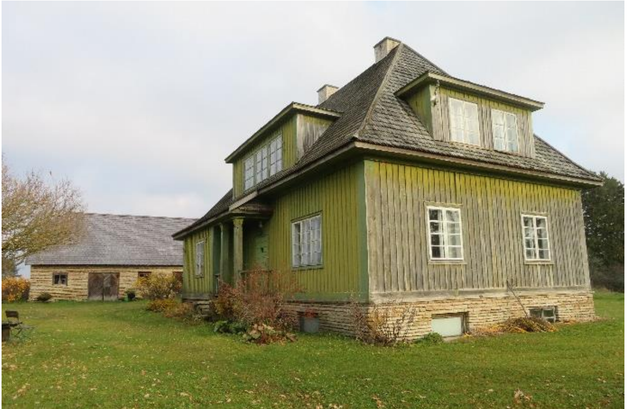
120 Aedla elumaja ja kõrvalhoone, vaade esi- ja läänefassaadile, 2021.
