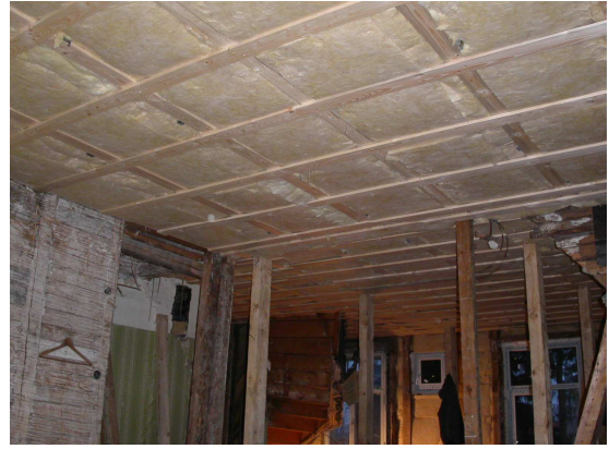
Foto 18. Teise korruse ehitustöödest
