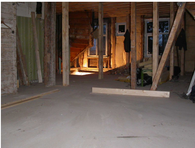
Foto 19. Teise korruse ehitustöödest- uus vahelagi
