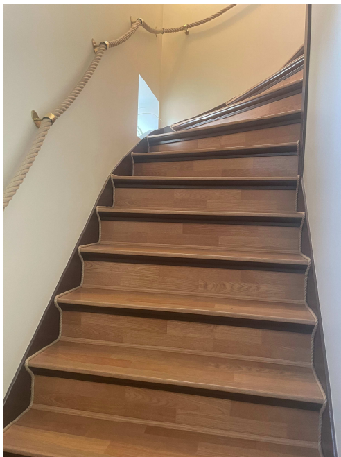
Foto 26. Sisetrepp 2 teisele korrusele
