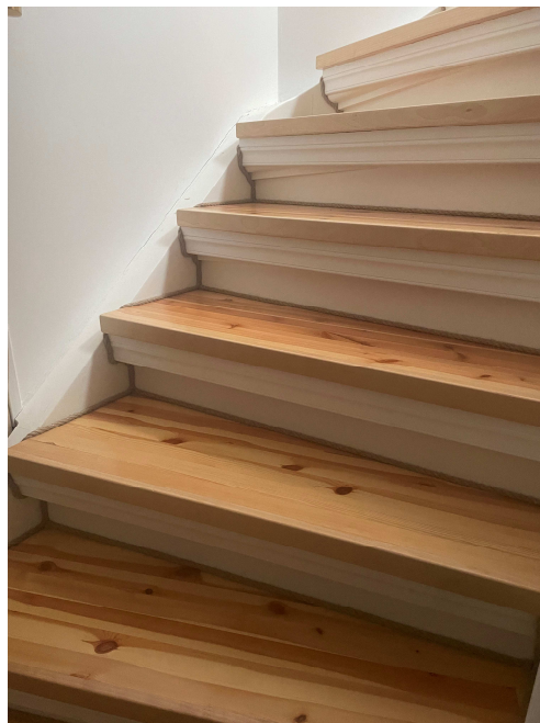
Foto 27. Sisetrepp 2 kolmandale korrusele
