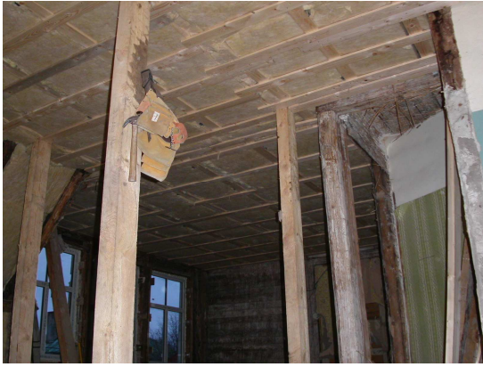
Foto 17. Teise korruse ehitustöödest
