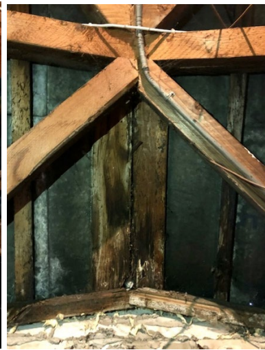
III.8-9 Korstna läbiviik, näha on kerget veekahjustust puitkonstruktsioonil.
