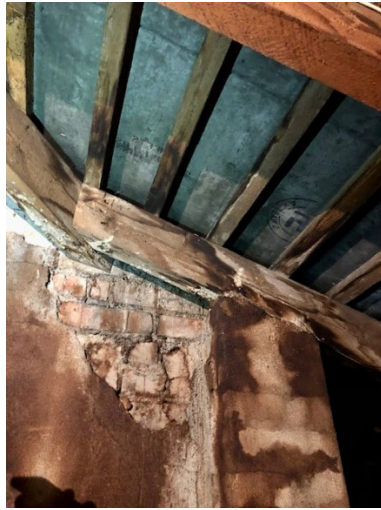
III.8-9 Korstna läbiviik, näha on kerget veekahjustust puitkonstruktsioonil.
