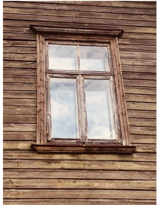
Joonis 41. Tagafassaadi koridori aken algse puit dekooriga
