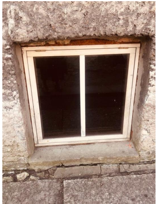
Joonis 47. Klaaspaketiga keldriaken
