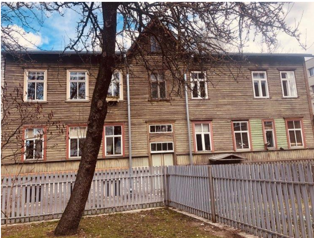
Joonis 15. Lastekodu 28 hoone tagafassaad edelast (autori foto).
