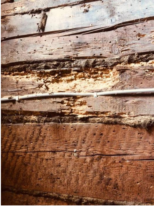
Joonis 55. Trepikoja palgi puidu kahjustused (autori foto)
