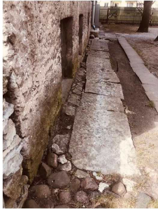
Joonis 18. Paekivi sillusvöö (autori foto)
