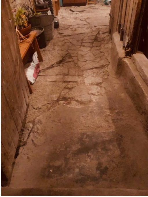
Joonis 22. Paekivi ja betoon põrandakate (autori foto)
