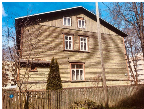
Joonis 25. Otsaviilu laudis ja pärlinite kohad (autori foto)
