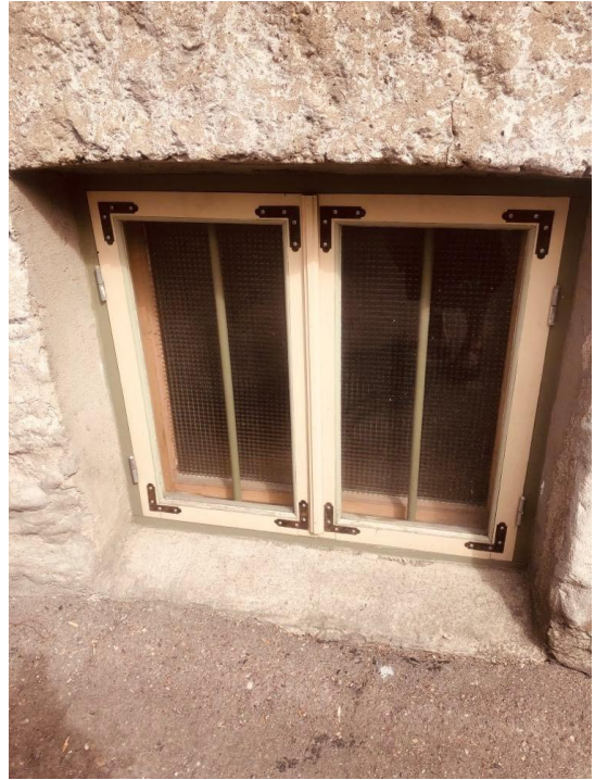
Joonis 45. Kahepoolsest avanevad hingedel aknad
