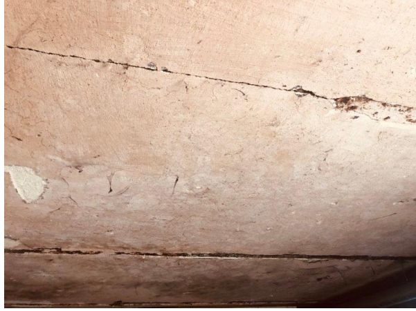
Joonis 23. Lamebetoon metalltaladel (autori foto)
