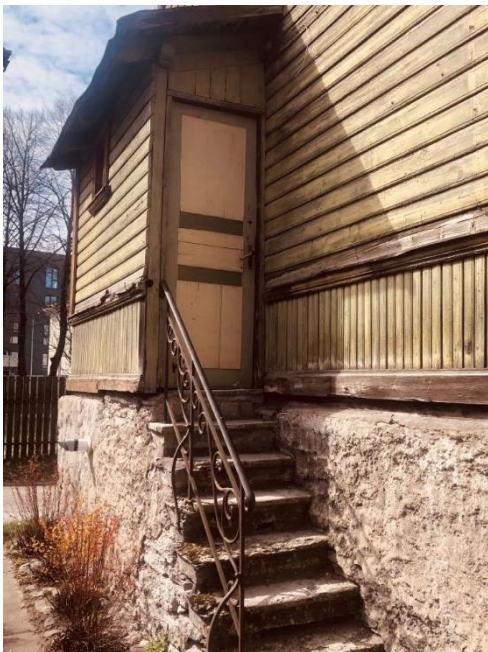
Joonis 37. Paekivi plaatastmetega trepp (autori foto)
