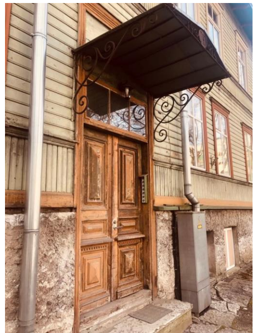
Joonis 34. Sepiskonsoolidel varikatus (autori foto)
