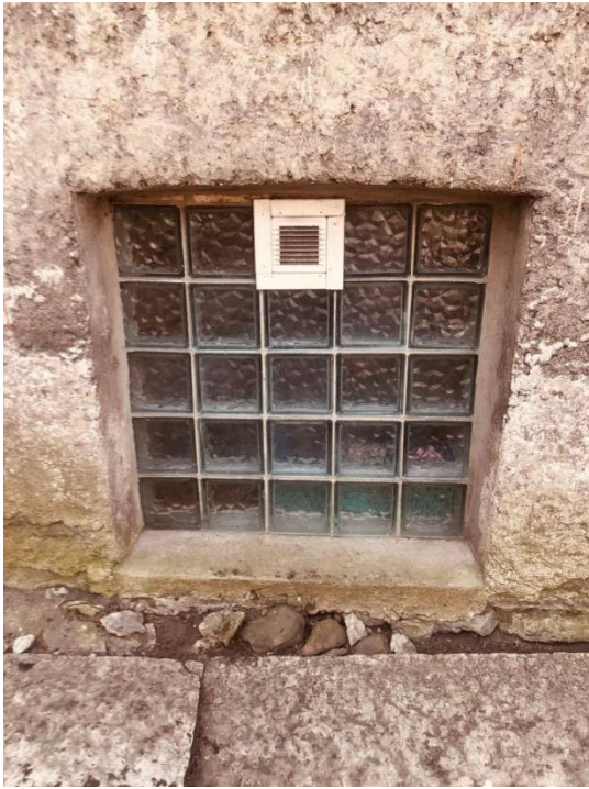
Joonis 44. Klaasplokist keldriaknad (autori foto)
