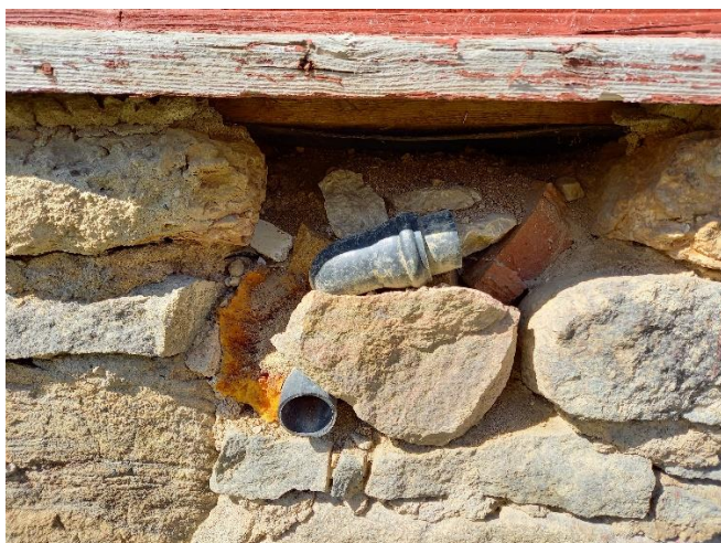
37. Vana torustiku jäänused vundamendis, 2022
