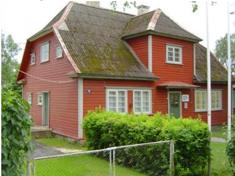
26. Virumaa Veepumbakeskus OÜ kooli aial renoveeritud välisfassaad, 2000.
