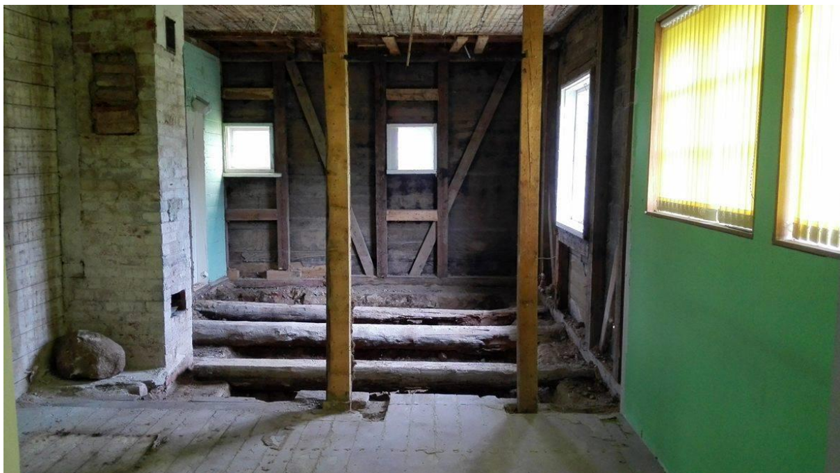
40. Sõrestiksein avatuna enne seinä soojustamist, 2017
