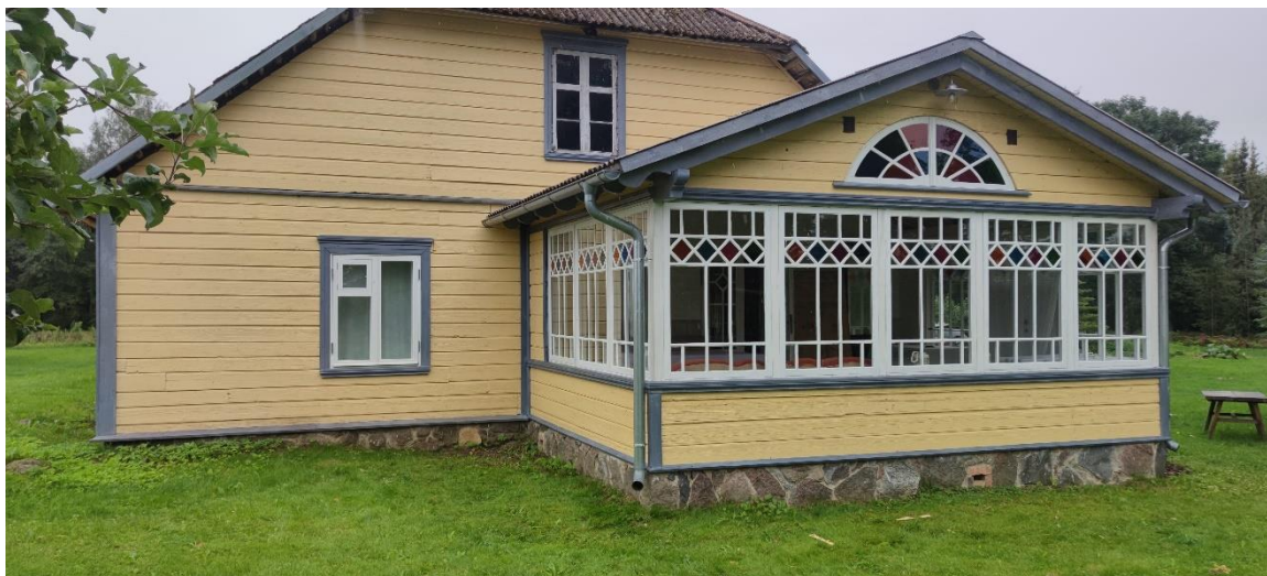
Ill.34 Veranda välisvaade
