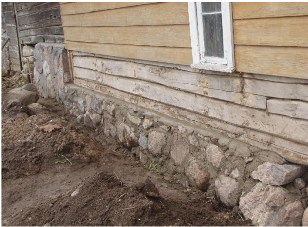
Ill.22 Vundamendi taastamine hoone põhjaküljel
