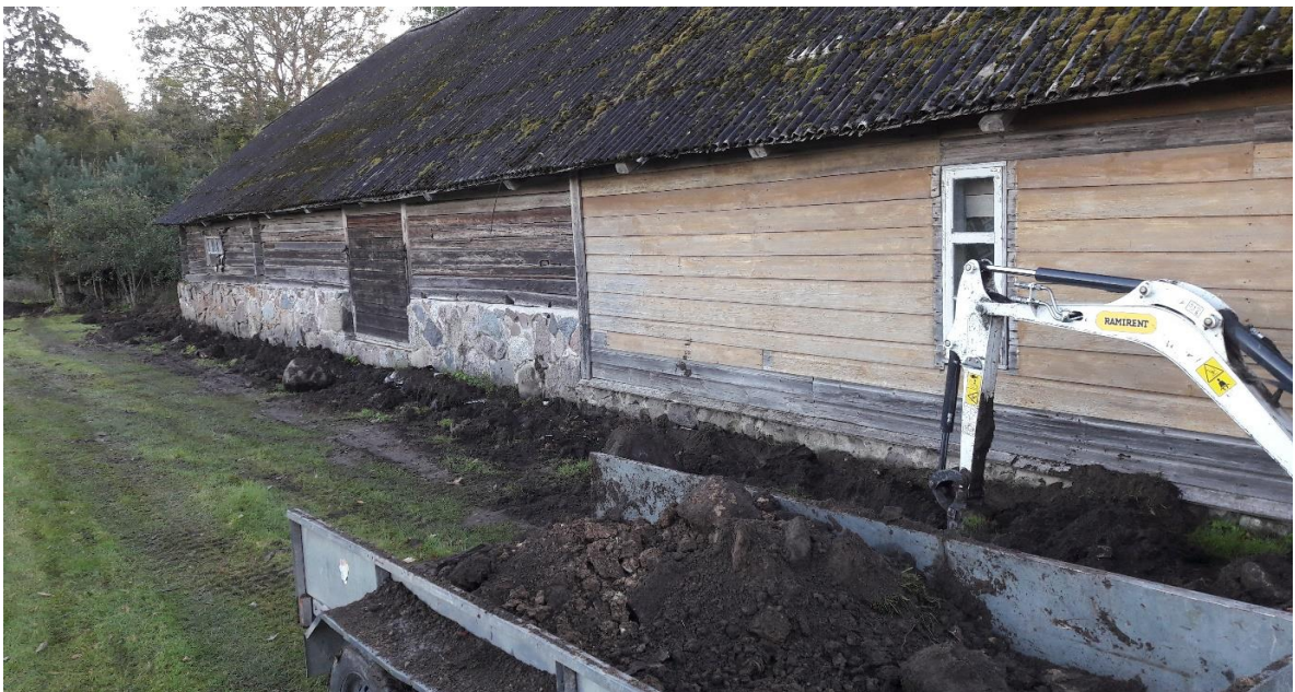
Ill.23 Drenaaži kaevamine hoone põhjaküljel
