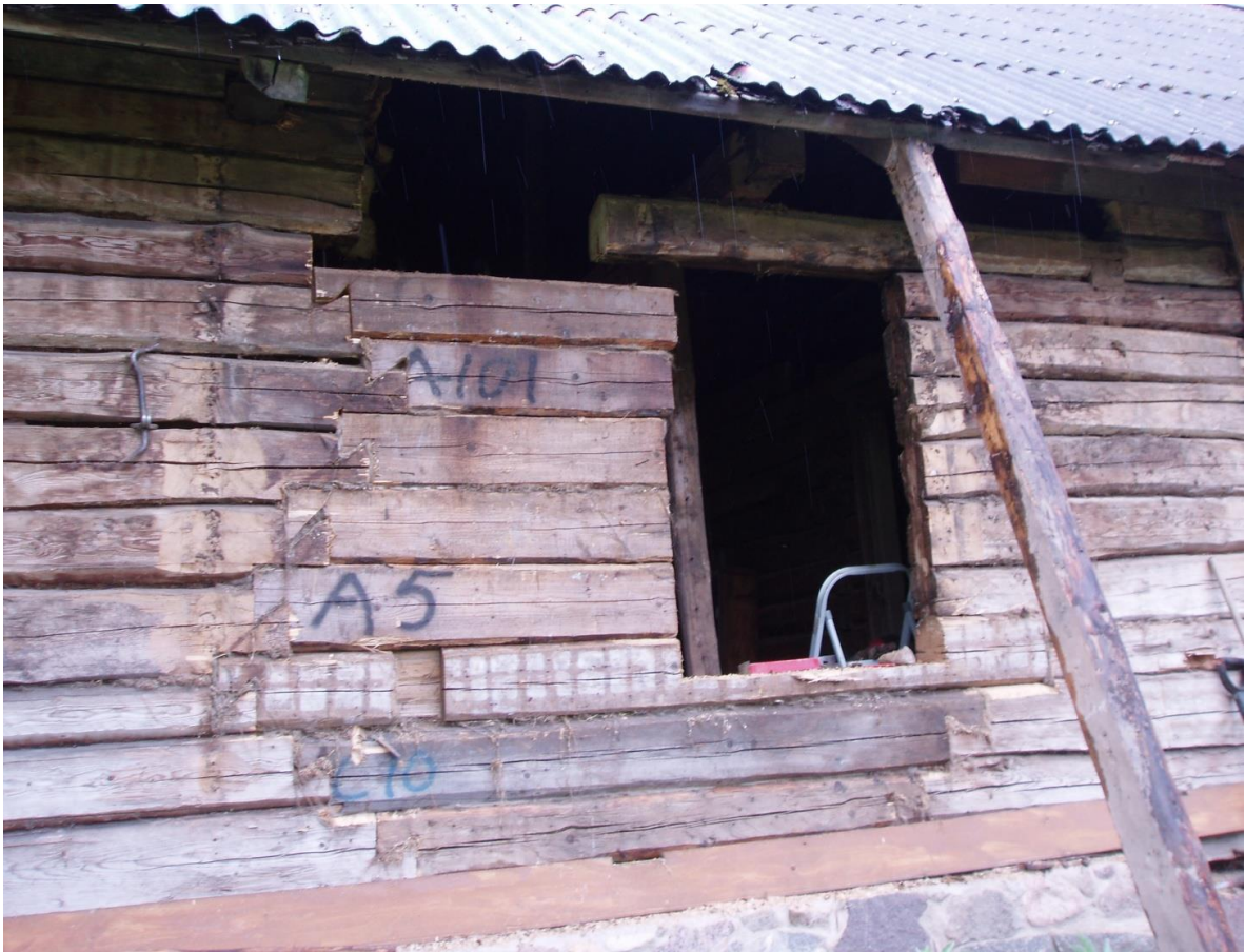
Ill.24 Köögi välisseina proteesimine, tööde teostamise ajal oli köögi laetala toestatud nii seest kui ka väljastpoolt
