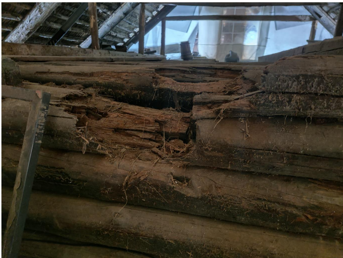
Ill.17 Rehetoa palkide kahjustus. Kahjustus tekkis pärast reheahju puitkorstna lagunemist ja enne eterniitkatuse paigaldamist.
