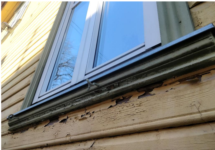
Pilt 38. Lähedalt vaade uue akna lamedale profiilile ja akna karniisi seisukorrale.
