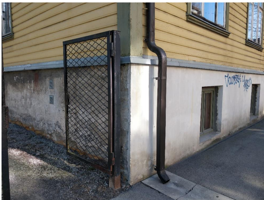
Pilt 33. Tänavapool on sadevesi juhitud kanalisatsiooni.
