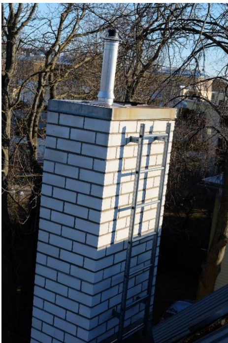
Pilt 41. Korstnapits katusevaatel.
