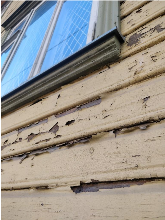
Pilt 20. Tänavapoolse fassaadi laudise irdunud kohad. Pilt 21. Katuseräästa seisukord on hea.
