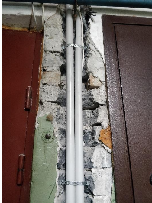
Pilt 47. Vaade esimesele korrusele. Pilt 48. Trepikoja seinad on parandamata jäetud torude vahetuse järel.
