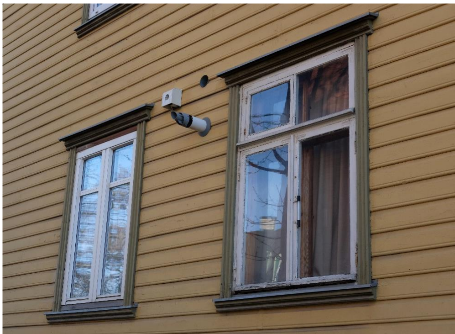
Pilt 37. Uus puitaken (vasakul) ja vana säilinud aken (paremal).
