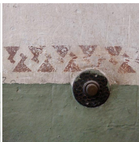
Pilt 60. Vana lubikrohvi alt paistab trahvarett. Pilt 61. Vana vasest uksekell.
