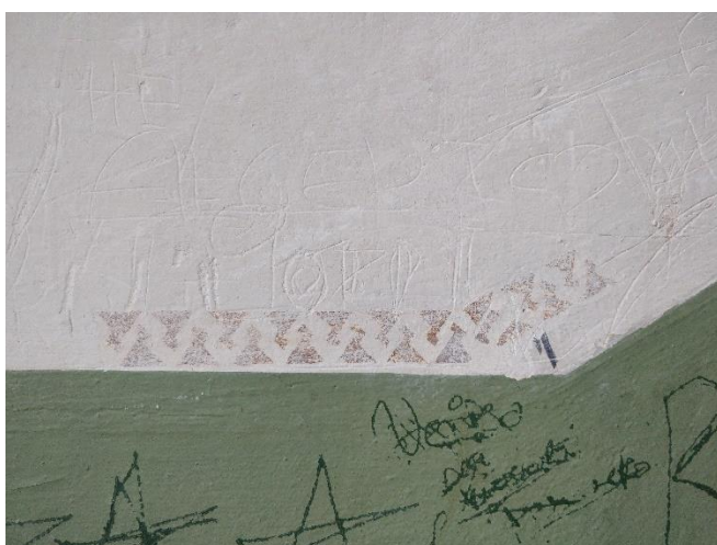
Pilt 60. Vana lubikrohvi alt paistab trahvarett. Pilt 61. Vana vasest uksekell.
