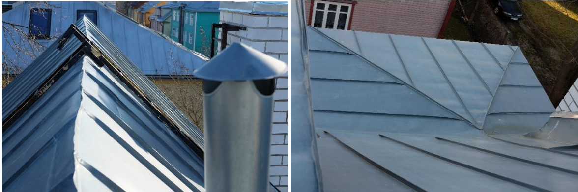
Pilt 42. Pilt 43. Katus on heas seisukorras. Aastal 2005 kaeti maja katus uue valtsplekist kattega.
