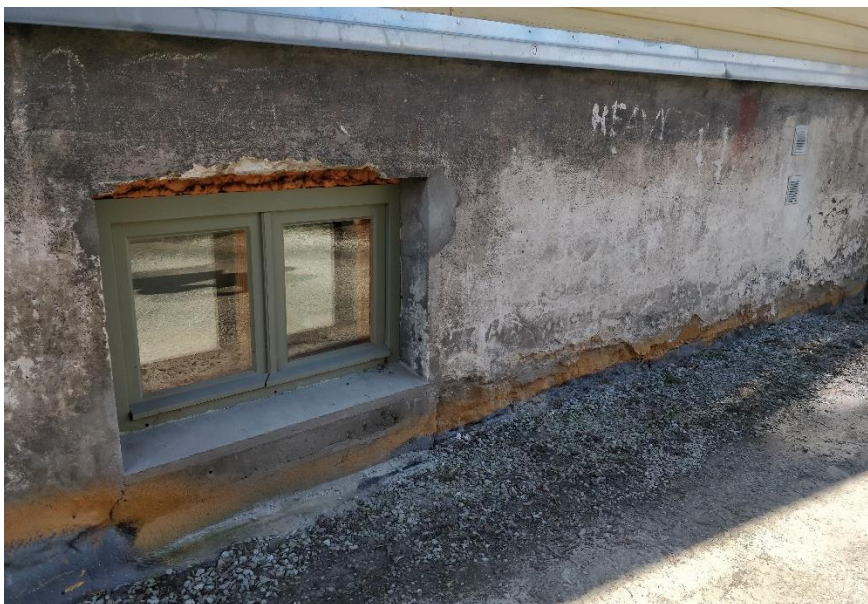
Pilt 28. Põhjapoolse fassaadi sokkel.
