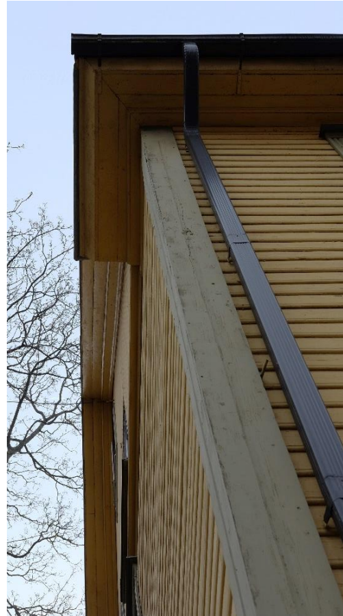
Pilt 20. Tänavapoolse fassaadi laudise irdunud kohad. Pilt 21. Katuseräästa seisukord on hea.
