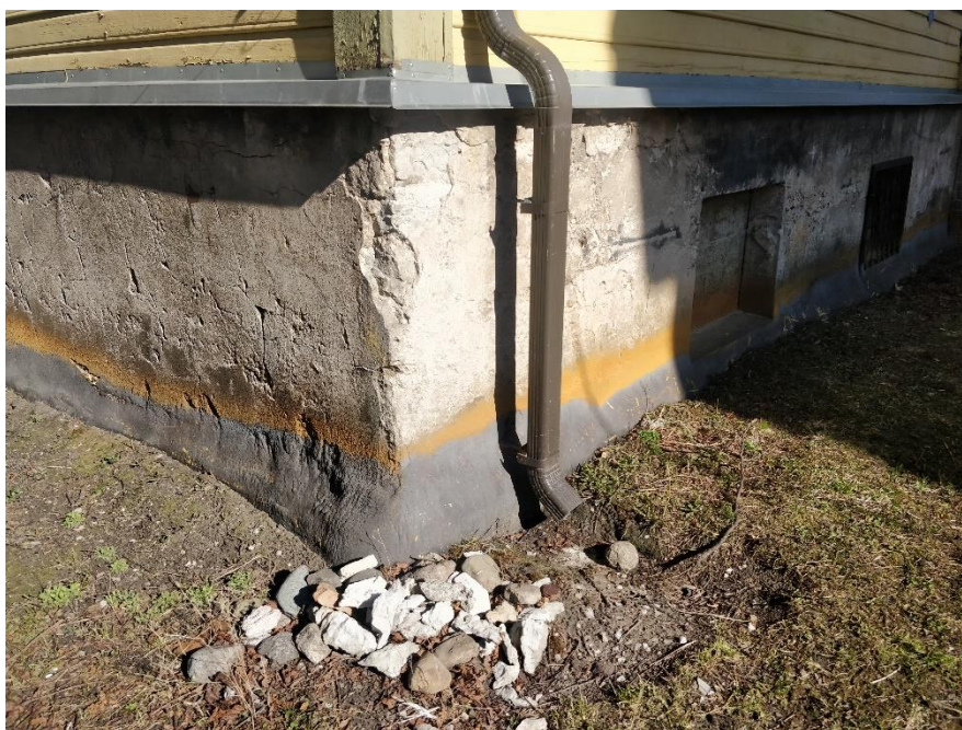
Pilt 34. Hoovi poolt pole vesi eemale juhitud.
