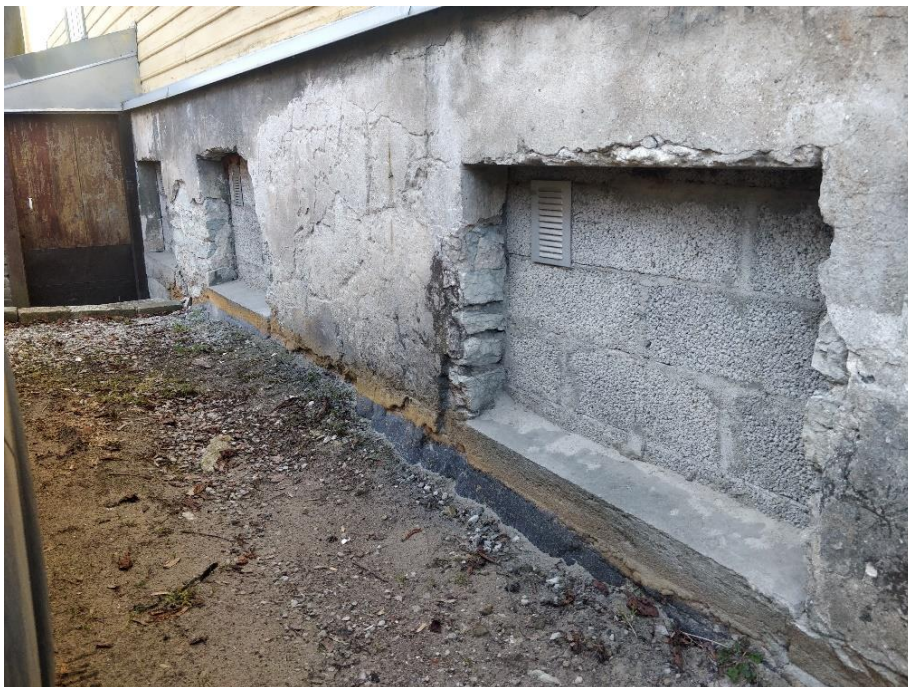
Pilt 29. Idapoolse fassaadi sokkel.
