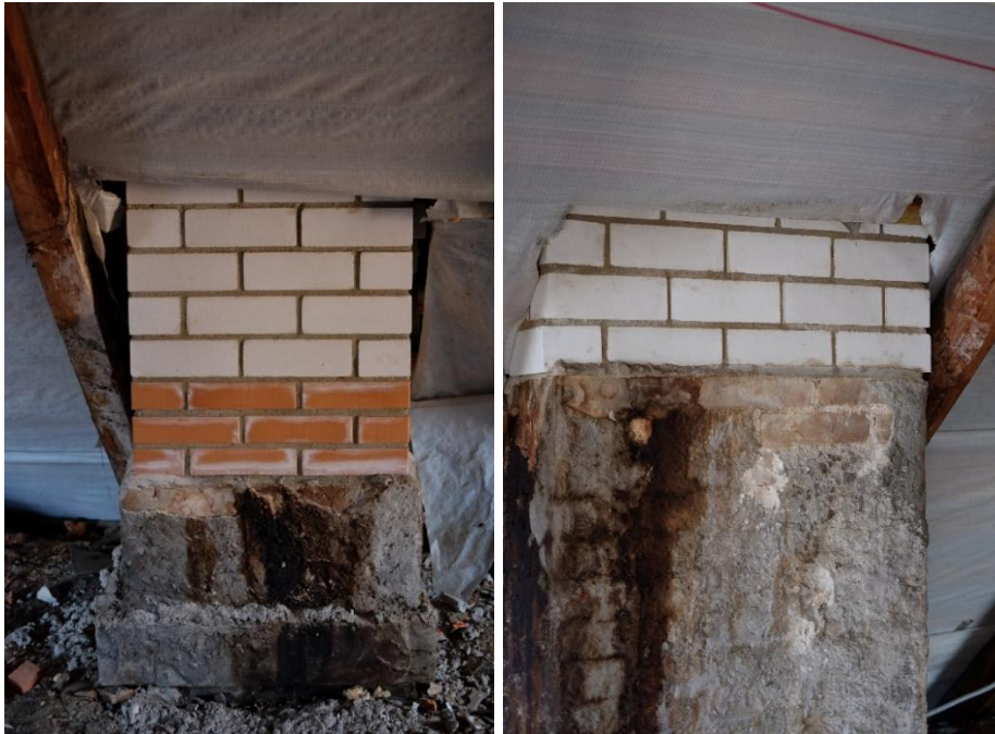
Pilt 39. Pilt 40. Korstna pööningul paiknev lõõri välissein, kus ühineb uus korstnapits vanaga.
