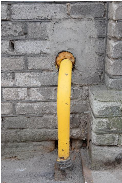
Pilt 26. Lohakalt parandatud auk toru paigaldusest fassaadi esiküljel.
