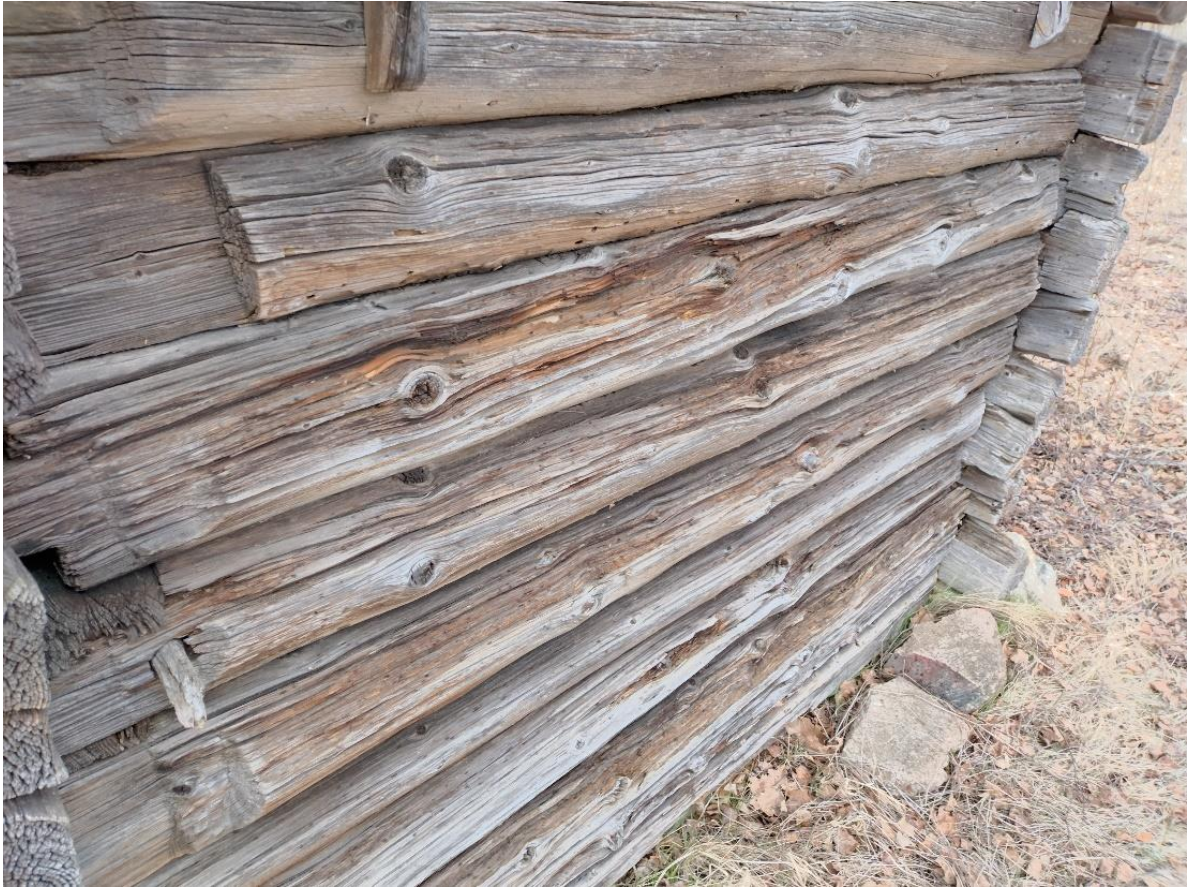
Foto 28. Kahjustunud palgid sauna lõunaseinas. Paremäl näha kivid, millele saun arvatavasti algselt toetunud Allikas: autori erakogu.
