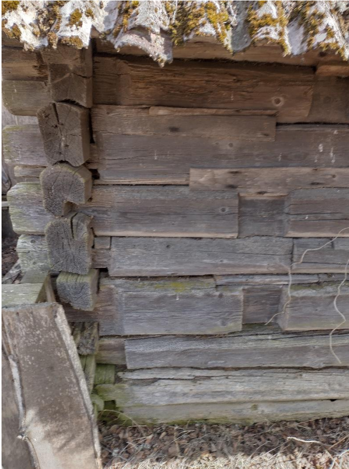
Foto 26. Vaade sauna palkseina nurgalahendusele ning varasematele palkide sisselõigetele. Allikas: autori erakogu.
