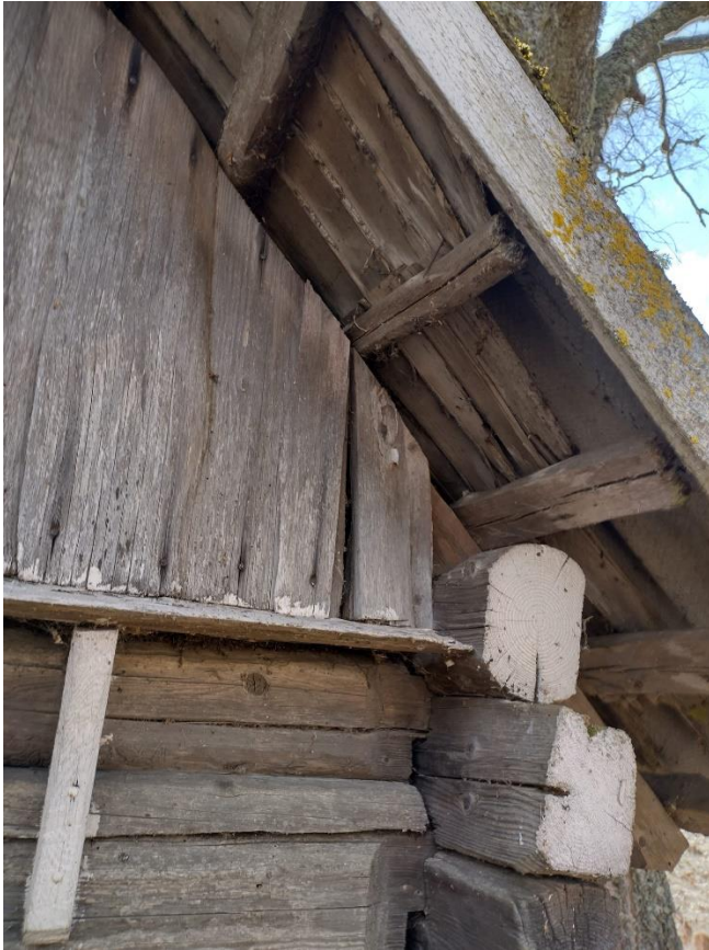
Foto 18. Uuema katusekatte all on osaliselt säilinud algne laastukatus. Allikas: autori erakogu.
