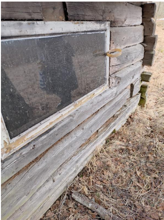
Foto 25. Sauna lääneseinas asuv varasemast suurem aken. Allosas näha palgi kahjustus. Allikas: autori erakogu.
