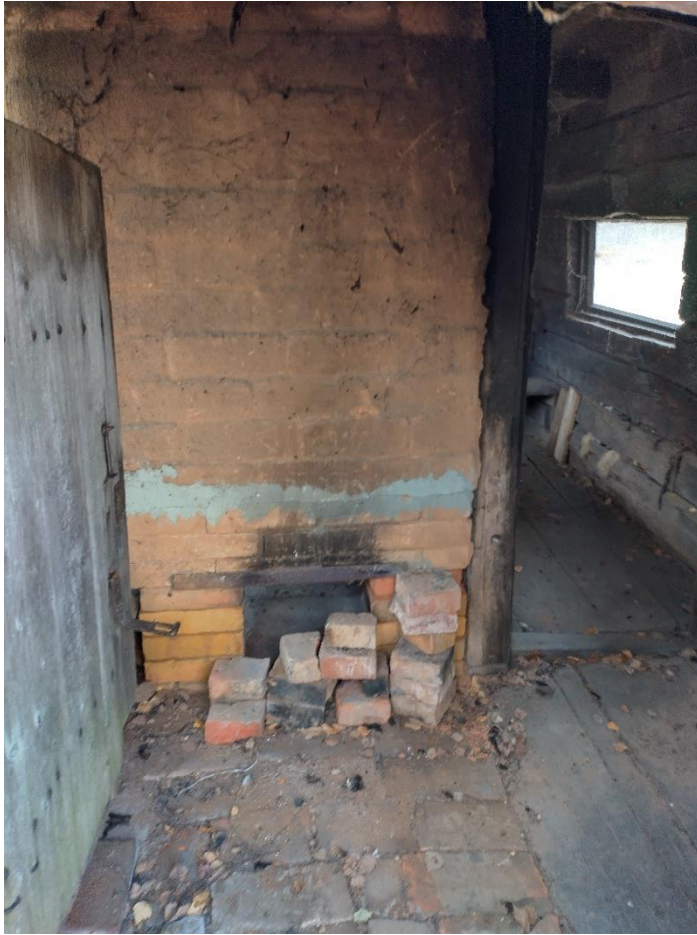
Foto 22. Sauna eesruum koos tellisahju ja osalise tellispõrandaga. Paremäl kuumakahjustusega tugipost. Allikas: autori erakogu.
