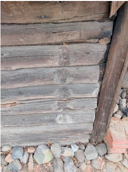
Foto 27. Sauna idaseina palkides olevad varasemad sisselõiked. Allikas: autori erakogu.
