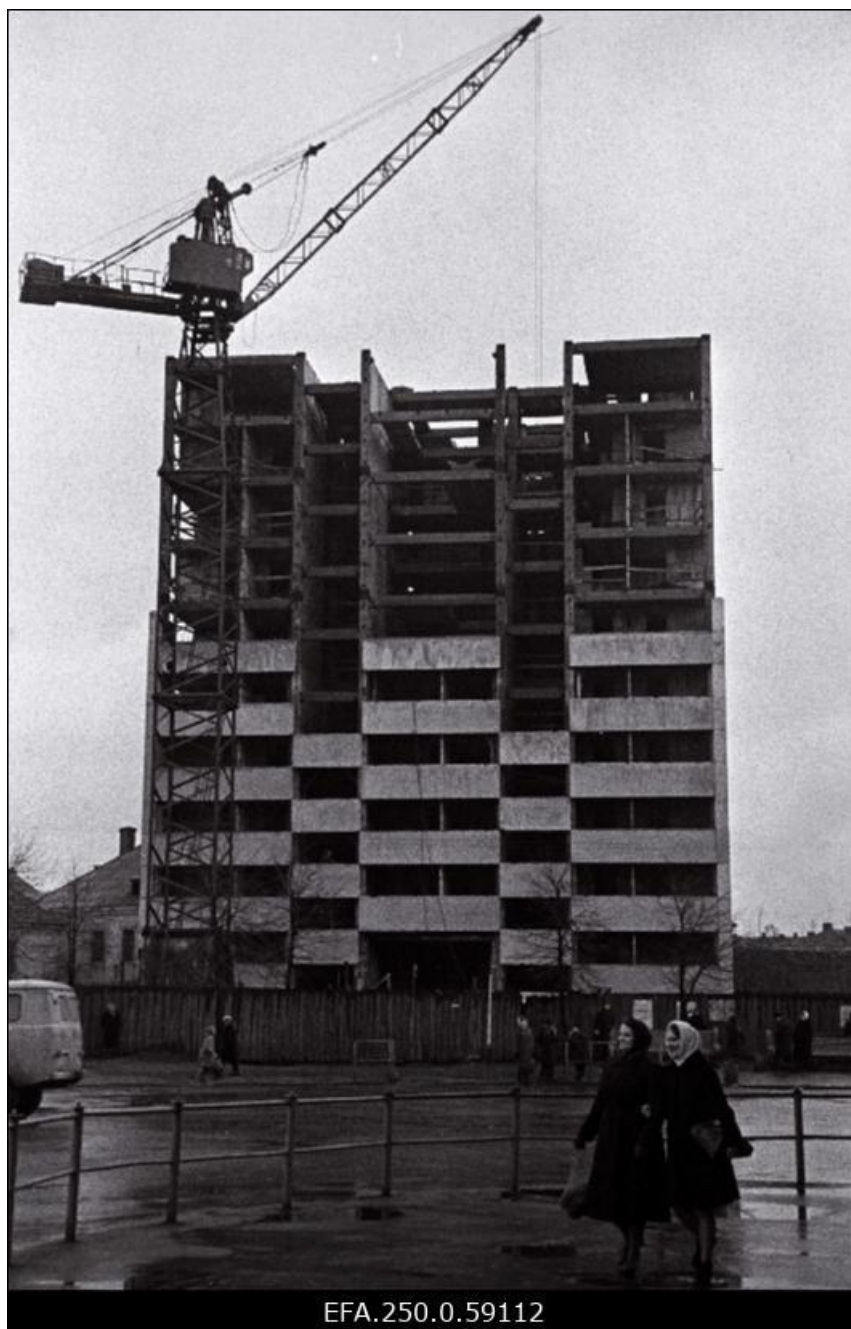
Illustratsioon nr 32. Vaade 12- korruselise elamu ehitusele Narvas. 52
