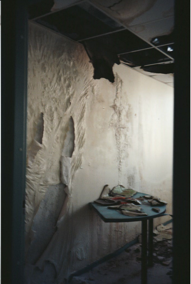
Foto 9-12: vasakult paremale: Kohtualuse boksi pingil näha õrn hallituse kiht. 1.korruse dokumentivastuvõtuboksis kiusab sadevesi riplage. 1.korruse tööruumide vahelisse koridori on suure sadevee tilkumise tõttu paigaldatud vannid. 2.korruse kohtusaali abiruumi veekahjustused.
