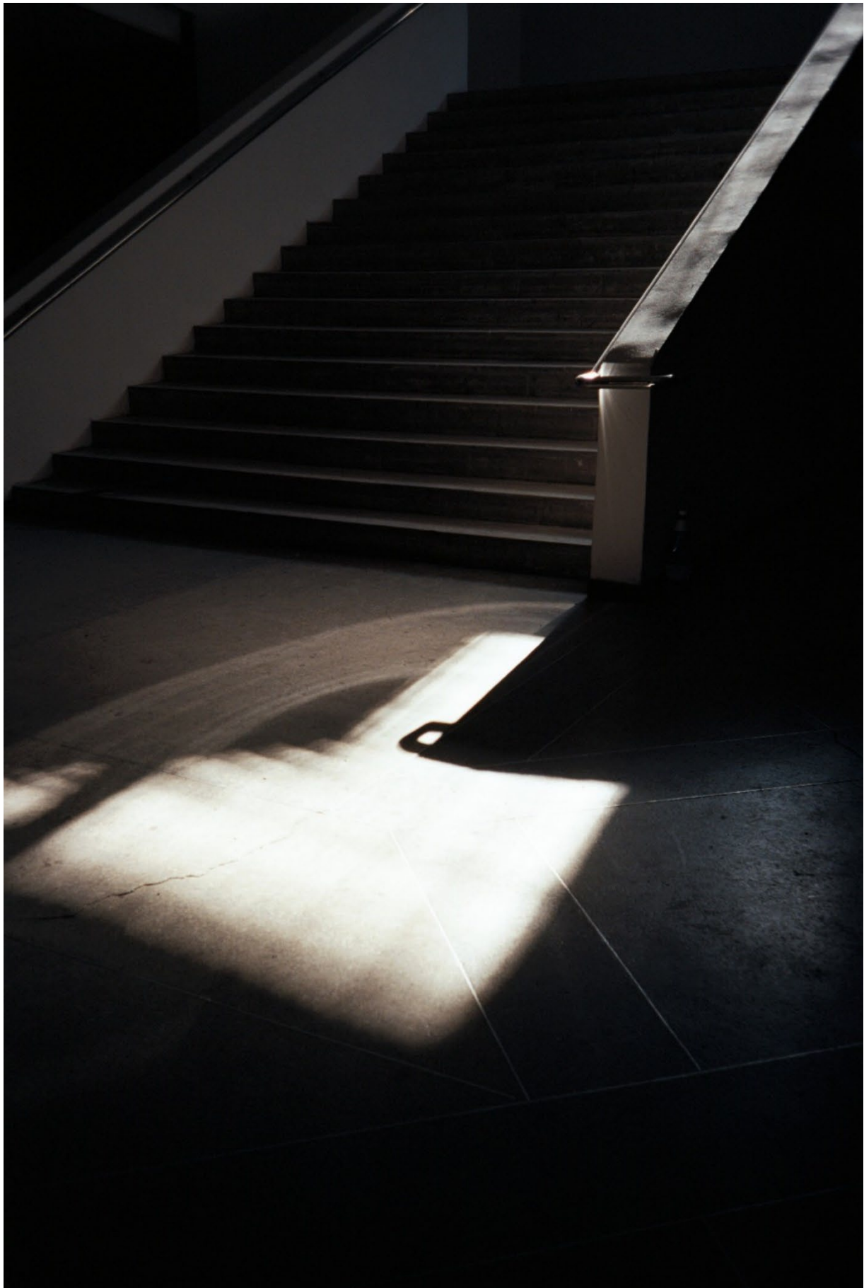
Foto 18: Vestibüülis terratsopõranda alumiiniumist vaheliistud helkimas.
