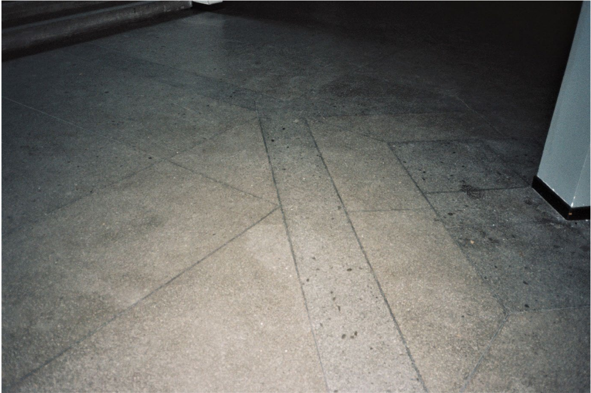
Foto 17: Terratsopõranda tänapäevane seis. Üleüldiselt on põrand hästi vastu pidanud.
