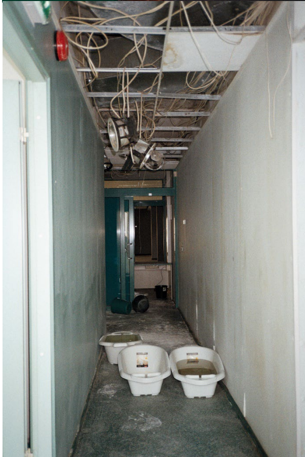
Foto 9-12: vasakult paremale: Kohtualuse boksi pingil näha õrn hallituse kiht. 1.korruse dokumentivastuvõtuboksis kiusab sadevesi riplage. 1.korruse tööruumide vahelisse koridori on suure sadevee tilkumise tõttu paigaldatud vannid. 2.korruse kohtusaali abiruumi veekahjustused.
