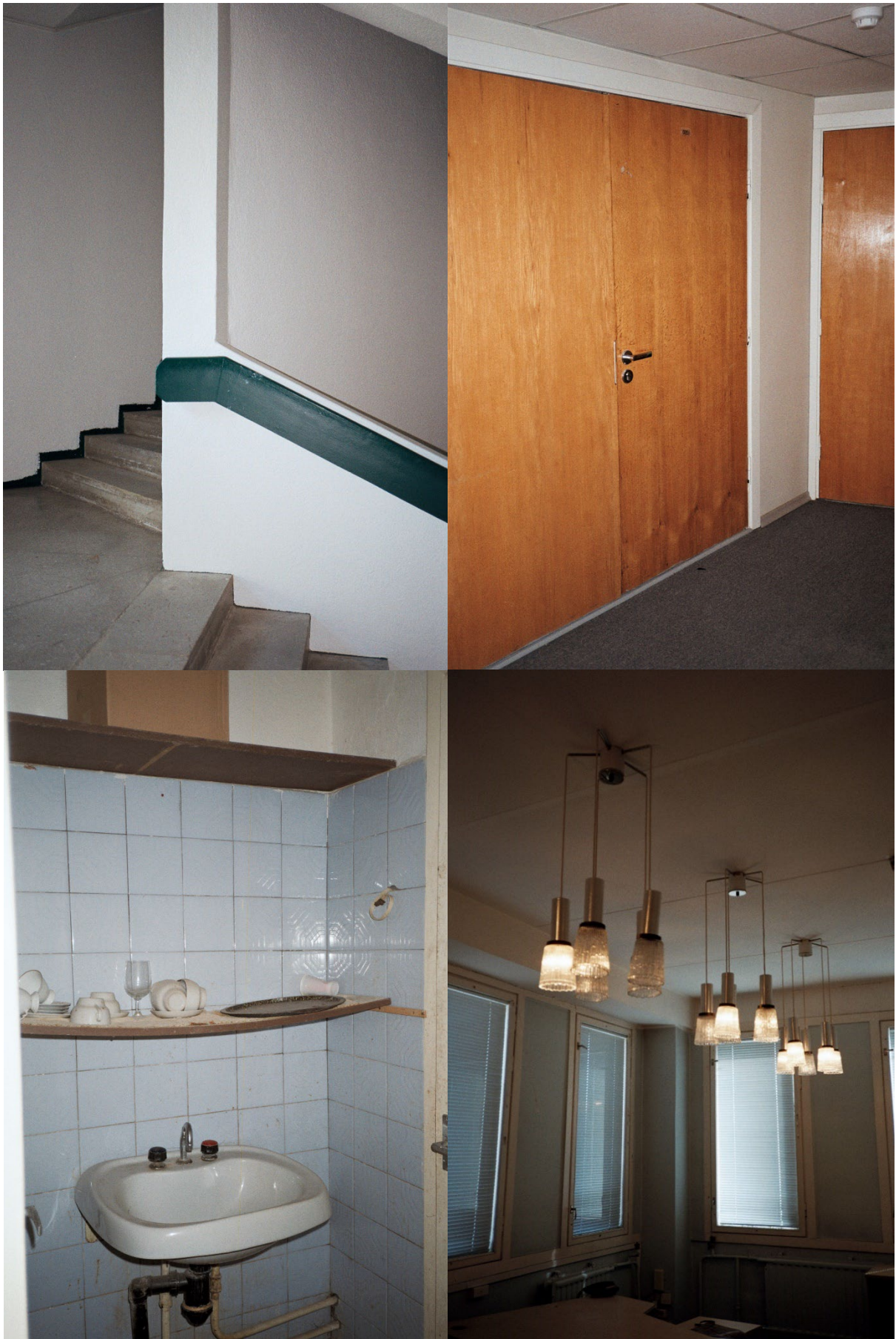
Foto 29-32: vasakult paremale: 2-4.korrusel on säilinud ka puidust trepi käepidemed (algne viimistlus naturaalne lakitud puit). Kohtusaalides on originaalkujul (ja kohati ka viimistlusega) säilinud vineerist uksed. Suure kohtusaali ühes abiruumis näeb retro tualeti sanitaarkeraamikat. 3.korruse kabinetis leiduvad huvitavad nõukogudeaegsed rippvalgustid (mudel ja tootja kinnitamata).
