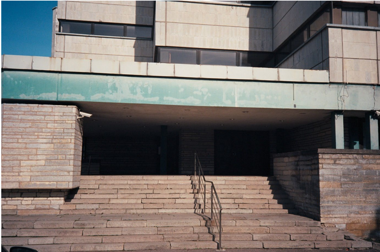
Foto 2: Kohtuhoone peasissepääs. Paremalt on näha asukohta, kus varem oli skulptuur Justitia. Terastorst käepuud on lisatud 1996. aasta rekonstrueerimisprojekti jooksul.
