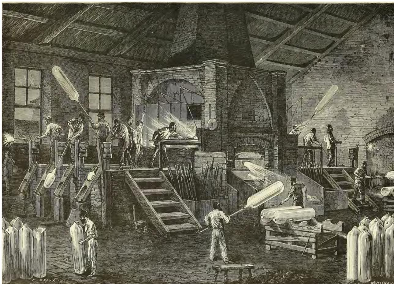
Fig. 20. — Fabrication des manchons de verre destinés à former des carreaux de vitres. Vue prise dans une des fabriques d'Aniche (Nord).
