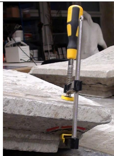
Liimitud detailide fikseerimine pitskruviga
