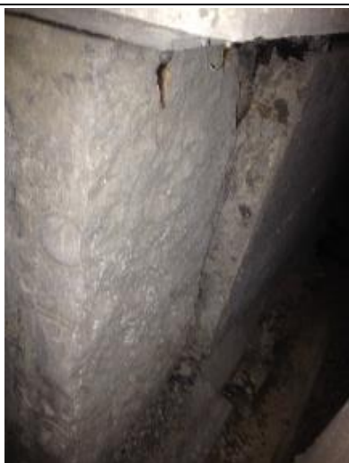
Kirdenurga murdunud pilaster-plaadi algasukoht põhjaseina poolt vaadatuna
