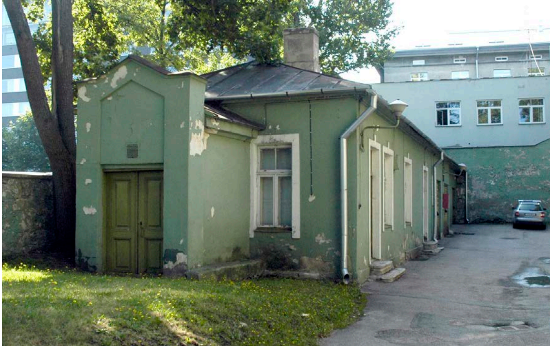
Foto 25: Vaade majandushoone otsafassaadile
