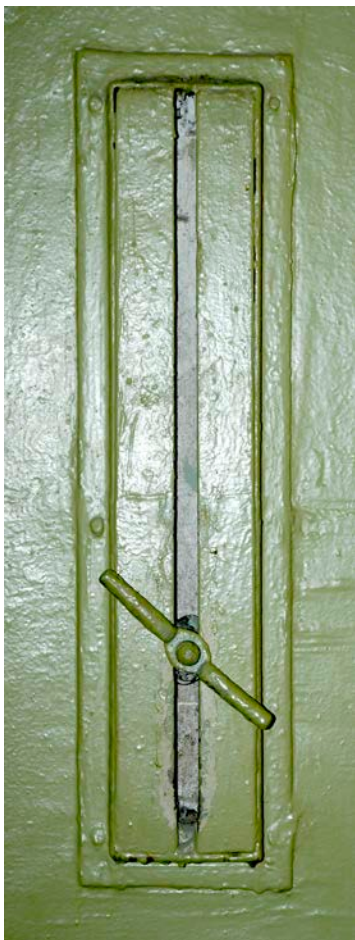
Foto 124, 125: Õhkküttesüsteemi reguleerimissüsteem keldrikorrusel
