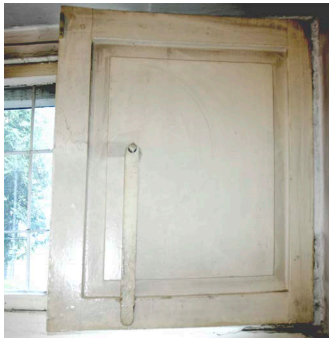
Foto 96: Aknaluugid keldriaknal, ruumis nr 02
