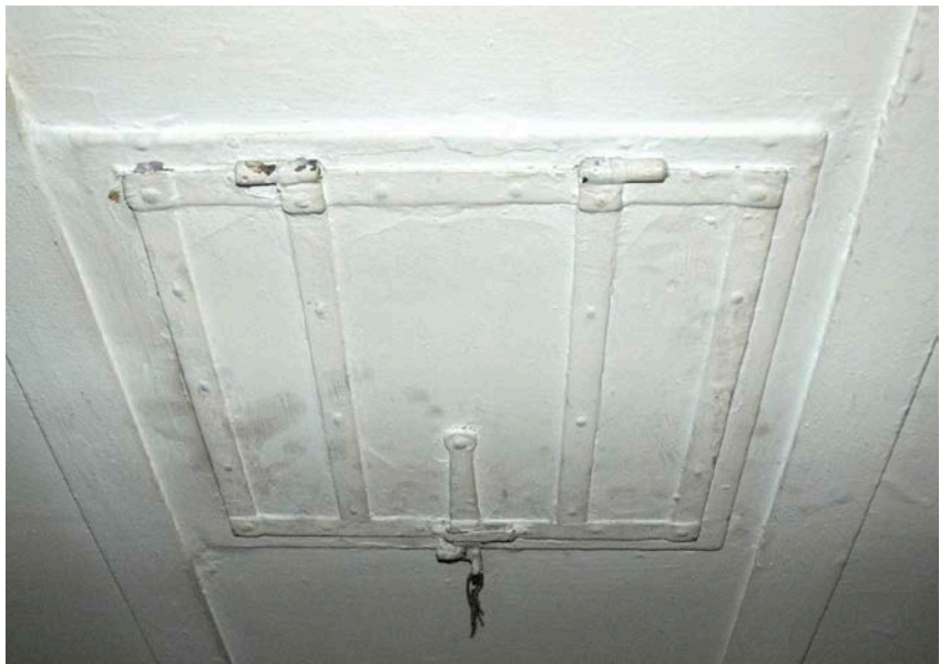
Foto 124, 125: Õhkküttesüsteemi reguleerimissüsteem keldrikorrusel
