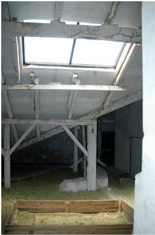
Foto 40: Poolenisti väljaehitatud katuseaken pööningul
