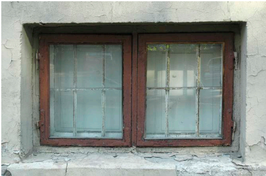
Foto 91: Keldriaken peahoone vanemas osas
