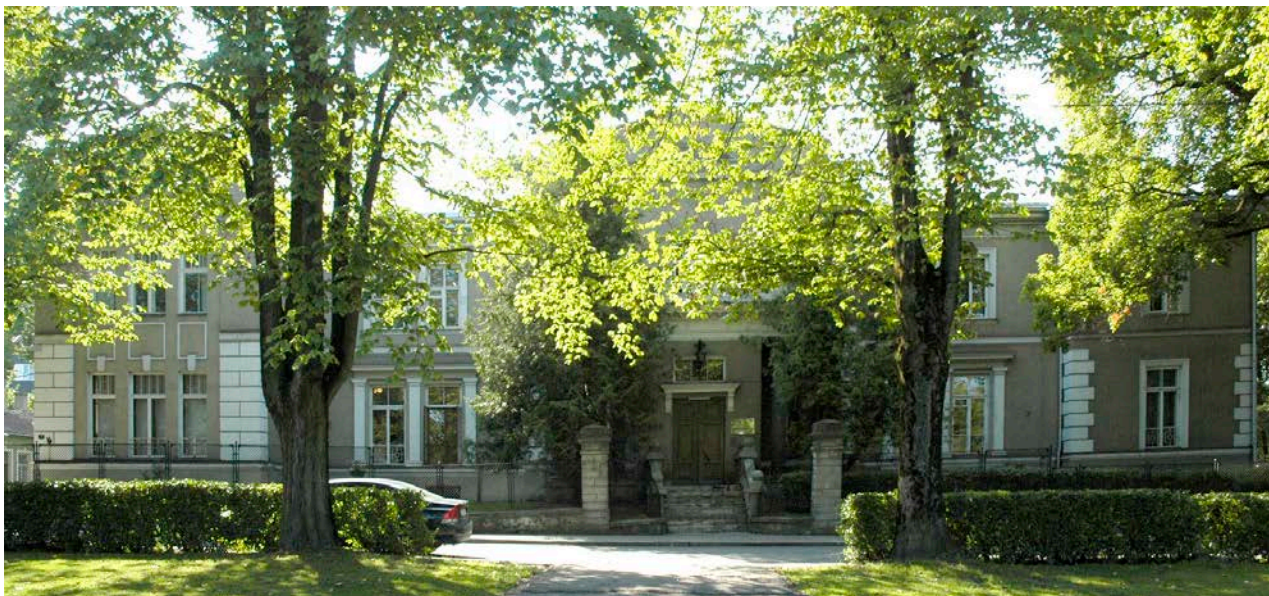
Foto 1: Vaade Wismari 7 peahoone põhjafassaadile
