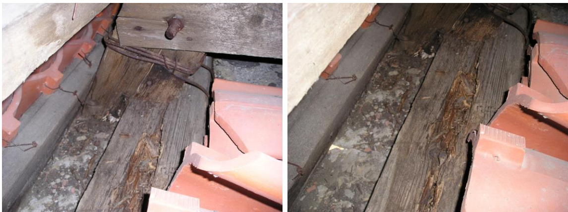
Foto 22. Lõunakülje pehkinud müürlatt (lääne osas).
