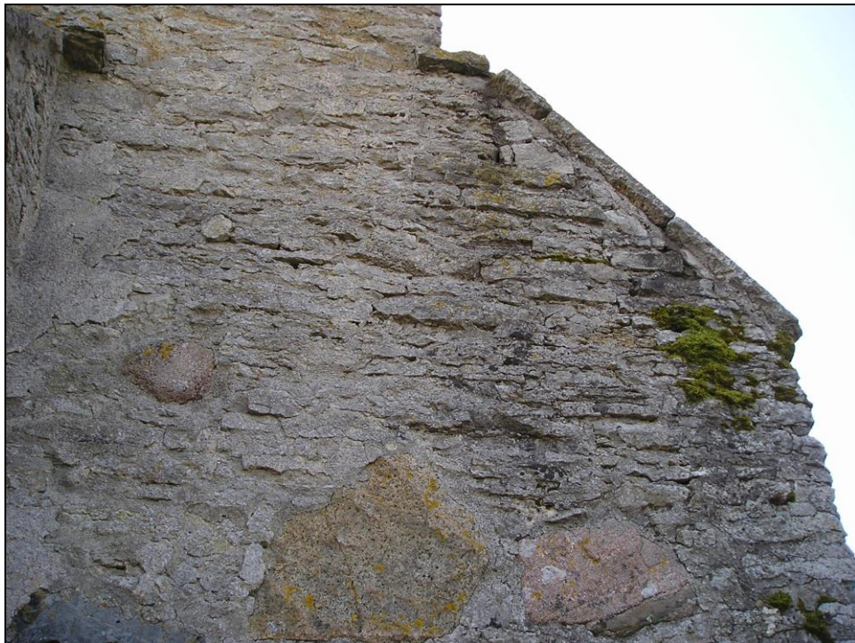
Foto 16. Kontraforss kirdenurgas. Üleval on näha vee sattumine müüri.
