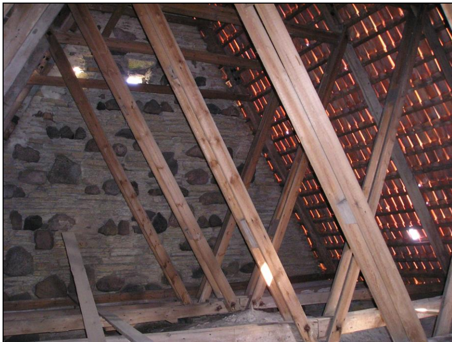
Foto 20. Pööning, katusekonstruktsioon. Vaade idaviilule.
