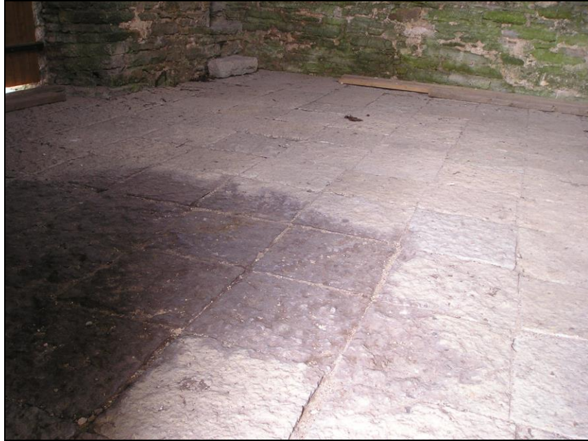
Foto 17. Kabeli põrand (lõunakülg)
