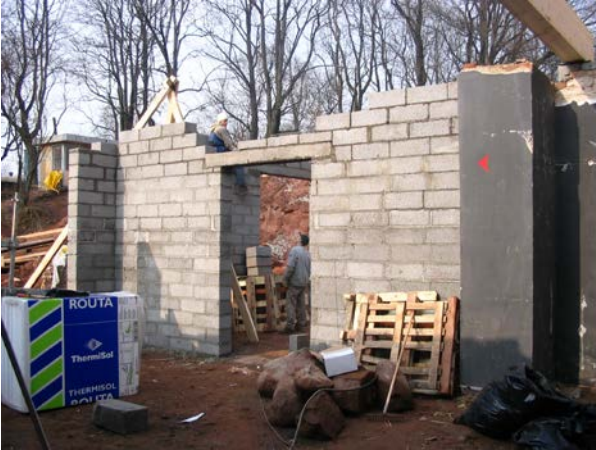
34, säilinud vana seiniosa ja uus FIBOst sein
