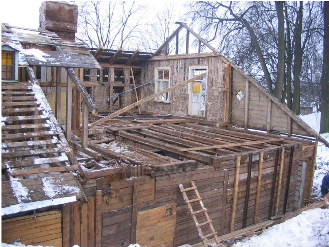
Üldvaade avatud konstruktsioonidest.
