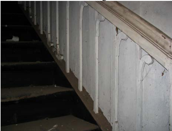
23, säilinud algupäraseid piirdepulgad esimesel trepil
