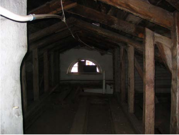
22, vaade ruumi nr. 318, kagu suunas
