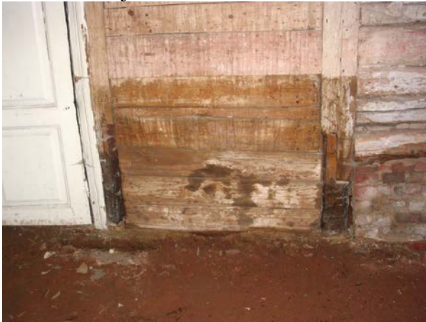
30, tapitud niiskuse poolt kahjustatud palgiots ruumis nr. 207
