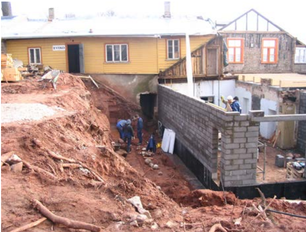
33, uue välisseina ehitamine hoone idaküljel
