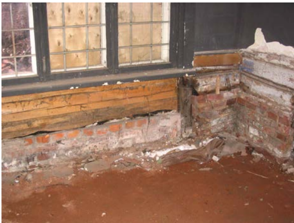
31, seinakonstruktsioon saalis, ruum nr. 208
