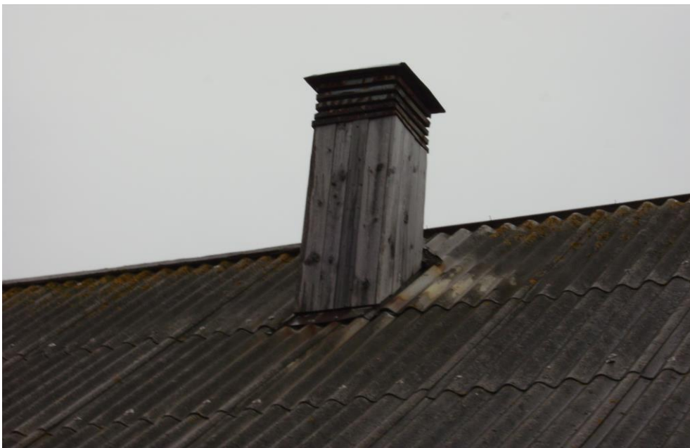
Ventilatsiooni korsten, puidust 2007 a.
