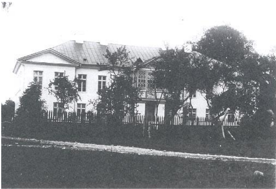
Joon. 24. Vaade Vaimõisa mõisa peahoonele lõunast (Jaan Vali fotokogu). NB! , hoone plekk-katus, veranda aknad, istutatud viljapuud ja lippaed
