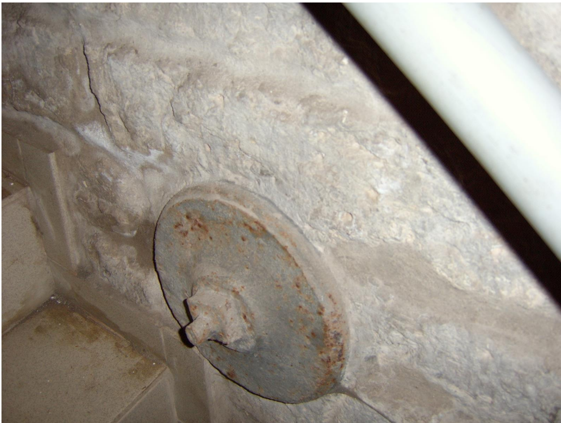
Joonis 13. Trepikoja seinad paekividest, seotud naabrihoonega suurte ankrudega.
