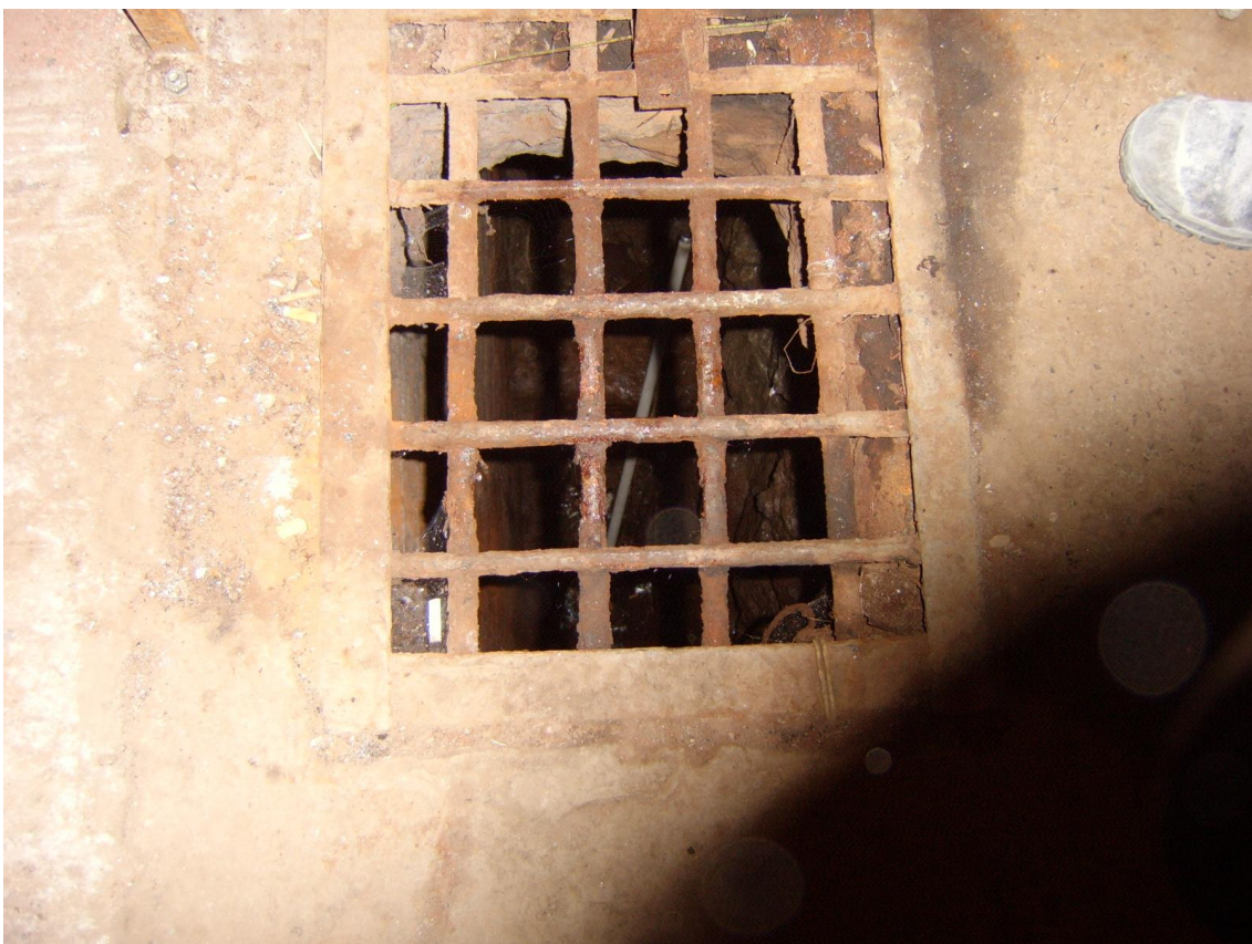
Joonis 17. 2. korruse veevastuvõttur, seotud kanaliga põhjavee ja vihmavee kogumiseks.
