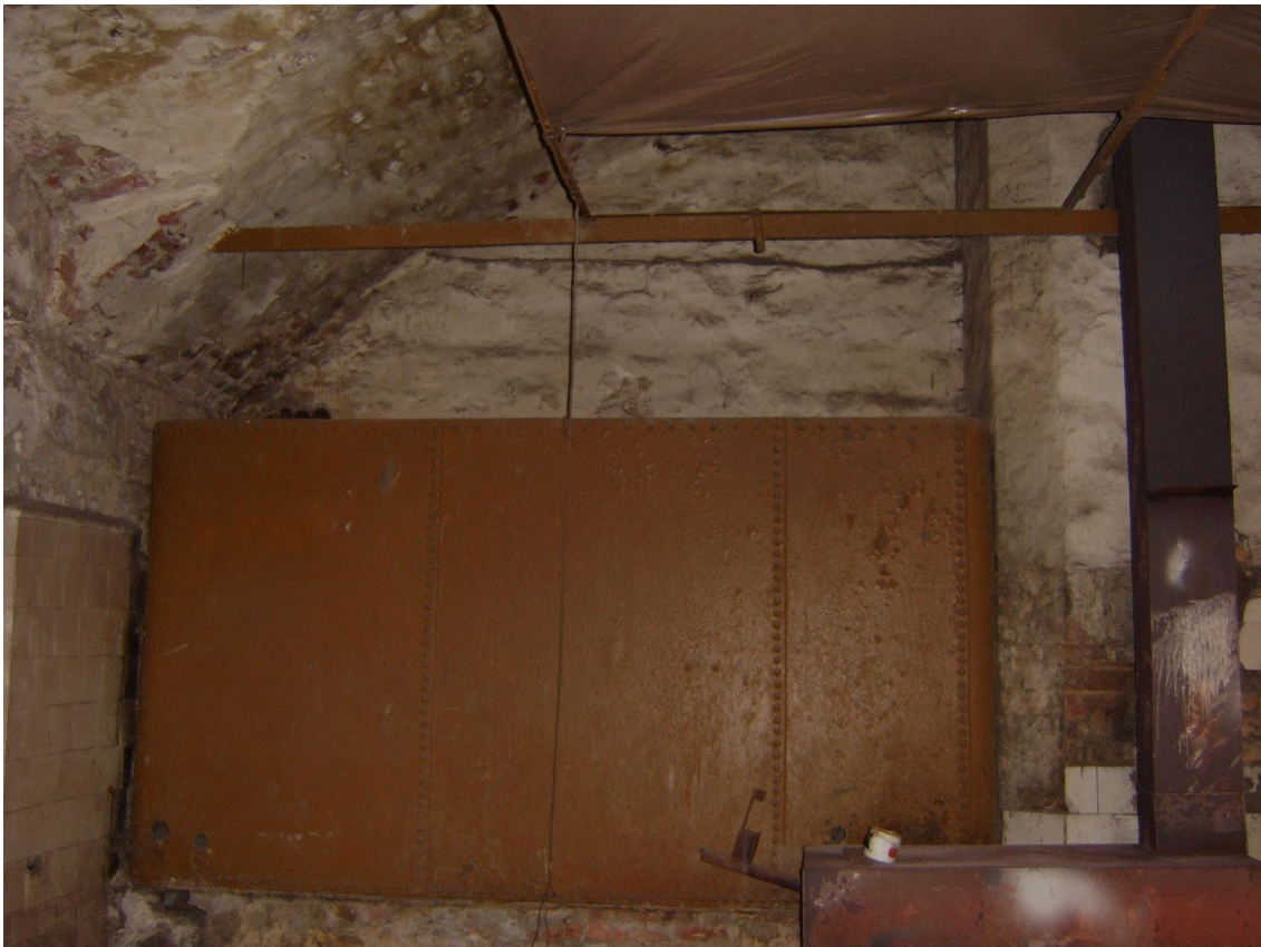
Joonis 16. Metallpaak vee hoidmiseks hoone 1. korrusel (endises pesuruumis)
