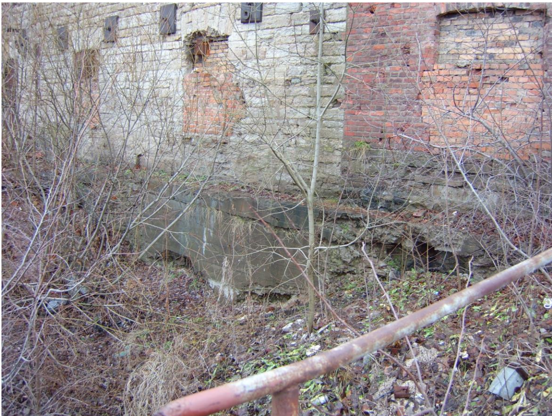
Joonis 19. Kiviseintega kanal hoone jõepoolse fassaadi piki.
