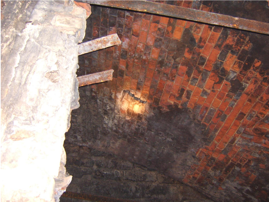
Joonis 12. Mitteekspluateeritavate ruumide võlvvahelaed savitellisest.
