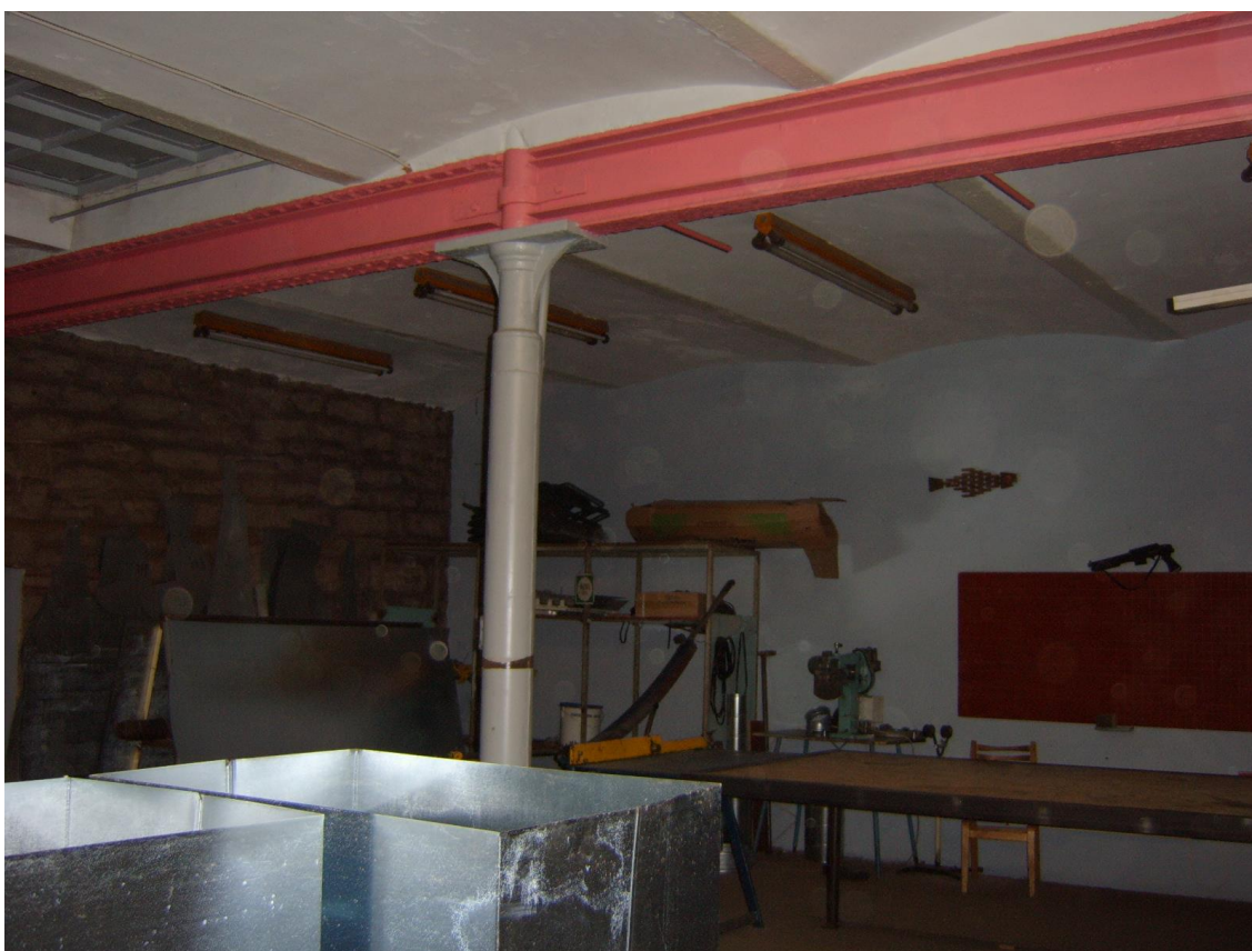
Joonis 11. Hoone karkass malmpostide ja I-kujuliste metalltaladega, mille peale toetuvad võlvvahelaed savitellistest.
