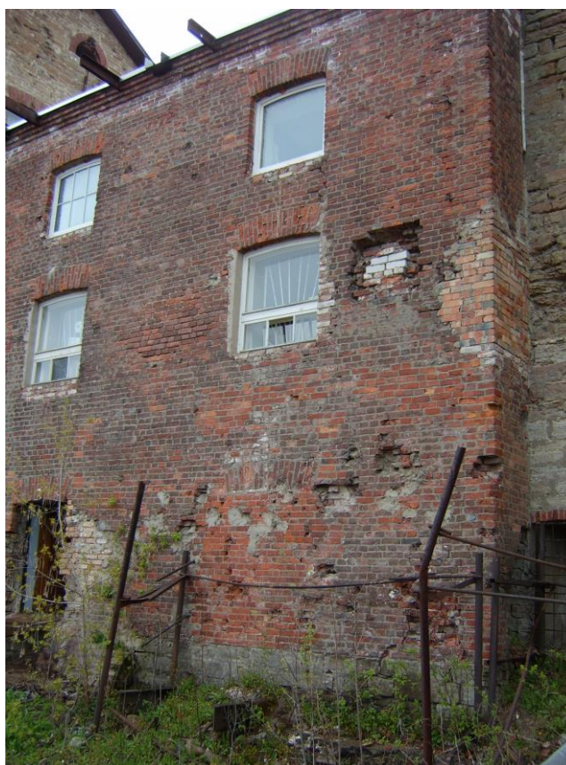
Joonis 15. Hoone jõepoolse fassaadi kahjustused.
