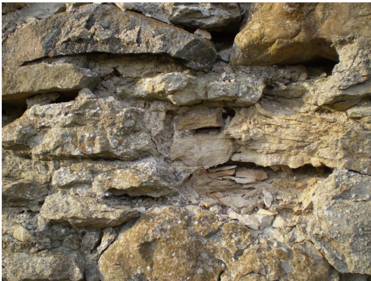
Lähivaade Partsi tuuleveski väliseinast, kus on näha kahte põhilist paekiviliiki, mida on kasutatud tuuliku müüritise ehitamisel. [12]
