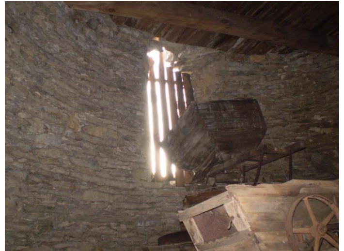
Tuuleveski sisevaated, kus on näha, et paekivi müüritise seisukord on seespool suhteliselt hea. [9];[10]
