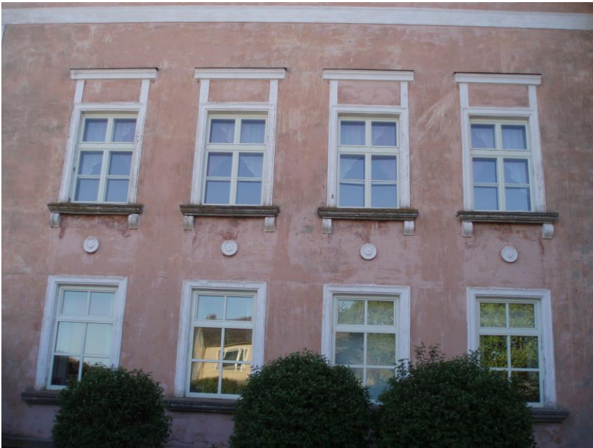
Foto nr 11 (I korrusel puitaluiniiumaknad ja II korrusel uued puitaknad)
