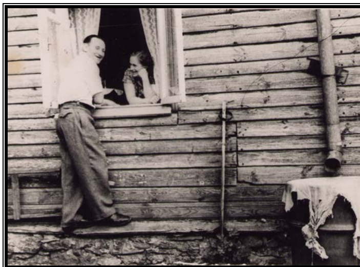
Vaade hoovi poolsele fassaadile
