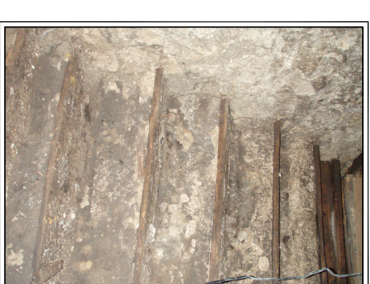
Foto nr. 87 Keldri pakkest tepp, mille all on kaetud puitlaega.
