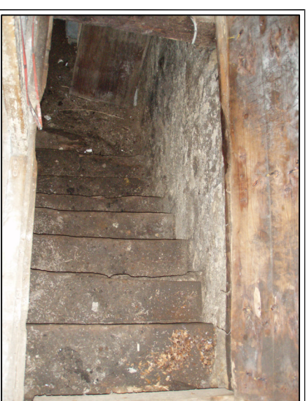
Foto nr. 56 Keldrise viivad astmed, mis on kaetud puiduga.
