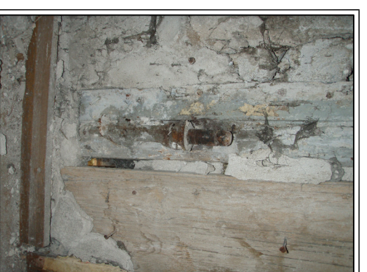
Foto nr. 42 Rüttili tänava poolse välisukse algne alumine hing.
