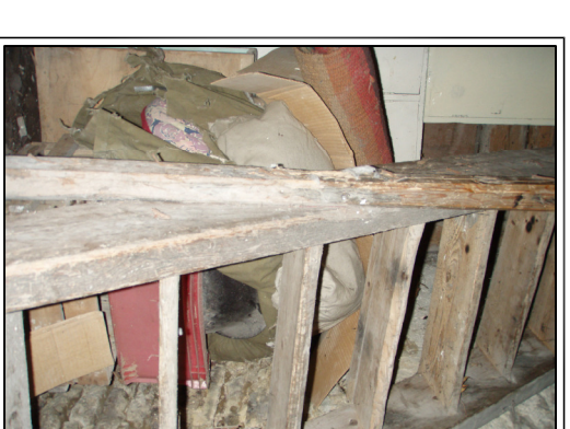
Foto nr. 58 Põõningute viiv puidust trepp.
