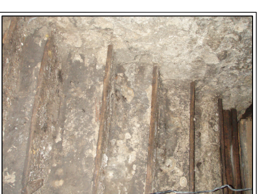
Foto nr. 57 Keldri paekivist trepp, mille astmed on kaetud puiduga.
