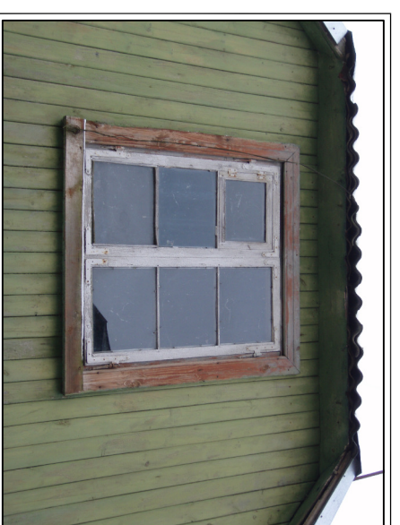
Foto nr. 47 Algne aken, millele on lisatud ajalihtide tuletusaken. Ainu sõnades ei ole algse.
