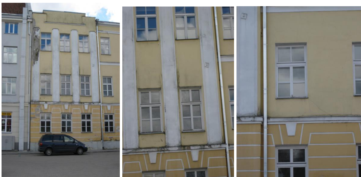
Foto 2. Vaated jõe poolt ( rikked , tõmbide kinnitised)
