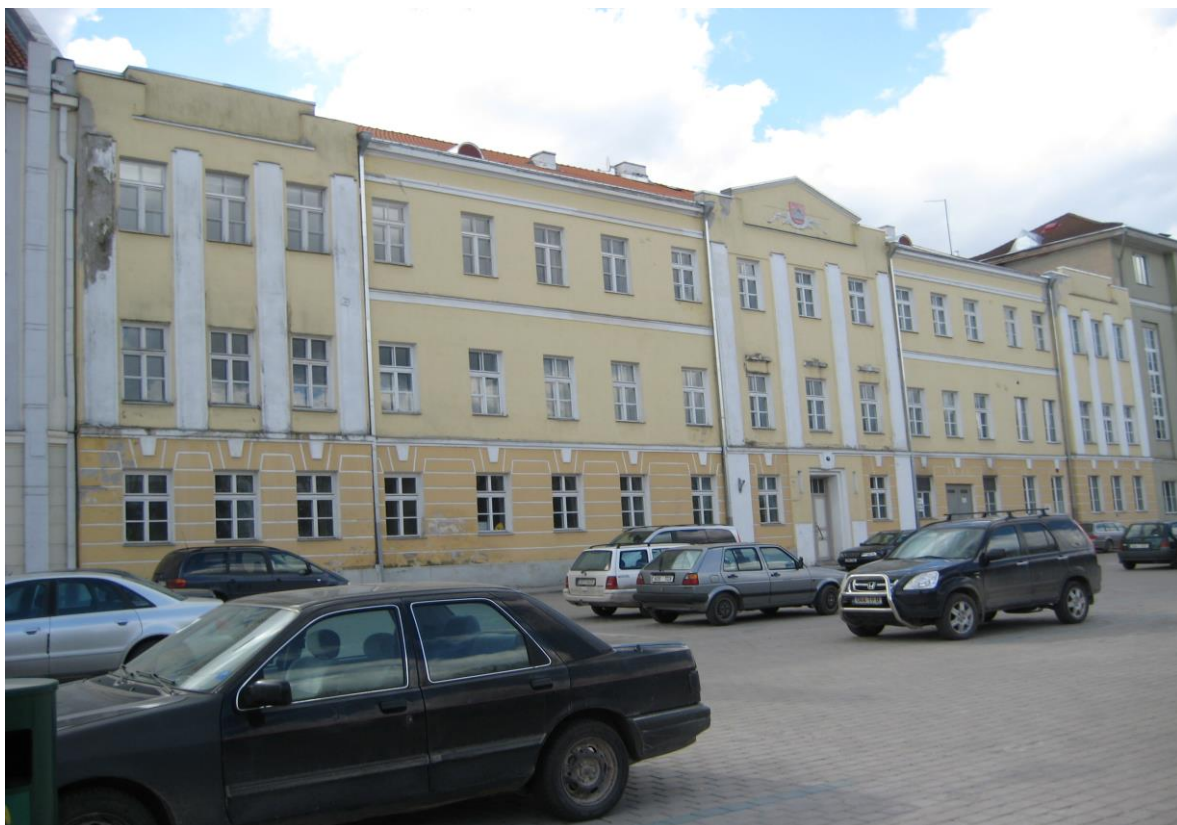
Foto 1. Raamatukogu hoone vaade jõe poolt.
