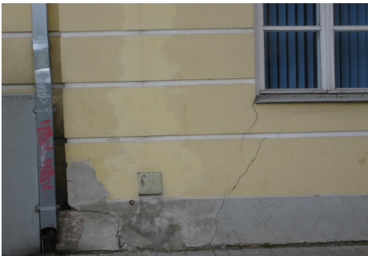
Foto 11. Vaade Kompanii tänavalt (mõrad, tõmbi kinnitus, reeper)
