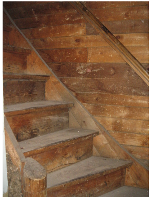
76. Pööningule viiv trepp.
