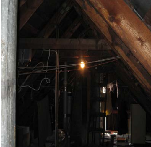
5. Vaade katusealusele O-suunast.
