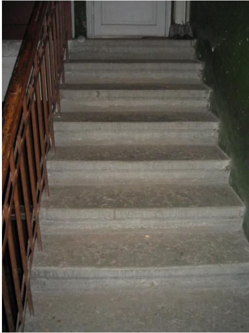
77. Kivitrepp esimesele korrusele.
