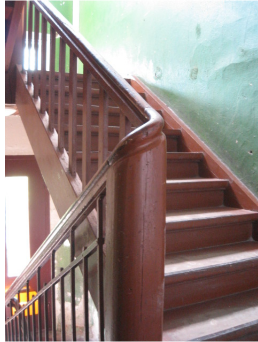
74. Puidust trepp 2.korrusele.
