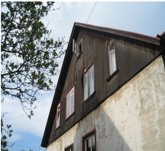
46. Vaade W-fassaadi 2.korruse akendele.
