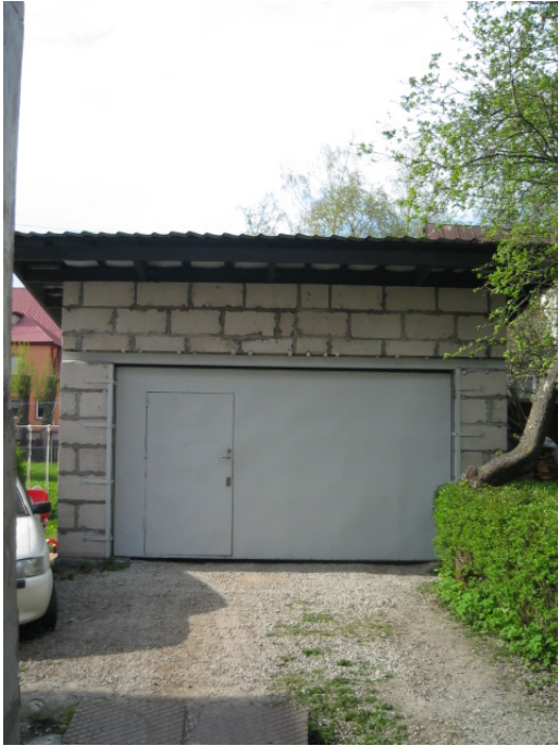
4. Vaade põhjaosas asuvale garaažile.
