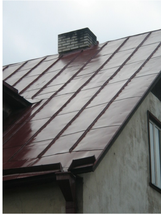
6. Vaade katusele SE-suunast.
