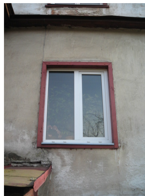
31. Vasak NW-1.korruse aken (PVC).
