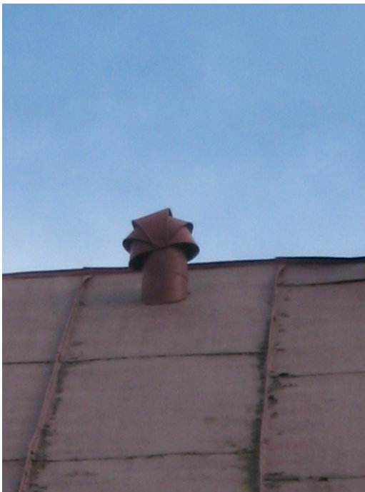
7. Vaade katusel olevale õhutustorule.
