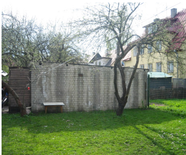
3. Vaade loodeosas asuvale garaažile.
