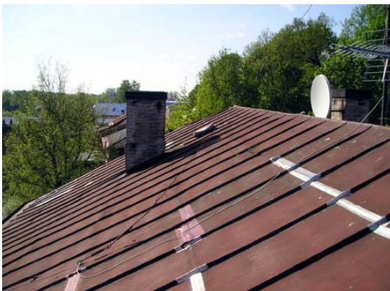
Pilt 16. Vaade hoone põhiosa ajutiselt lapitud valtsplekk-katusele
