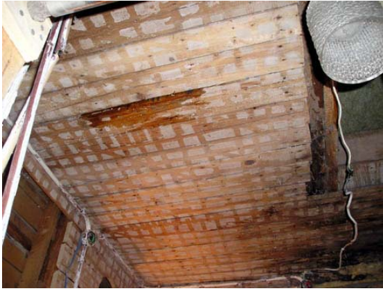
Pilt 37. Näha on osaliselt mädanenud laudis laes (pildil all paremal) ja keskosas katuseakna paigaldamise ajal läbi sadanud vesi
