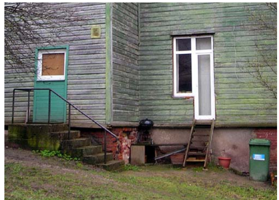
Pilt 15. Vaade hoone põhiosa lääneservas likvideeritud sissepääsule ja uuele kummalise kujundusega plastaken-uksele
