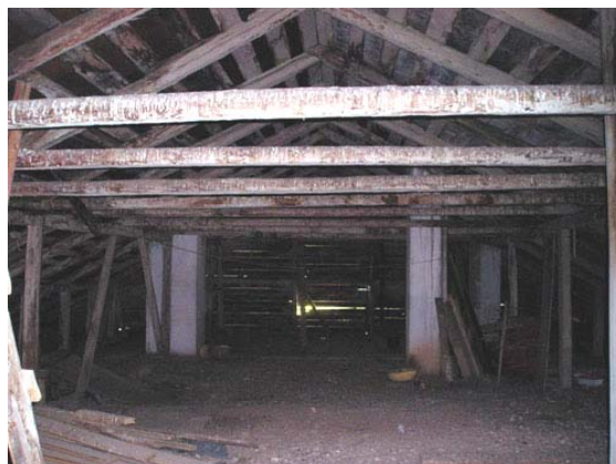
Pilt 8. Jaama tn 27 pööning ja sarikatesüsteem, näha on ka hõre voodrilaudis
