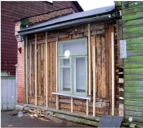
Pilt 22. Korter 10 tänavapoolne sein, näha on erinevatest ajastutest pärit palke
