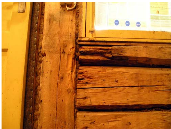
Pilt 41. Hoovipoolse akna all niiskusest osaliselt pehkinud palgid
