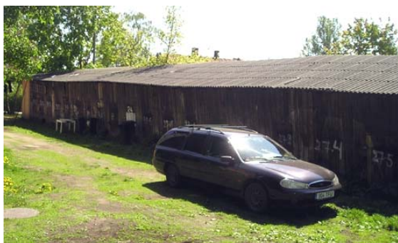
Pilt 43. Jaama tn 27,31 krundil asuv puidust puukuur
