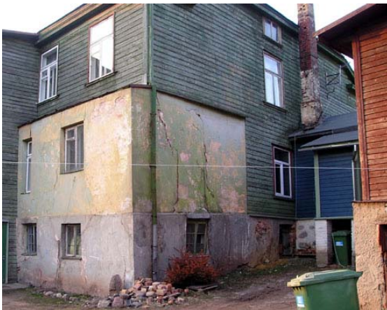
Pilt 20. Esiplaanil on Jaama tn 27 hoone kivisein aastal 2004
