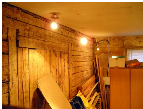
Pilt 29. Korteri 10 siseseinas uuemate palkidega suletud kunagine uksekoht
