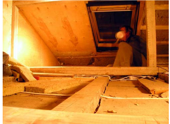
Pilt 25. Ümberehitustööd põõningul. Näha on laetalad ning äsja paigaldatud katusesoojustus, sisepindade vineerkate ja katuseaken
