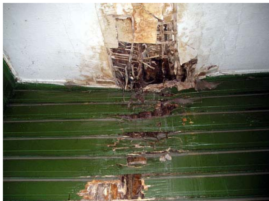
Pilt 17. Vaade hoone veekahjustuste tõttu läbivajunud laele
