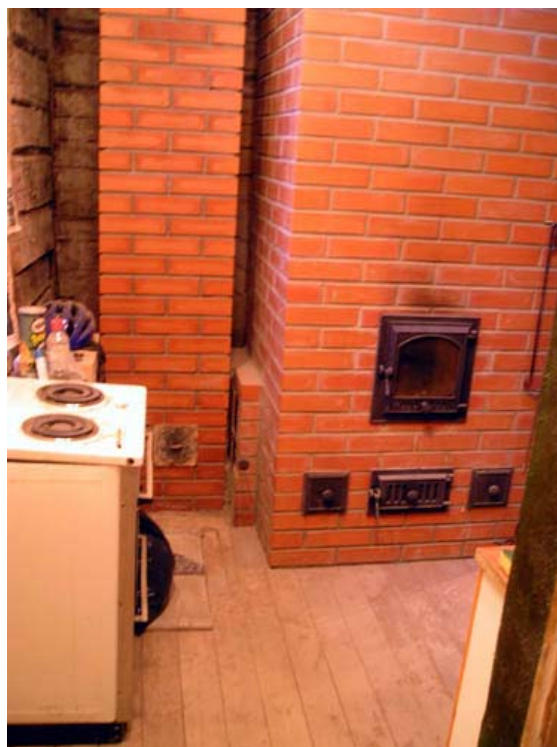
Pilt 34. Uus ahi koos ventilatsioonilõõrita korstnaga, mis on mõeldud vaid ahju tarbeks
