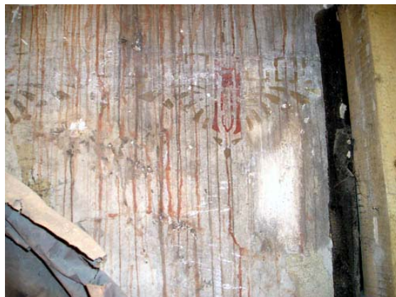
Pilt 42. Tulemüüri toapoolne sein WC-s – näha on krohvitud pinnale kantud mustrid, mis on niiskuse tõttu osaliselt laiali valgunud
