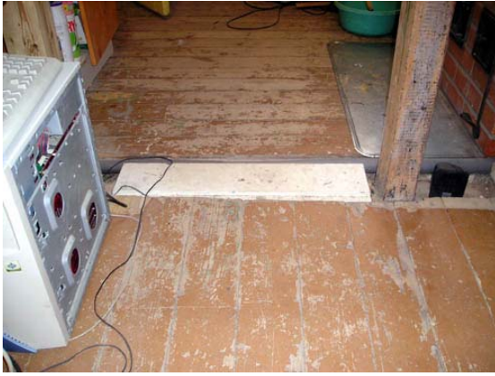
Pilt 24. Esiplaanil elutoa põrand, taamal köögiosa – pruuni värvi all paljastuvad korralikud põrandalauad
