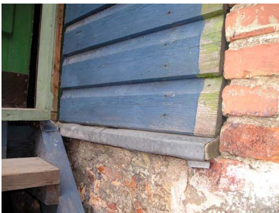
Pilt 26. Korter 10 hoovipoolne sein, näha on voodrilaudade ja vundamendi värvikihistused
