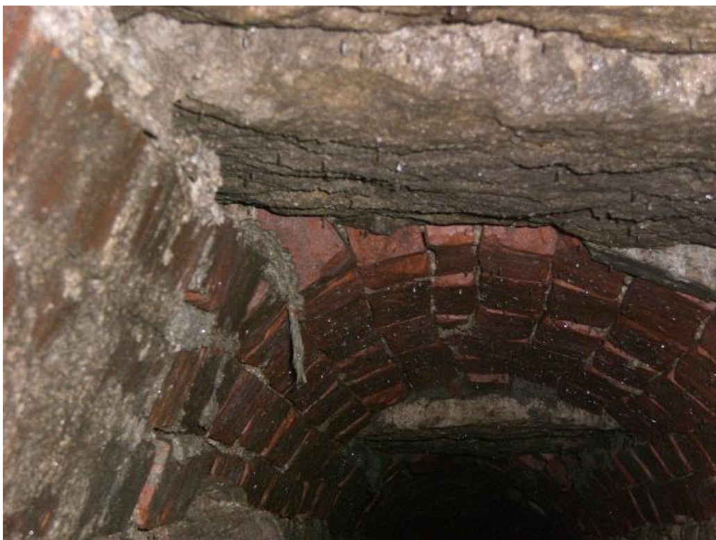
Foto 14. Drenaaži vōlvi asendus paekiviga
