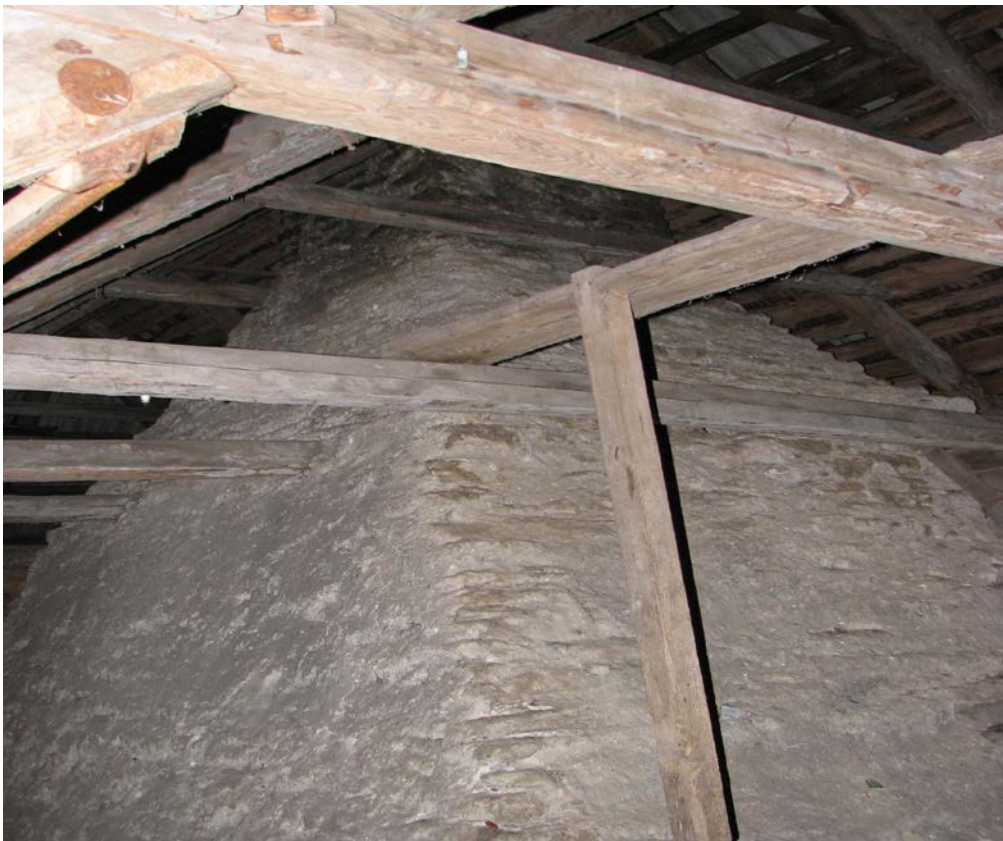
Foto 33 Mantelkorsten ja katusekonstruktsioonid
