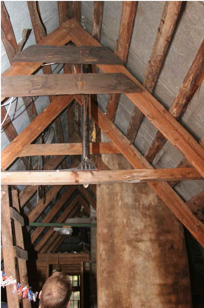
Foto 3 Sarikad, montaaživahuga tihendatud korstnapits ja antennijalg. Pennid puuduvad, antenni jalg toetub lihtsale lauale. Taustal on näha suvetoa avatud uks ja aken
