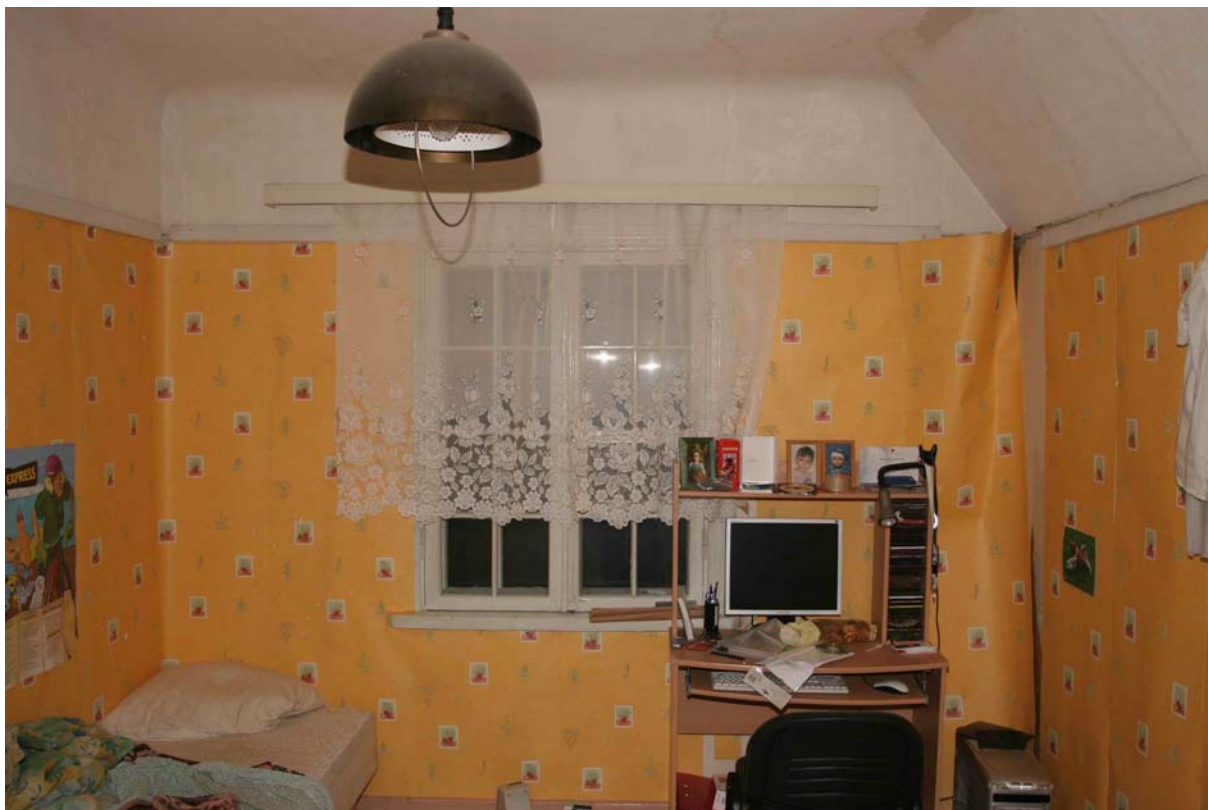
Foto 8 Üks väike tuba teisel korrusel, kus on säilinud peegelvõlviga lagi, seinu katab mitu kihti eriaegade tapeeti
