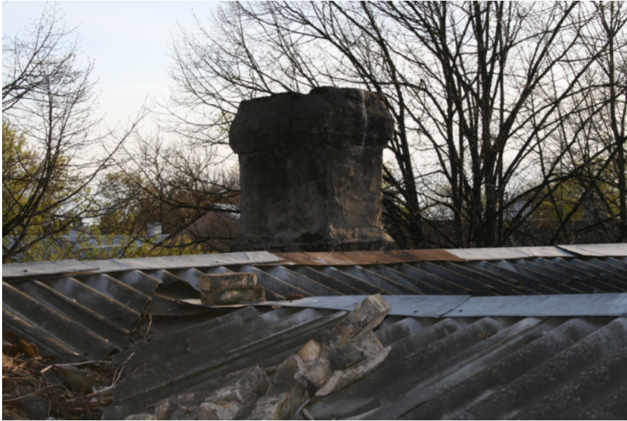
Joonis 10. Lagunenud korstnapitsid.
