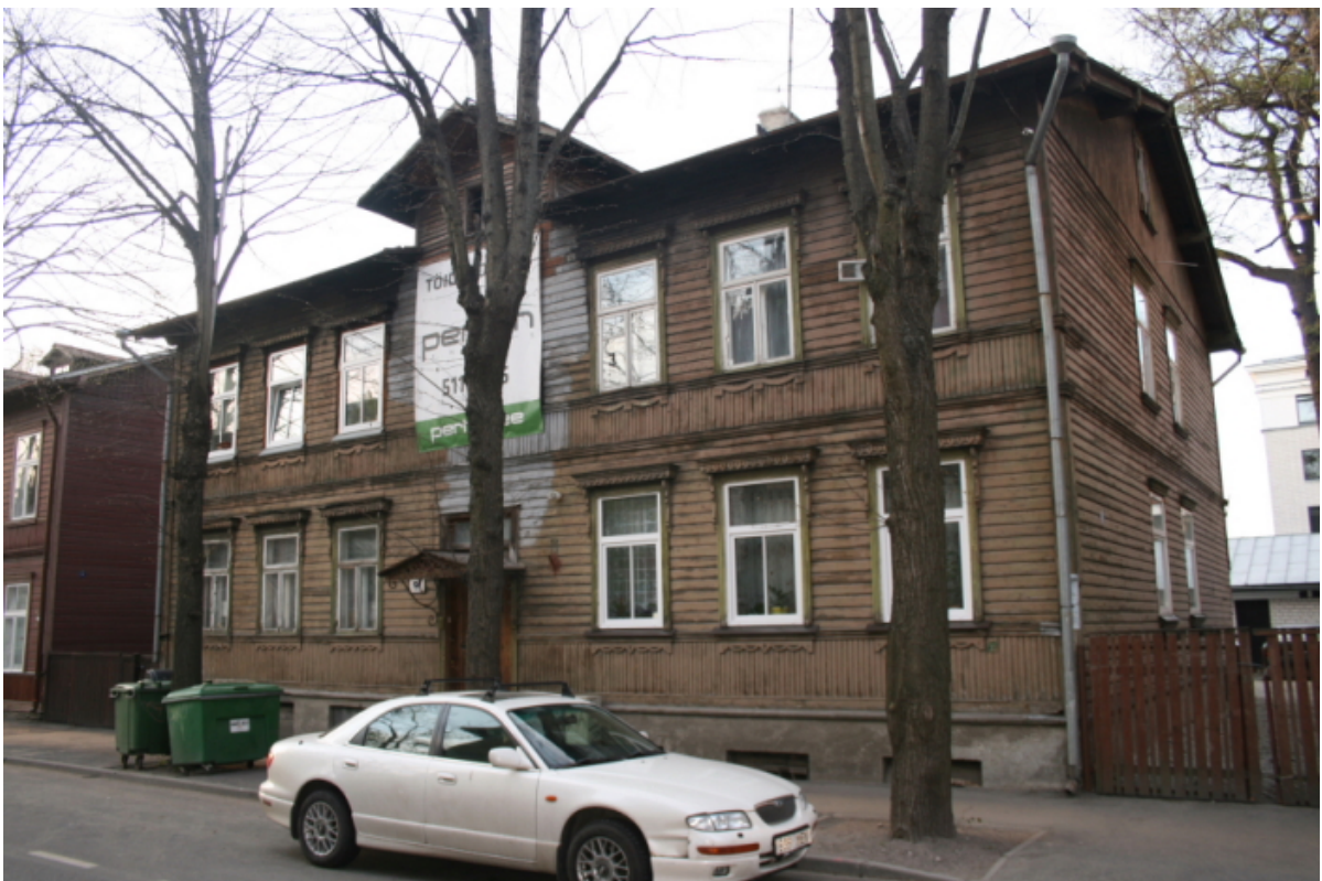
Joonis 5. Vertikaalne laudis akende aluses osas ja läbivad profiilsed vööd.
