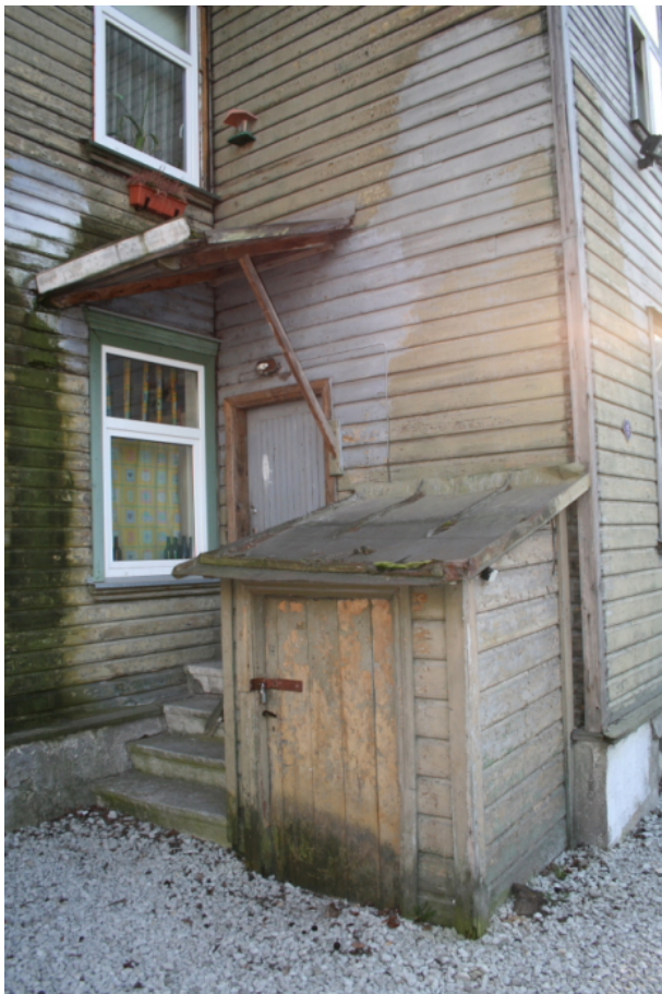
Joonis 2. Hoovipoolse sissepääsu vundament.
