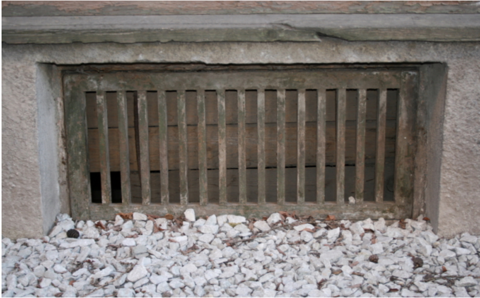
Joonis 11. Sokliakna katterestid.
