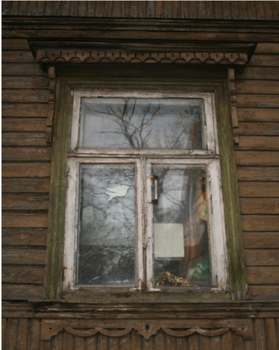
Joonis 6. Akende pealsed rikkaliku puitdekooriga karniisid ja akende alused sandrikud.
