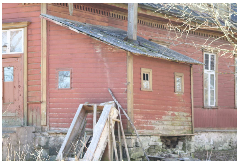
Foto nr 4 , hoonele küljelisatud vundamendiga kergseintega ehitis.
