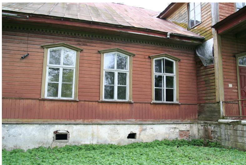
Foto nr 5 , hoone tagumise keldriruumi aknaavad ja õhutusava
