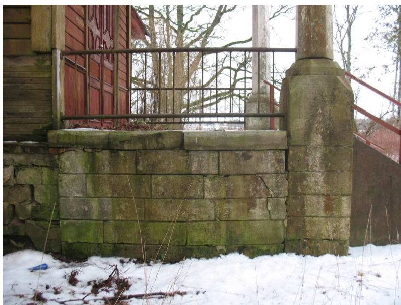
Foto nr 2, peatrepi rõdupõranda ja sammaste dolomiitplokkidest vundamendilaotis
