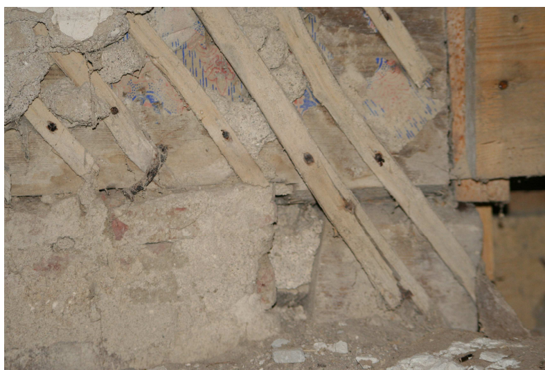
Foto nr 6 , hoone algne palkseinte viimistlus. Palgi peal tapeet.
