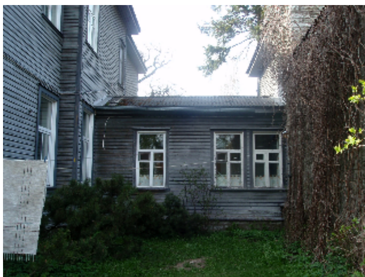
Lisa 16. Välisüks ja nelinurksed sambad esifassaadil.
