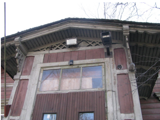
joonis 3. Räästakarniis, puitkonsoolid ja dekoratiivsed sarikaotsad hoone idafassaadil
