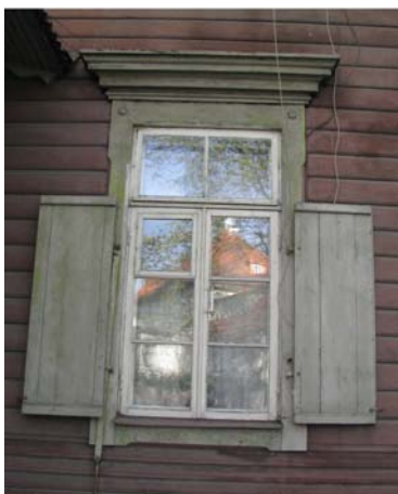
joonis 21. Aken esifassaadilt
