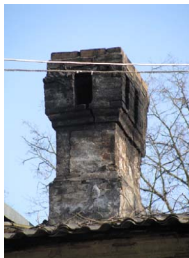
joonis 2. Lagunev korsten
