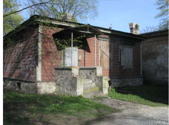
joonis 11. Põhjatiiva läänefassaad
