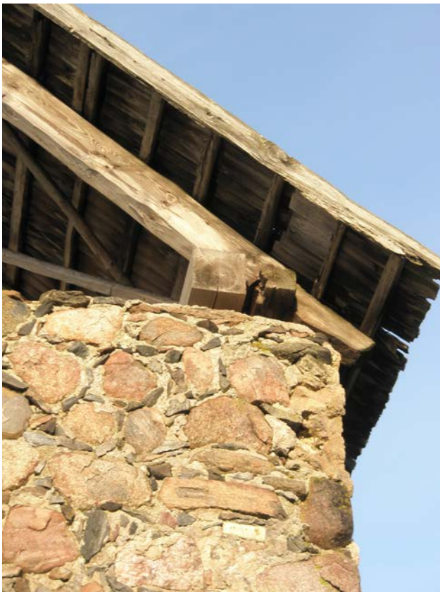
Joonis 28. Müüri sisse lammutatud orvad talade jaoks on tekitanud pragusid. Eili Siraki 2009.
