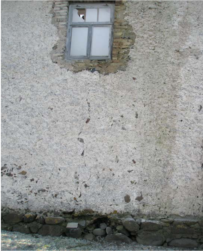
Joonis 16. Sokli osas on eemaldatud või eemaldunud kivid, mille tulemusena on tekkinud pragu. Eili Siraki 2009.
