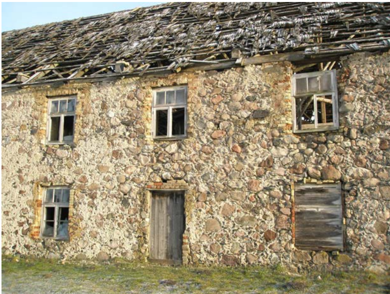
Joonis 25. Pehastunud, purunenud ja tugevate päikesekahjustustega aknad. Eili Siraki 2009.
