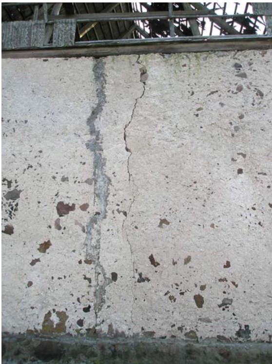
Joonis 17. Krohviparandusi on tehtud sobimatu tsementkrohviga. Eili Siraki 2009.
