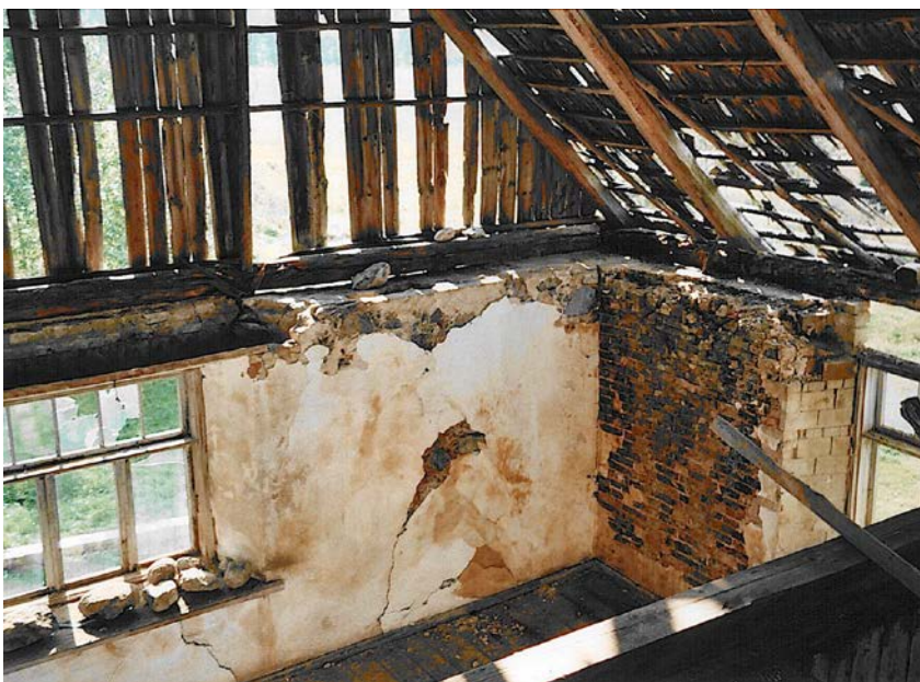
Joonis 27. Lagunenud vahelagi on eemaldatud. Eili Siraki 2009.
