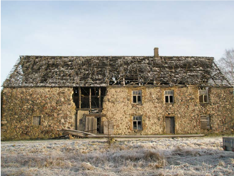
Joonis 18. Välisseinad on ehitatud maakividest. 2000-ndal aastal toimunud varingu tagajärjed. Eili Siraki 2009.
