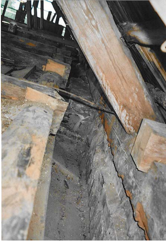
Joonis 22. Niiskuskahjustused müürlatis. Eili Siraki 2009.
