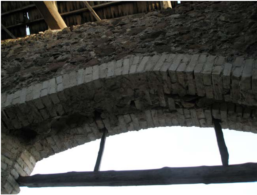
Joonis 12. Tõstamaa mõisa tellisetehases valmistatud tellistest laotud värava kaarsillus. Eili Siraki 2009.
