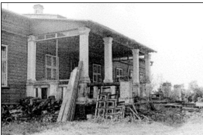
Joonis 66. Osaliselt hävinud terrassikonstruktsioonid aastal 1974 57 .
