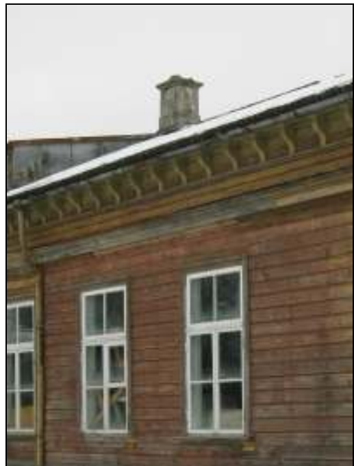
Joonis 4. Sikassaare mõisa peahoone ainus säilinud dolomiidist pitsiga korsten (hoone eestvaade).
