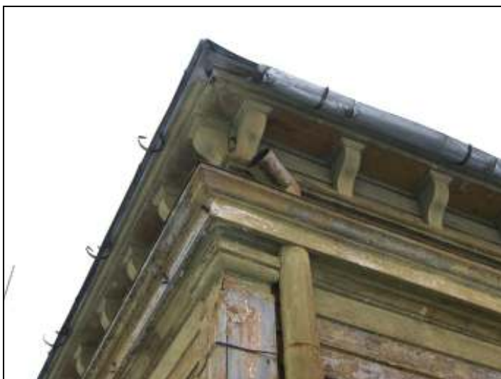
Joonis 63. Lagunenud äravoolurennid.
