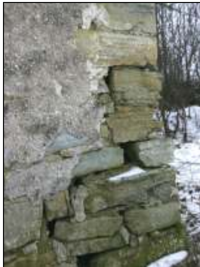
Joonis 31. Hoone pragunenud ning murenenud paekivist nurk.
