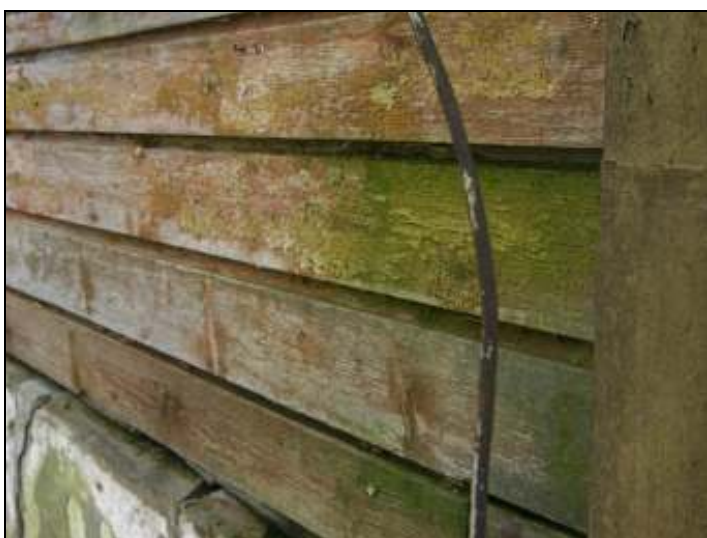
Joonis 65. Purunenud sadeveesüsteemist tingituna endale sobivalt niiske kasvukoha leidnud rohelisest vetikast kahjustatud puitlaudis.
