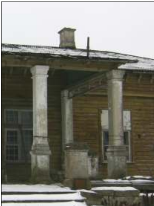
Joonis 3. Sikassaare mõisa peahoone ainus säilinud dolomiidist pitsiga korsten (hoone tagantvaade). Fotod talv 2009.a.
