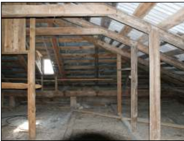
Joonis 59. Hoone kelpkatuse kandekonstruktsioonid.
