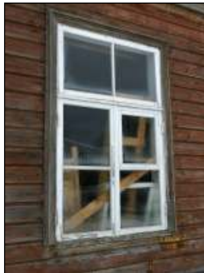
Joonis 46. Originaaljaotuse ning tuulutussavaga aken.
