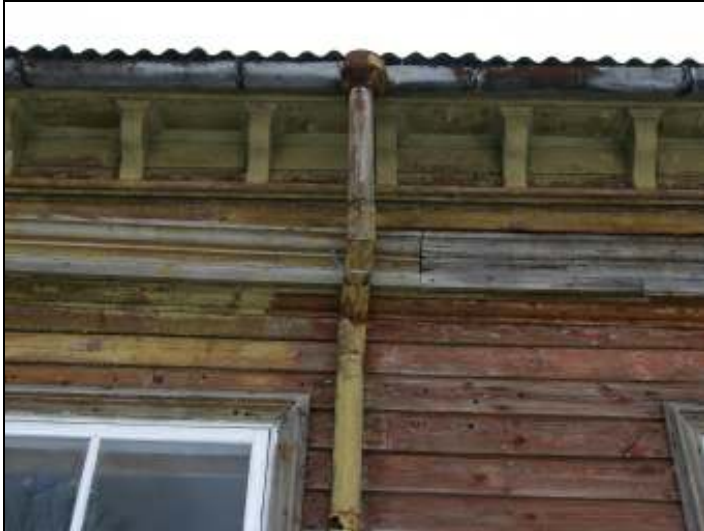
Joonis 51. Peahoone hammaslõikeline räästakarniis.
