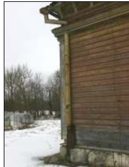
Joonis 62. Karniisi läbiv vihmaveetoru on amortiseerunud. Hoonet ümbritsev pandus on lagunenud.
