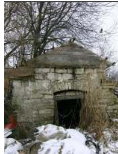
Joonis 34. Mõisa keldri idapoolne kaarsillusega sissepääs.
