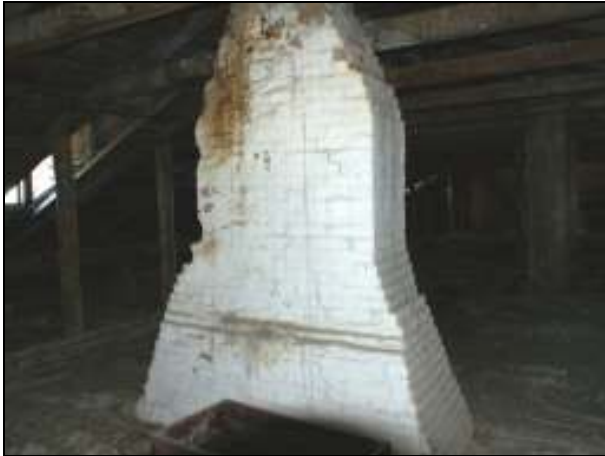
Joonis 60. Punasest tellisest laotud ning lubjatud korstnjalg.
