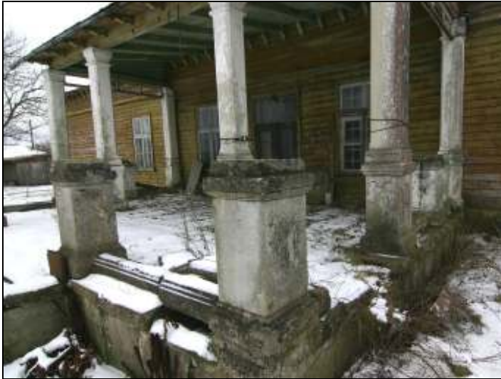
Joonis 53. Hoone tagafassaadil paiknev rõdu.
