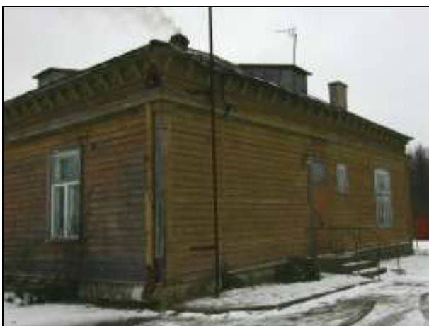
Joonis 55. Hoone kirdesse avanev fassaad ning sissepääs korterisse.
