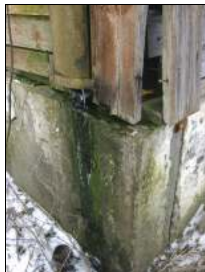
Joonis 64. Katkine äravoolutoru juhib sademeveed otse soklile. Tekkinud kahjustuste selgitamiseks tuleks konstruktsioon avada.
