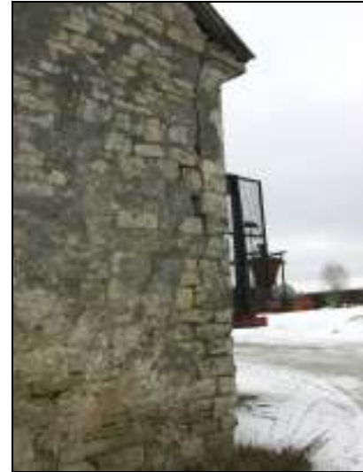
Joonis 25. Mõisa aida lõunapoolseim pragunenud nurk.
