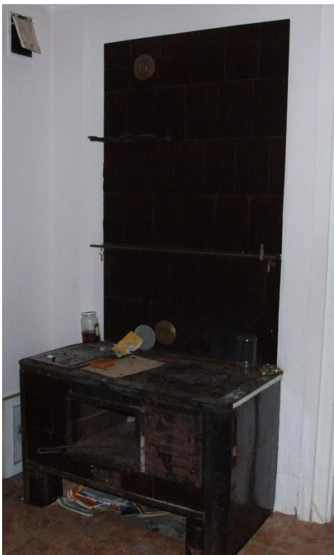
Joonis 19. Pliit ja soemüür
