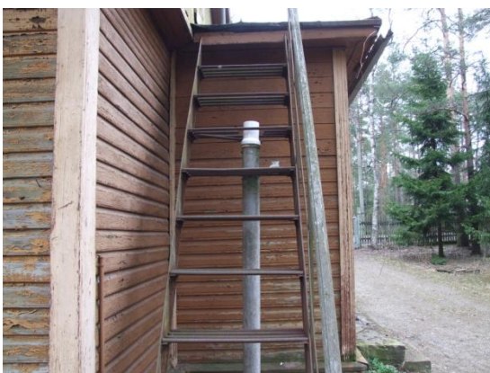
Joonis 5. Idaküljel olev raudtrepp
