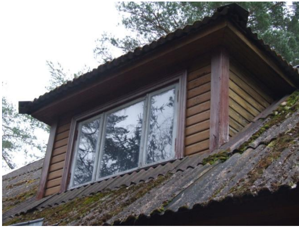
Joonis 6. Põhjakülje vintskapp ja eterniit katus
