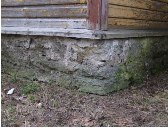
Joonis 1. Paekivist vundament
