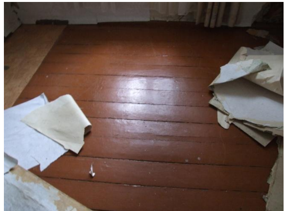
Joonis 15. Värvitud laudpõrand
