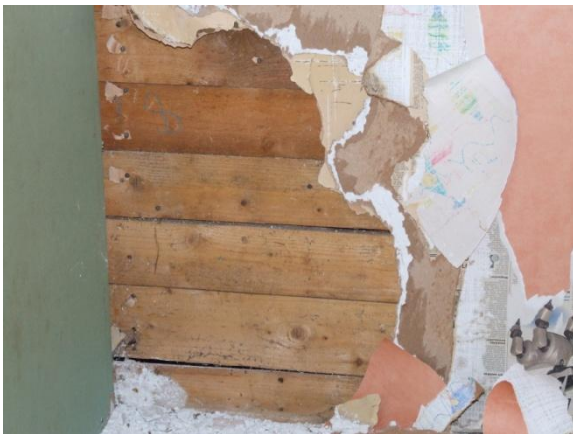
Joonis 14. Puitvahesein
