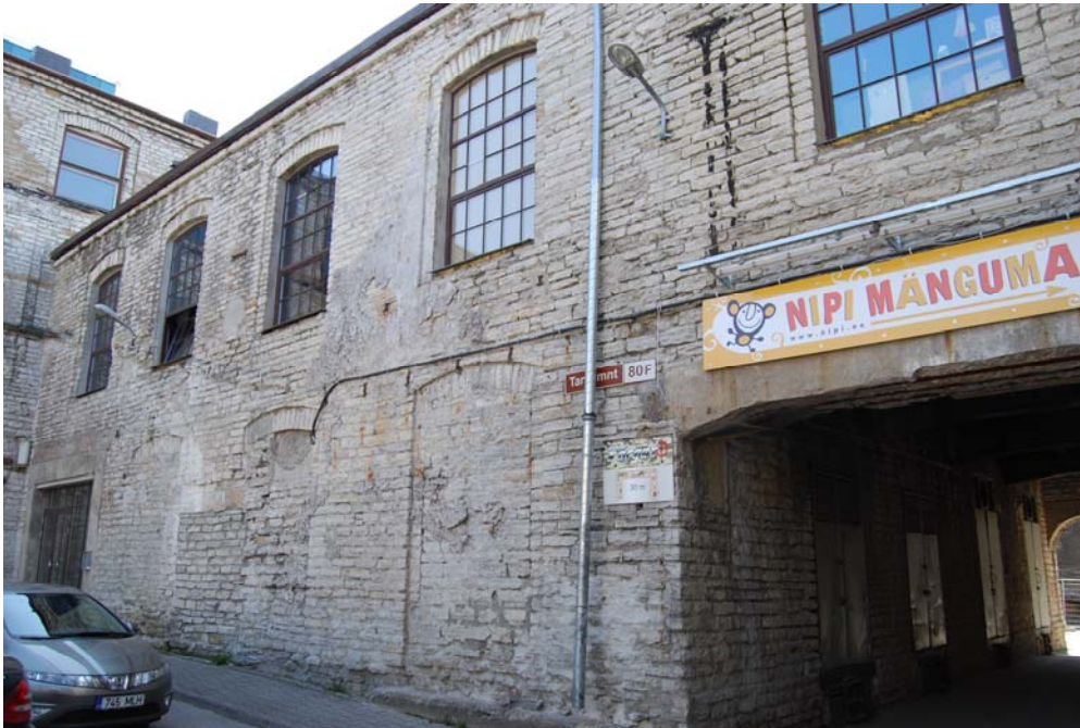
Joonis 5: Vaade fassaadile sisehoovist
