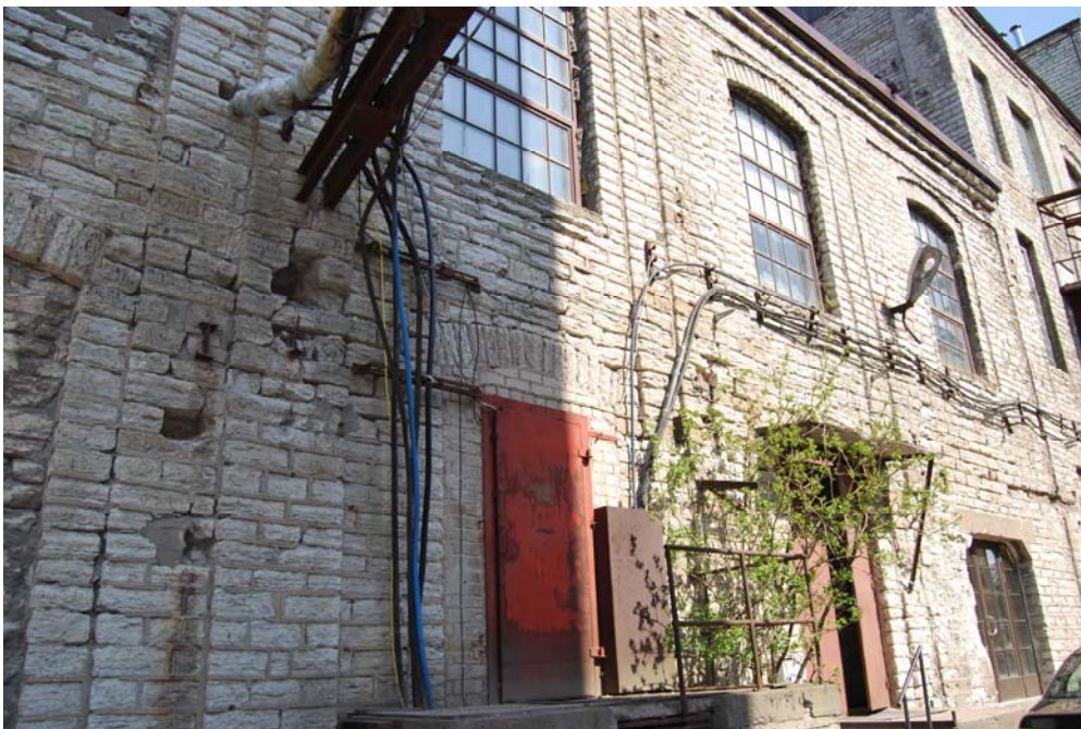
Joonis 6: Vaade fassaadile Lastekodu tänavalt
