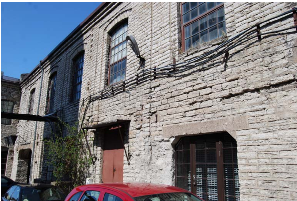
Joonis 8: Elekrikaablid fassaadil
