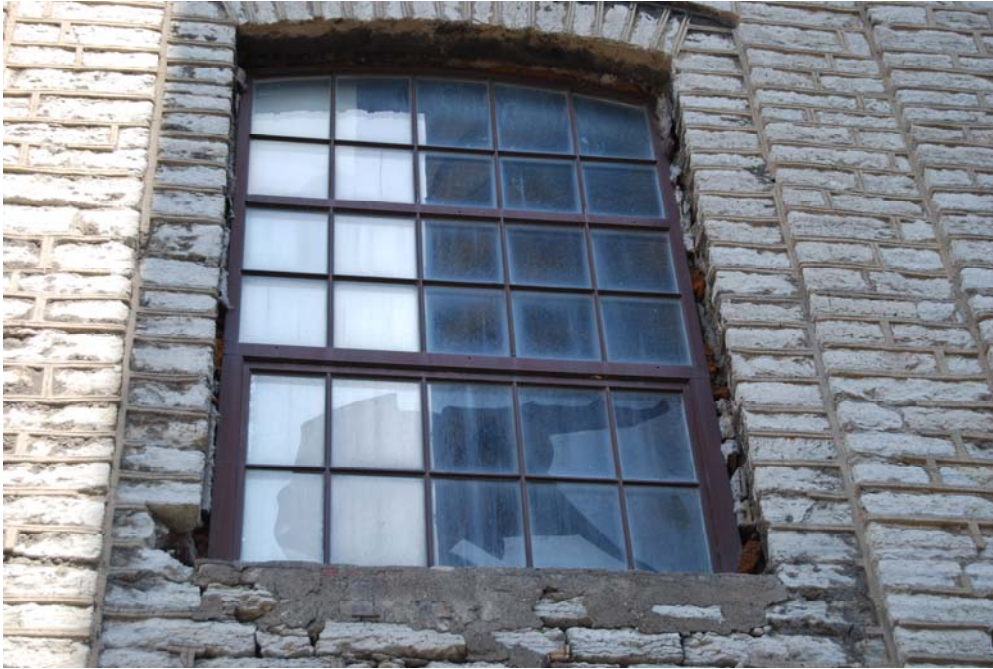
Joonis 7: Vaade aknapalede seisukorrale
