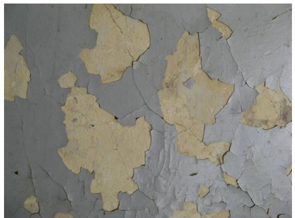
Joonis 45. Katkisest trepikoja aknast sisse tulnud sademevesi on õlivärvi lubivärvi pealt lahti löönud
