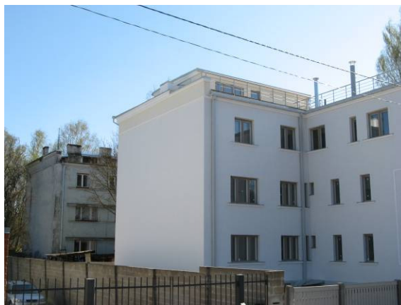
Joonis 48. Laulupeo pst 9 rekonstrueeritud kujul välja ehitatud pööningukorruse ja katuseterrassidega
