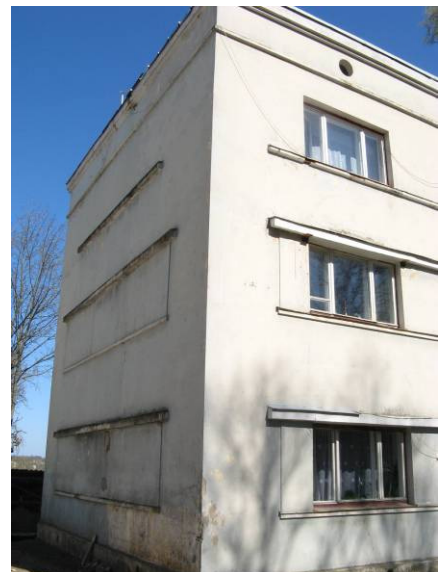
Joonis 20. Elamu tänavapoolse tiiva otsaseinas aknad puuduvad, kuid sein on liigendatud nende karniisidega.
