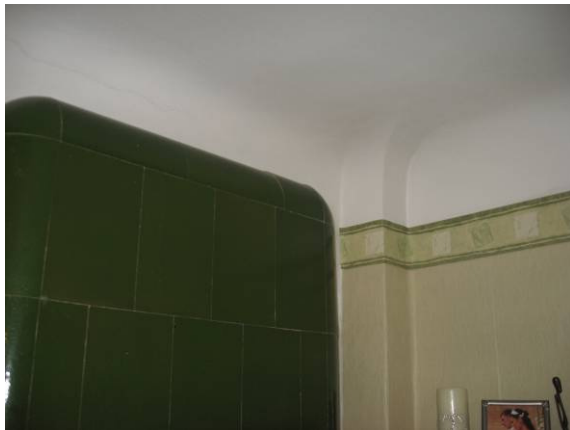
Joonis 42. Originaalina säilinud peegelvõlvlagi
