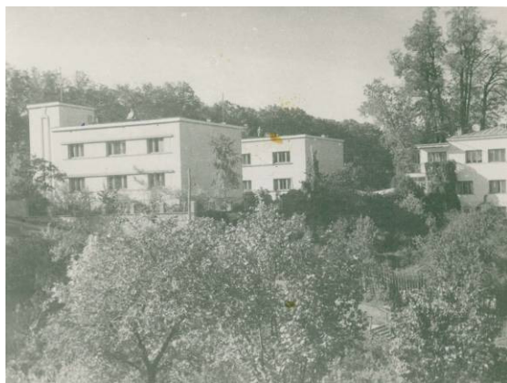
Joonis 2. Vaade elamule kirdest enne kolmanda korruse peale ehitamist
