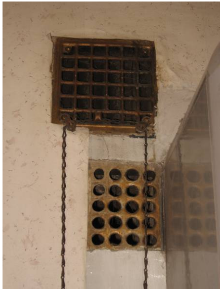
Joonis 34. Originaalina säilinud ventilatsiooni restid
