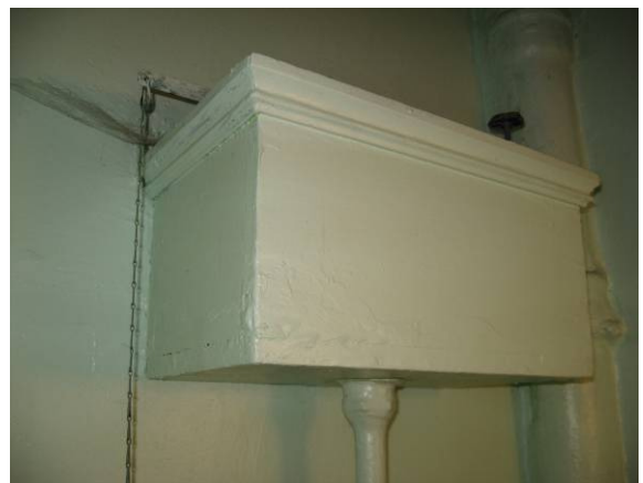
Joonis 37. Originaalina säilinud wc loputuskast
