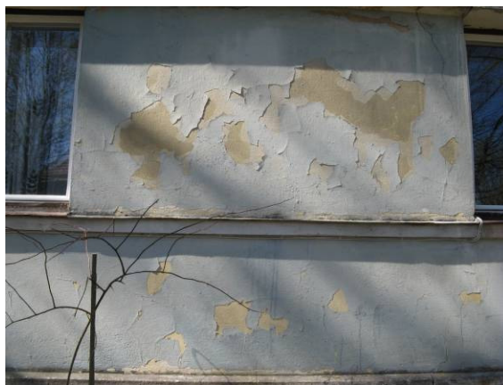
Joonis 22. Algselt lubivärvilt kooruv värv
