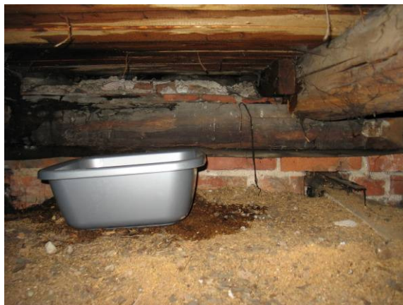
Joonis 25. Lumesulamisveest tingitud läbisadamine katuse räästa piirkonnas
