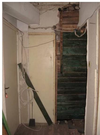
Joonis 46. Kolmanda korruse siseseina konstruktsioon
