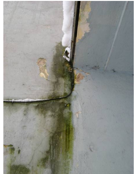
Joonis 18. Juhtmetest ja varikatusest tingitud niiskuskahjustused
