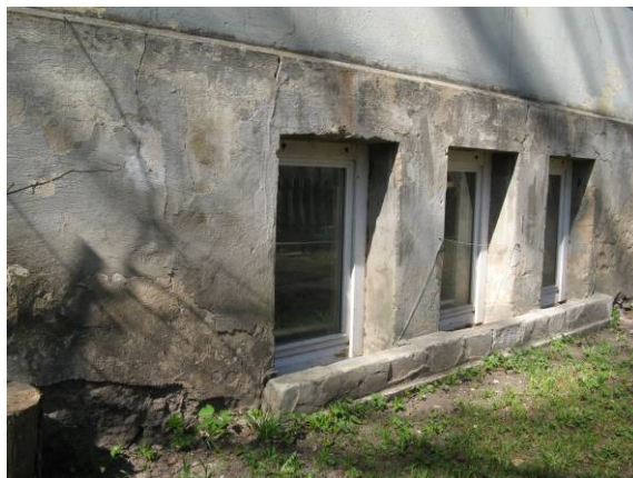
Joonis 16. Hoone vundament ja keldriaknad
