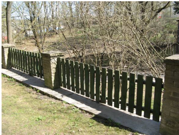
Joonis 14. J. Hurda tn äärne ja krundi põhjapoolne müüripealne madalam püstpuitlipidest piire
