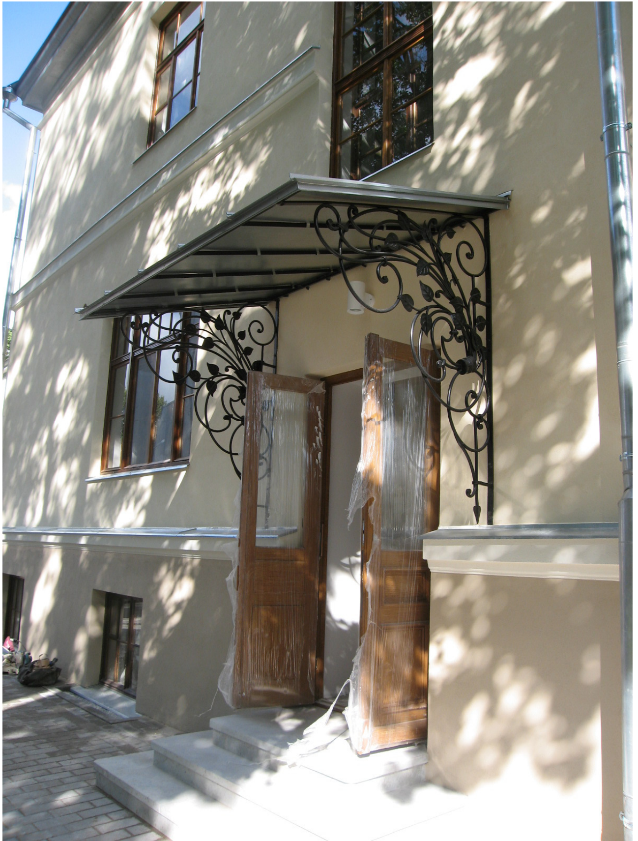
Varikatus tagafassaadi sissepääsu kohal
