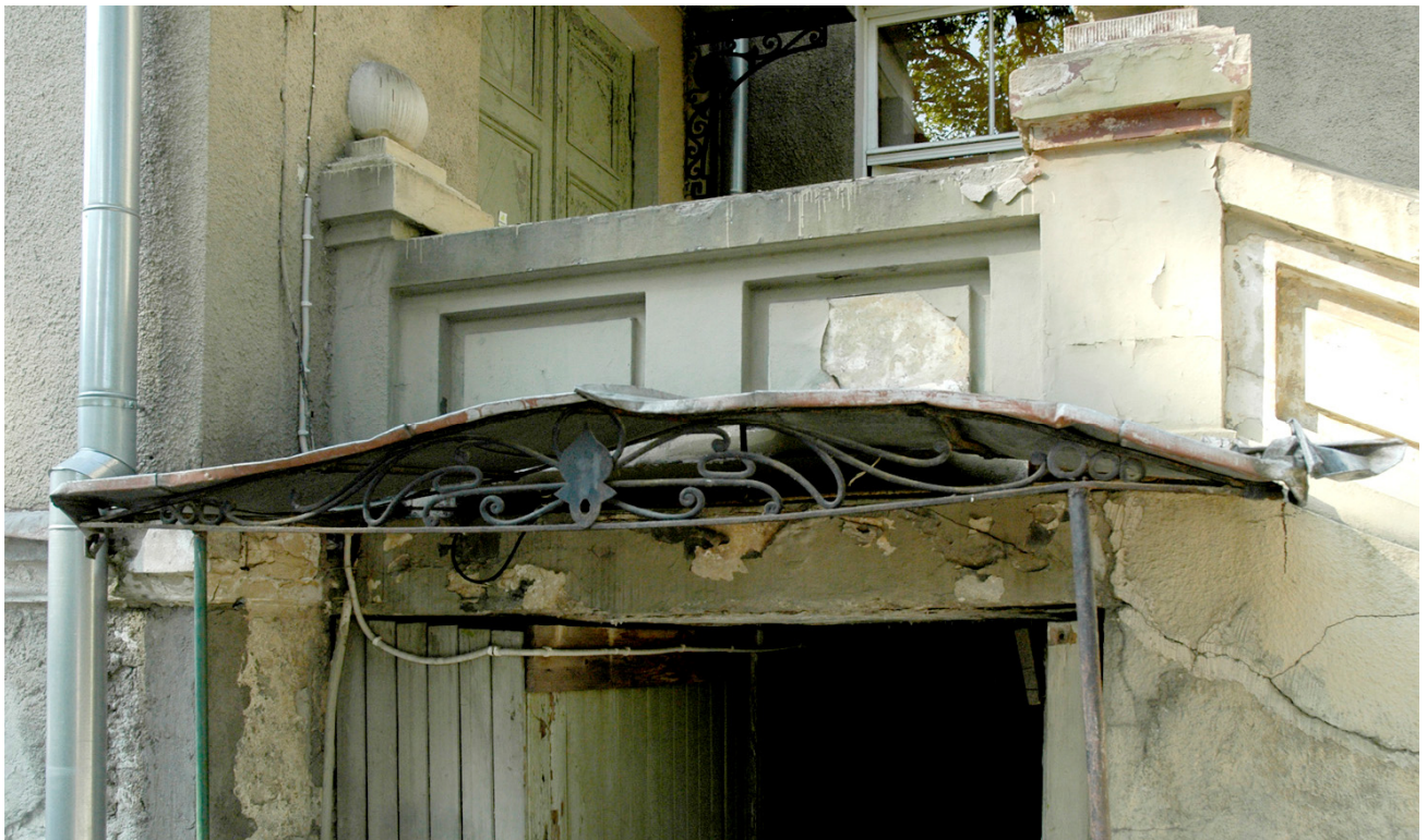
Varikatus idafassaadi keldri sissepääsu kohal
