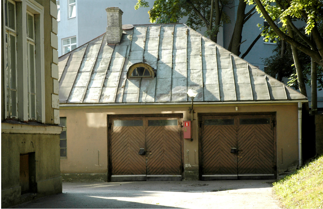
Vaade garaažihoonele põhjast
