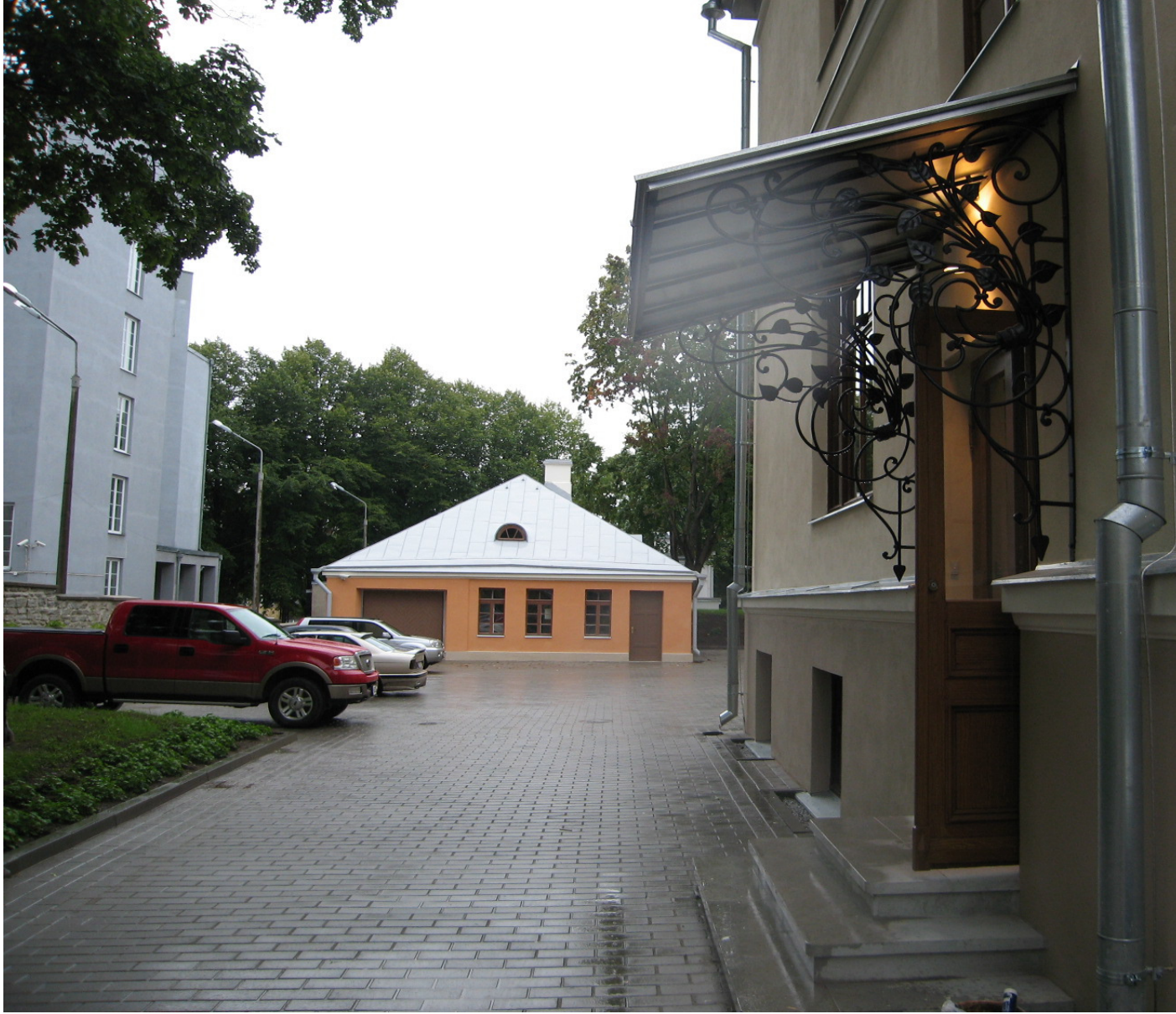
Varikatus tagafassaadi sissepääsu kohal
