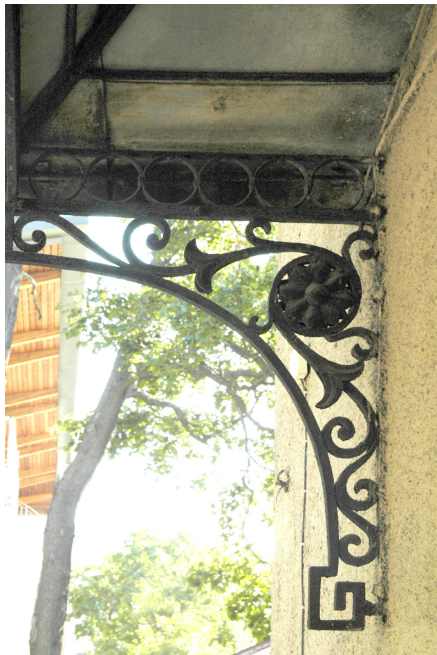
Varikatus tagafassaadi sissepääsu kohal
