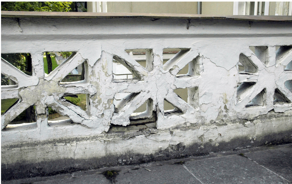
Lagunev betoonist terrassipiire
