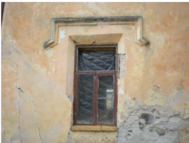
Foto 6 – I korruse akna näide (järvepoolisel fassaadil) (30.04.2009)
