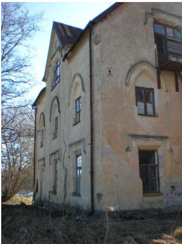
Foto 3 – Vaade tagumisele (järvepoolsele) fassaadile (21.04.2009)
