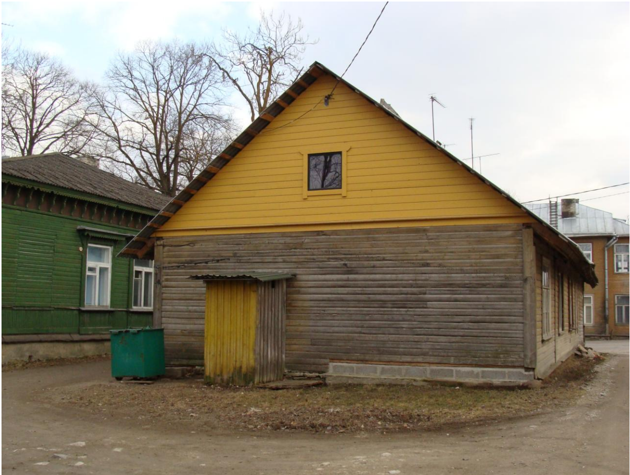
Joonis 8. Uus katus, viiluväli ja Fibo plokkidest vundamendi parandused hoone põhjaküljel. Foto Sirli Naska, 2009.
