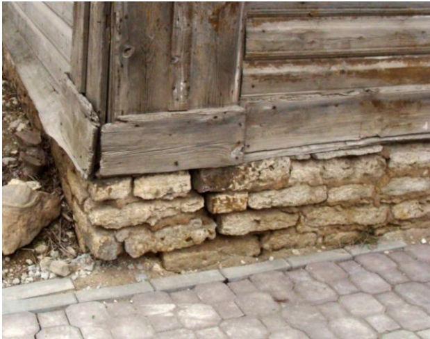
Joonis 6. Vundament, Karja ja Allika tn nurk. Joonis 7. Vundamendi parandused hoone idaküljel.
