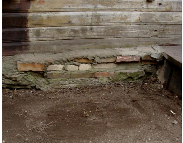
Joonis 6. Vundament, Karja ja Allika tn nurk. Joonis 7. Vundamendi parandused hoone idaküljel.
