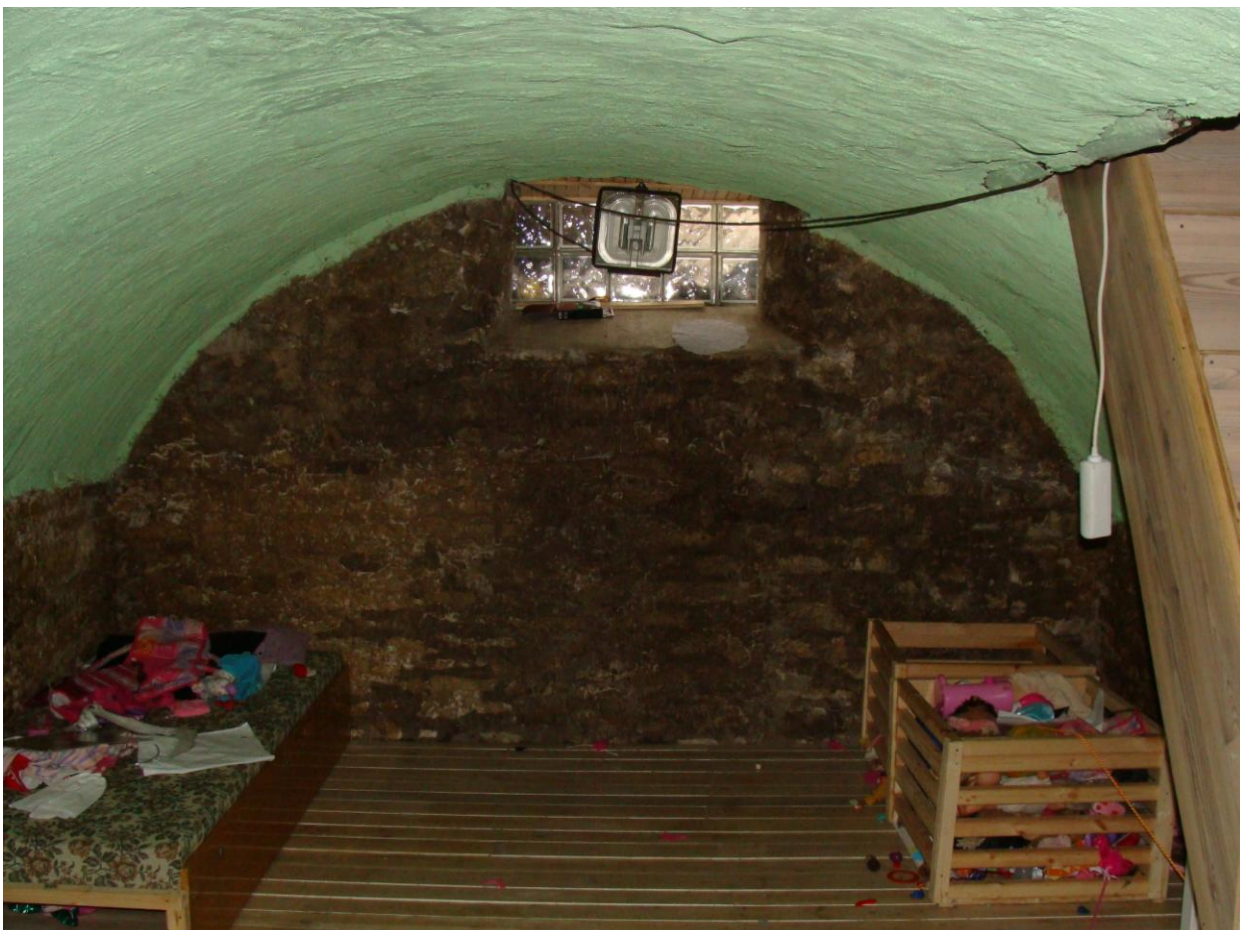
Joonis 9. Hoone lastetoaks kohandatud kelder.
