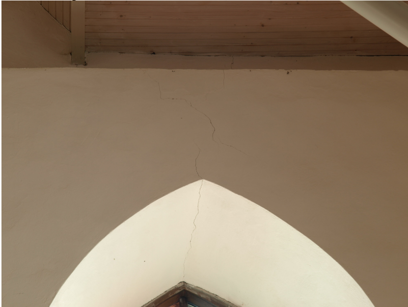
Joonis 9. Pragu seinas (autori foto)
