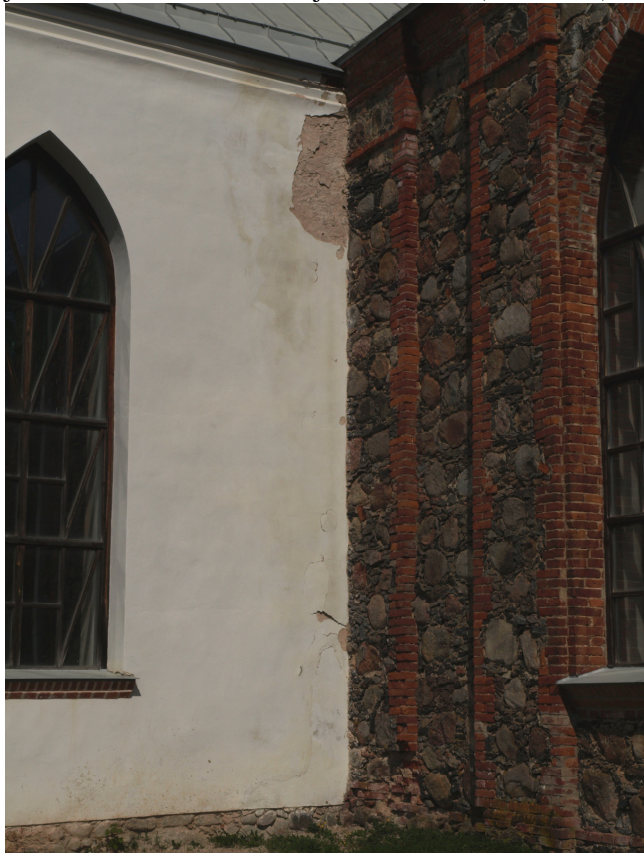
joonis 2. Vaade edelast kahjustused seinal(autori foto)
