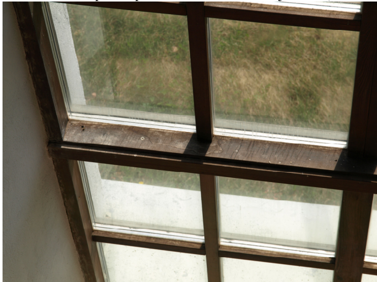
Joonis 13 Lõunapoolse pikilöövi akna niiskuskahjustused (autori foto)
