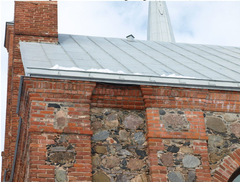
Joonis 11. Märgev karniis ristilöövi kagunurgas (autori foto)
