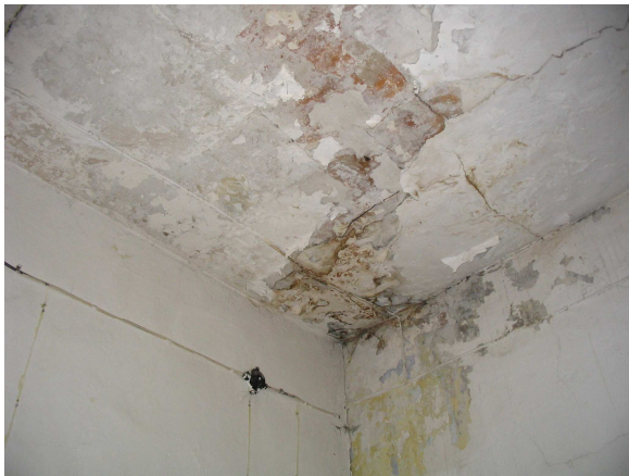
Joonis 29. Läbisadanud koht ja eemaldatud vaheseina koht
