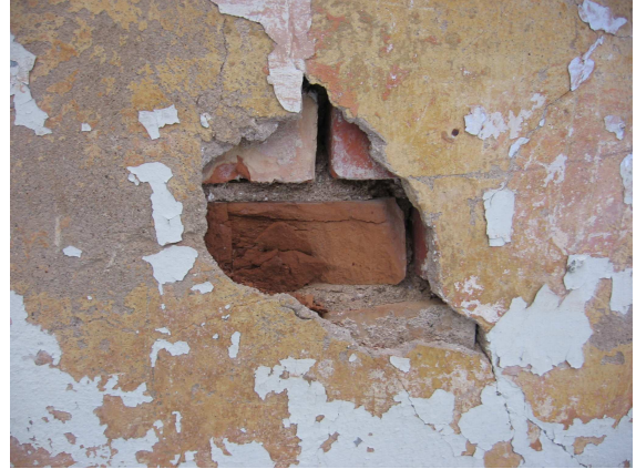
Joonis 16. Mahakoorunud ja pragunev fassaadivärv ning auk seinas
