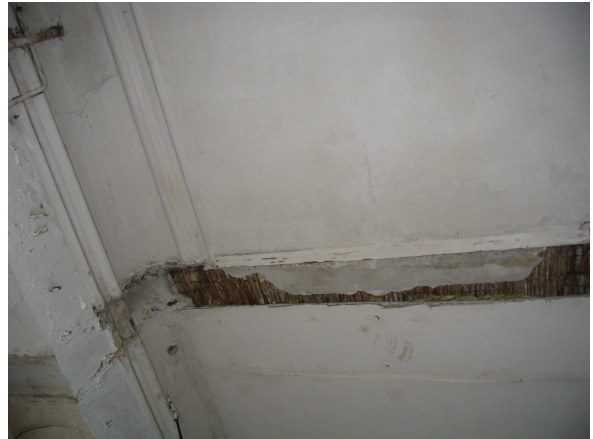
Joonis 29. Läbisadanud koht ja eemaldatud vaheseina koht
