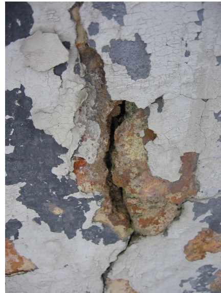
Joonis 17. Külmakahjustused ja pragunemine
