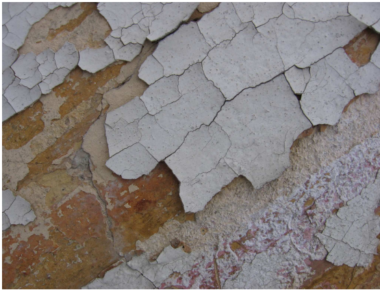
Joonis 16. Mahakoorunud ja pragunev fassaadivärv ning auk seinas
