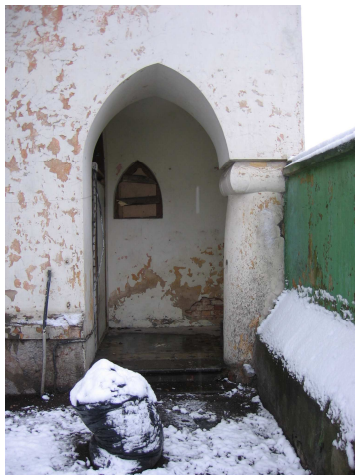
Joonis 22. Kinnimüüritud võlvkäik tänavalt ja hoovist
