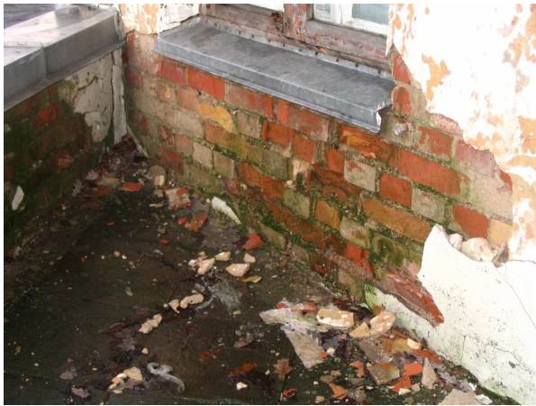
Joonis 19. Pudenenud krohv ja vetikate levik
