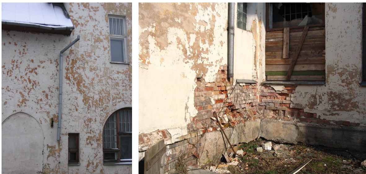
Joonis 11. Lahti tulnud ja poolde seina ulatuvad vihmaveetorud
