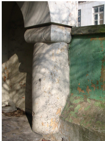
Joonis 21. Kinnimüüritud võlvialuse sammad ja kunagise rõdu kinnimüüritud sambad
