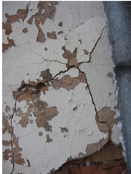
Joonis 17. Külmakahjustused ja pragunemine
