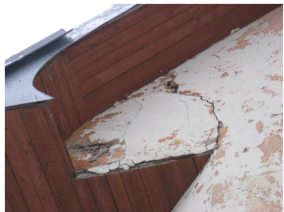
Joonis 18. Praod alusstruktuuris
