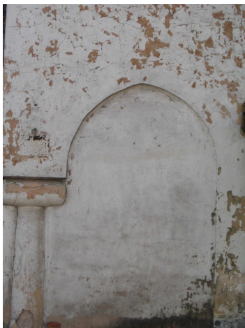
Joonis 22. Kinnimüüritud võlvkäik tänavalt ja hoovist
