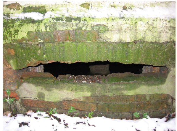
Joonis 19. Pudenenud krohv ja vetikate levik
