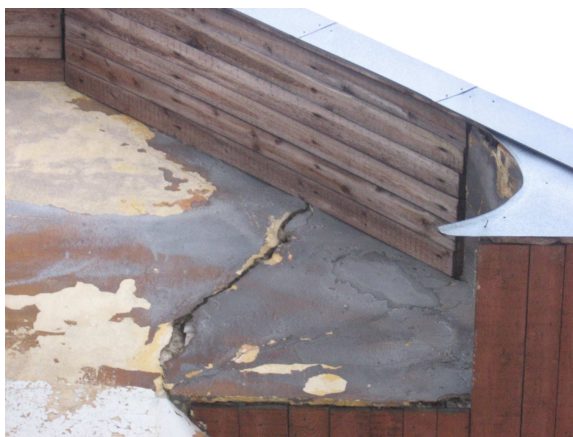
Joonis 18. Praod alusstruktuuris
