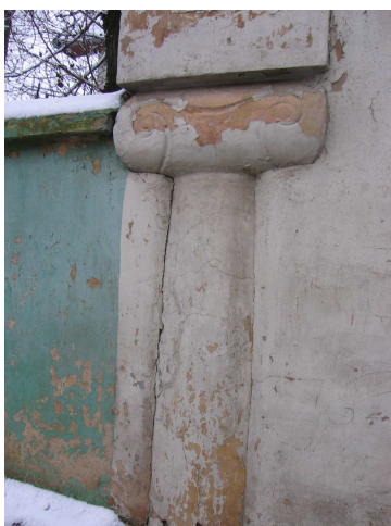
Joonis 21. Kinnimüüritud võlvialuse sammad ja kunagise rõdu kinnimüüritud sambad
