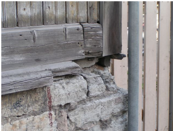
Joonised 12 ja 13. Niiskuskahjustused. Fotod 2009
