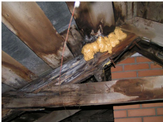
Joonised 8 ja 9. Niiskuskahjustused. Fotod 2009
