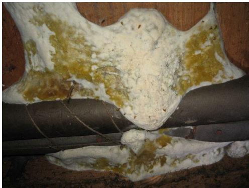
Joonised 18 ja 19. Majavamm. Fotod 2007/2009
