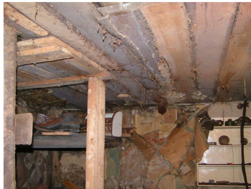
Joonised 18 ja 19. Majavamm. Fotod 2007/2009
