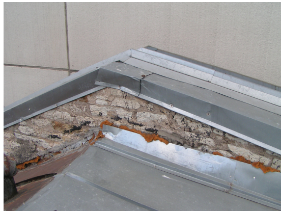
Joonis 7. Katuse ja tulemüüri liitekoht. 2009
