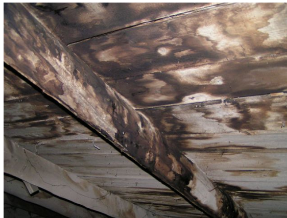
Joonised 8 ja 9. Niiskuskahjustused. Fotod 2009
