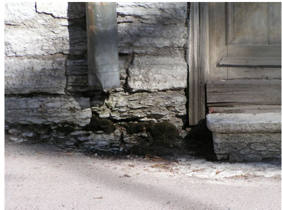
Joonised 12 ja 13. Niiskuskahjustused. Fotod 2009
