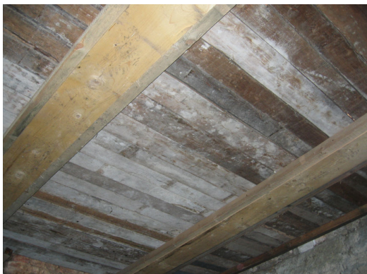
Joonis 30 Välja vahetatud avariilised 1.korruse vahelaetalad
