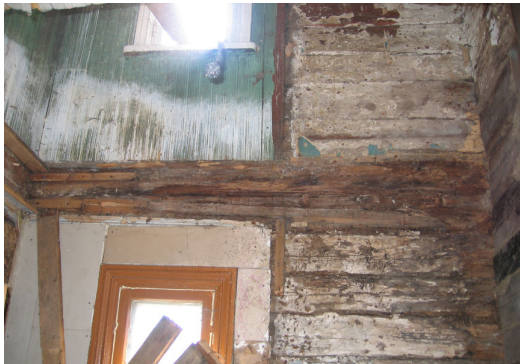
Joonis 29 Päevavalgele tulnud pehkinud palgid peale WC-de lammutamist
