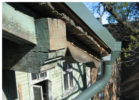
Joonis 4 Sarikaotsad
