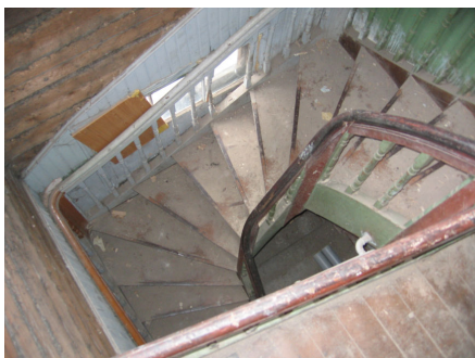
Joonis 23 Puidust keerdtrepp korruste vahel
