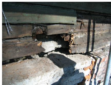
Joonis 28 Pehkinud palgid
