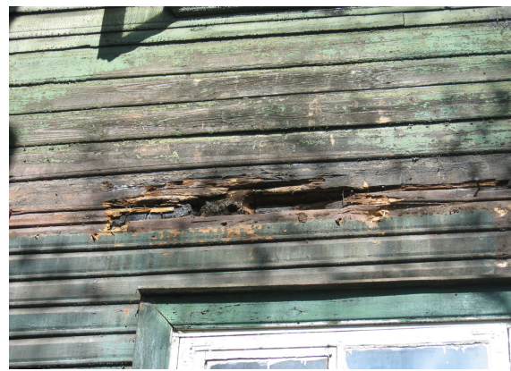
Joonis 9 Pehkinud voodrilaud
