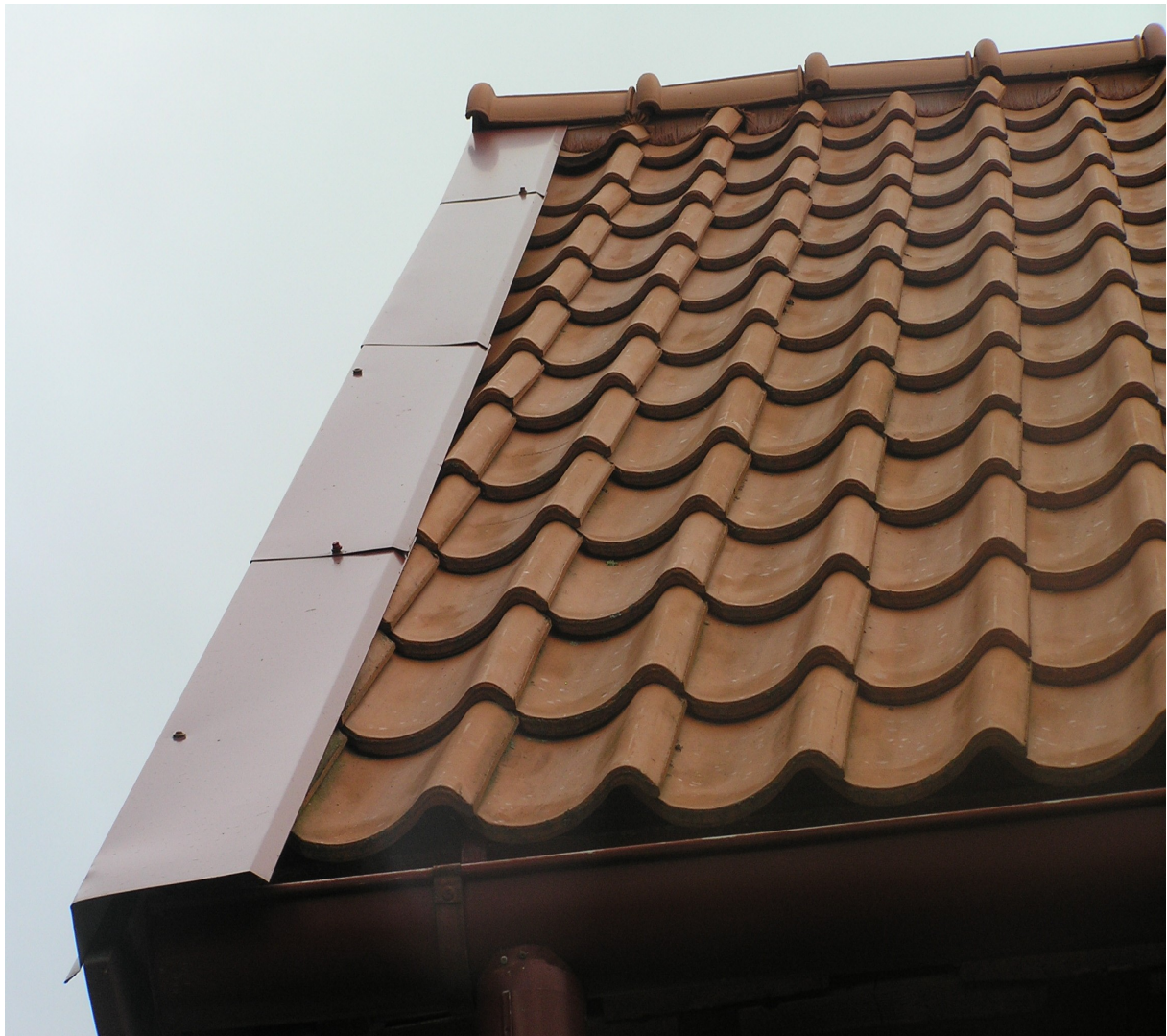
Ääreplekiga vormistatud katuseviil, kõige levinum Eestis
