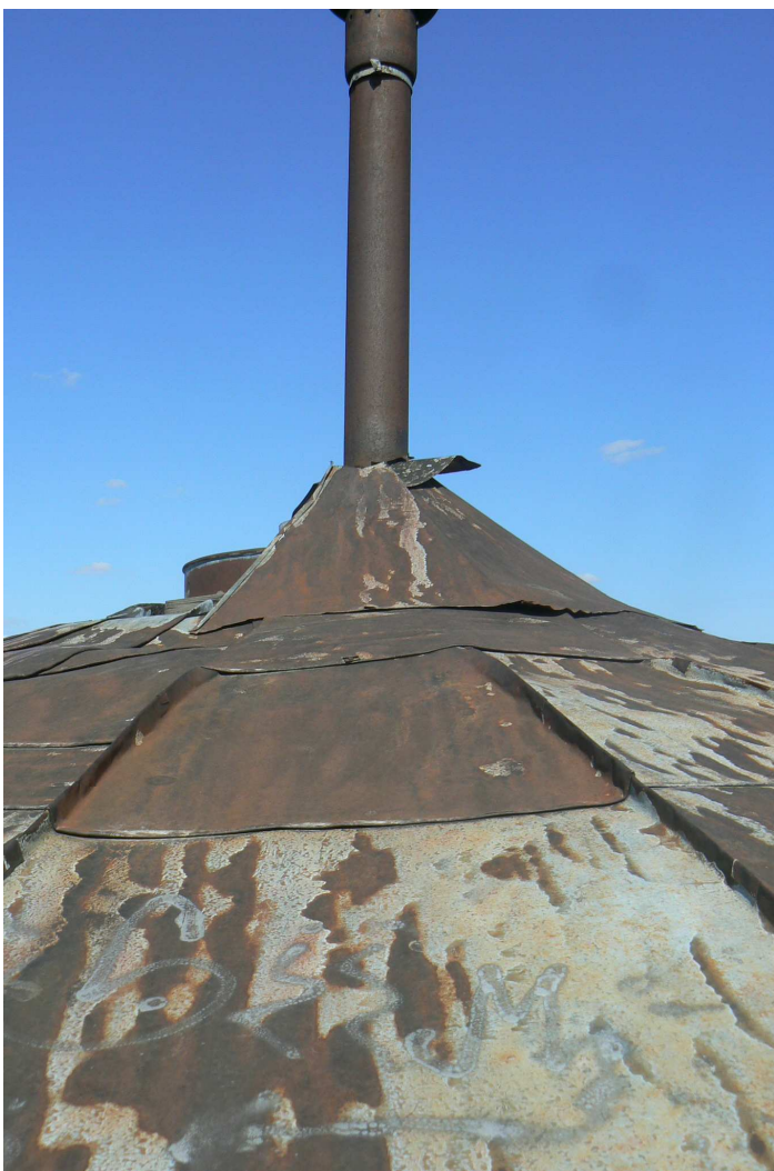
Foto 15: Pealtpoolt paistab silma katusepleki paigaldamise kehv kvaliteet. (autori foto)
