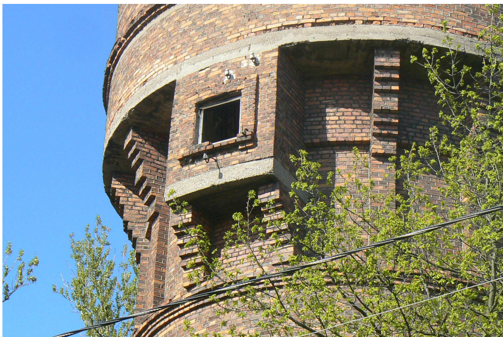
Foto 6: Veepaagiümber olevat käiguteed toetavad liseenid ja neist välja kasvavad tellistest konsooltoed
