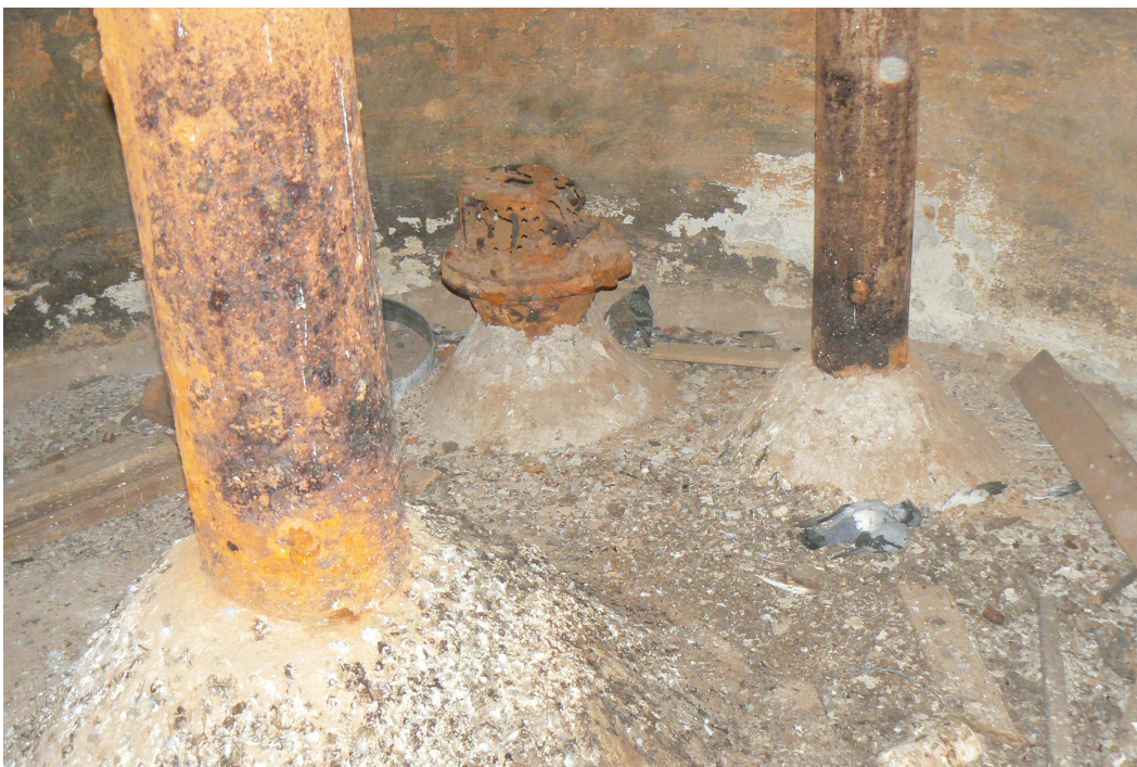
Foto22: Sisemise paagi läbiroostetanud torustikud( autori foto)
