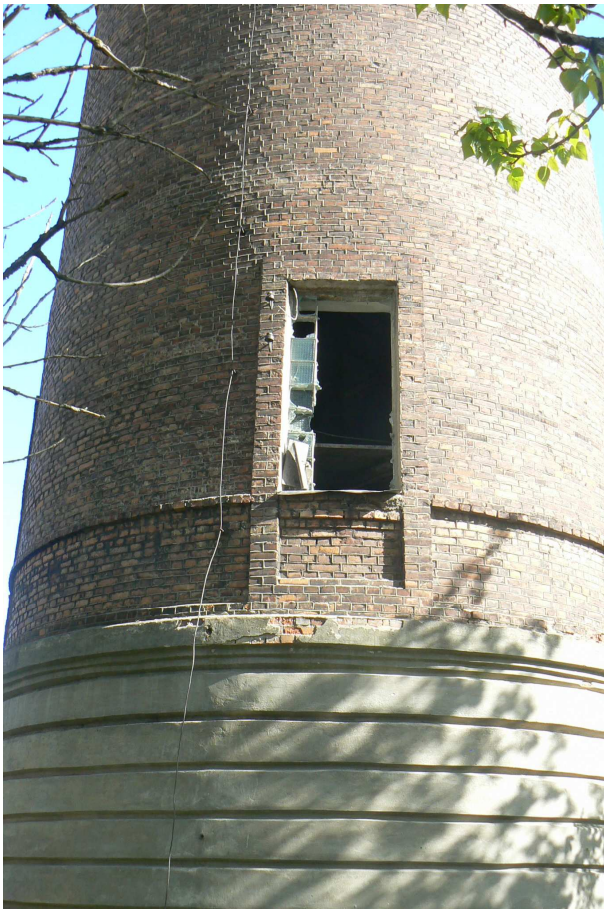
Foto 3: Hoone aknad on täna lõhutud ja tuleks kindlasti kasvõi laudadega kinni lüüa, et hoonet nii ilmastiku kui ka marodööride käest säästa.(autori foto)
