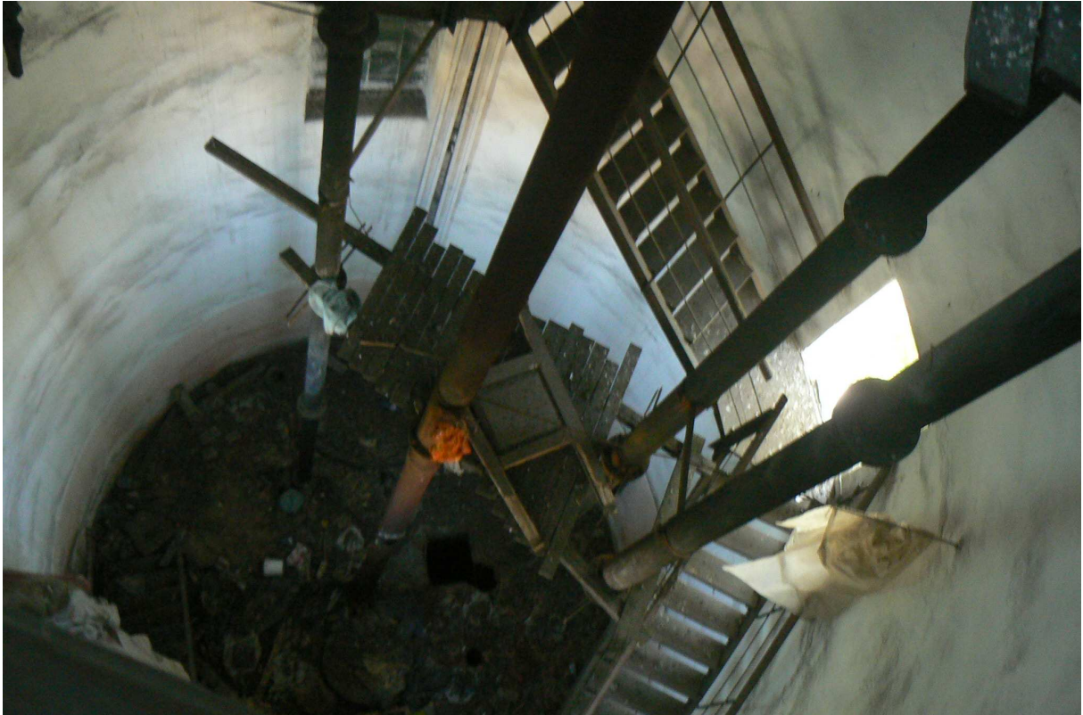
Foto 16: Vaade lae all asuvalt metallplatvormilt alla. Näha metalltrepp ja kellegi poolt torude vahele paigaldatud ajutised tellingud Punase kaltsuga toru on kasutatud korstnana, teised torud olid kasutusel vee transportiks torni ja pärast vee tarbijatele (autori foto)
