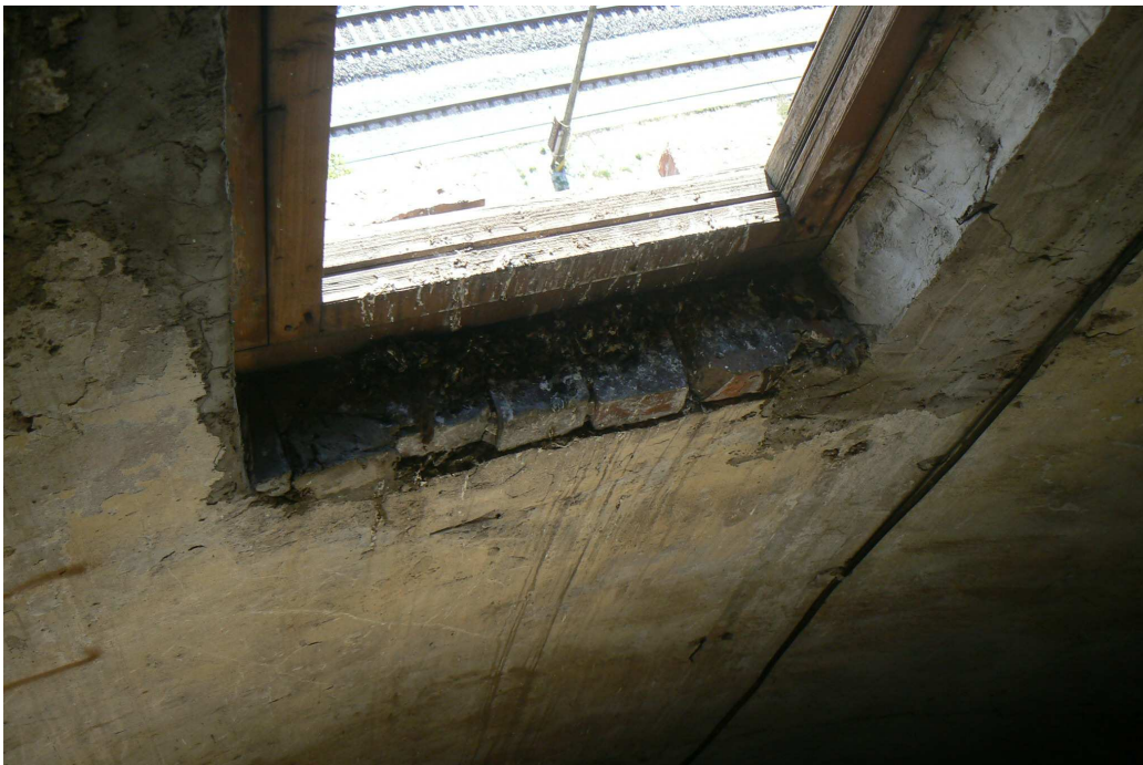
Foto 12: Aknad on omal tehtud mitteeluhoonele ja seepärast erilist väärtust ei oma.(autori foto)
