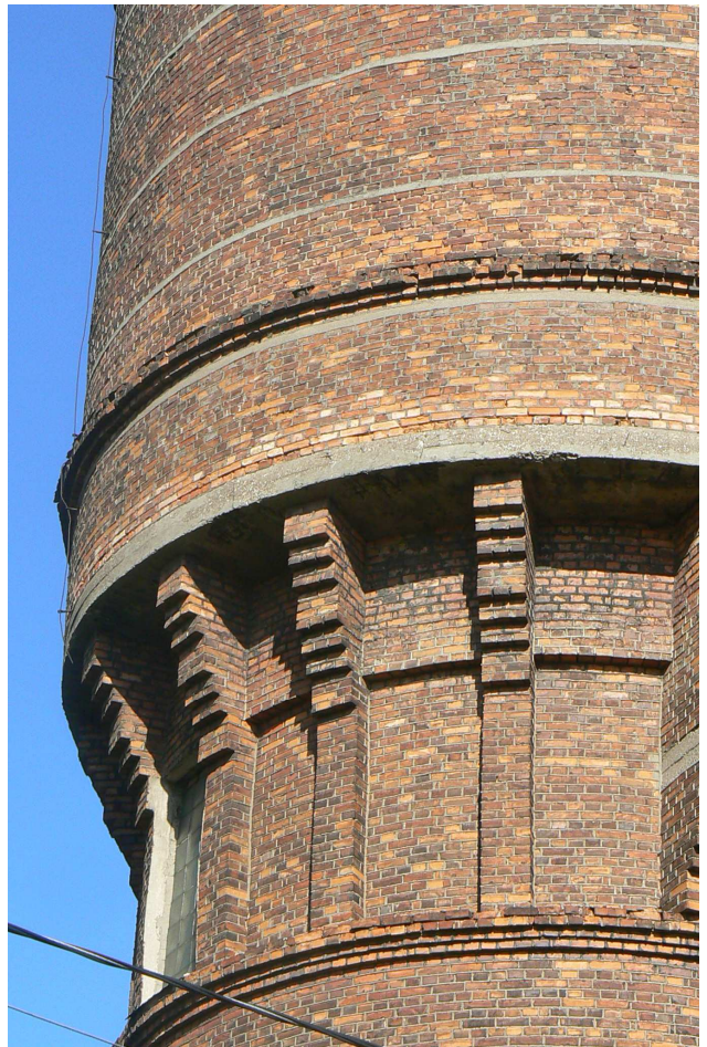
Foto 8: Veepaagi osa on tugevdatud raudbetoonist vahevöödega.(autori foto)
