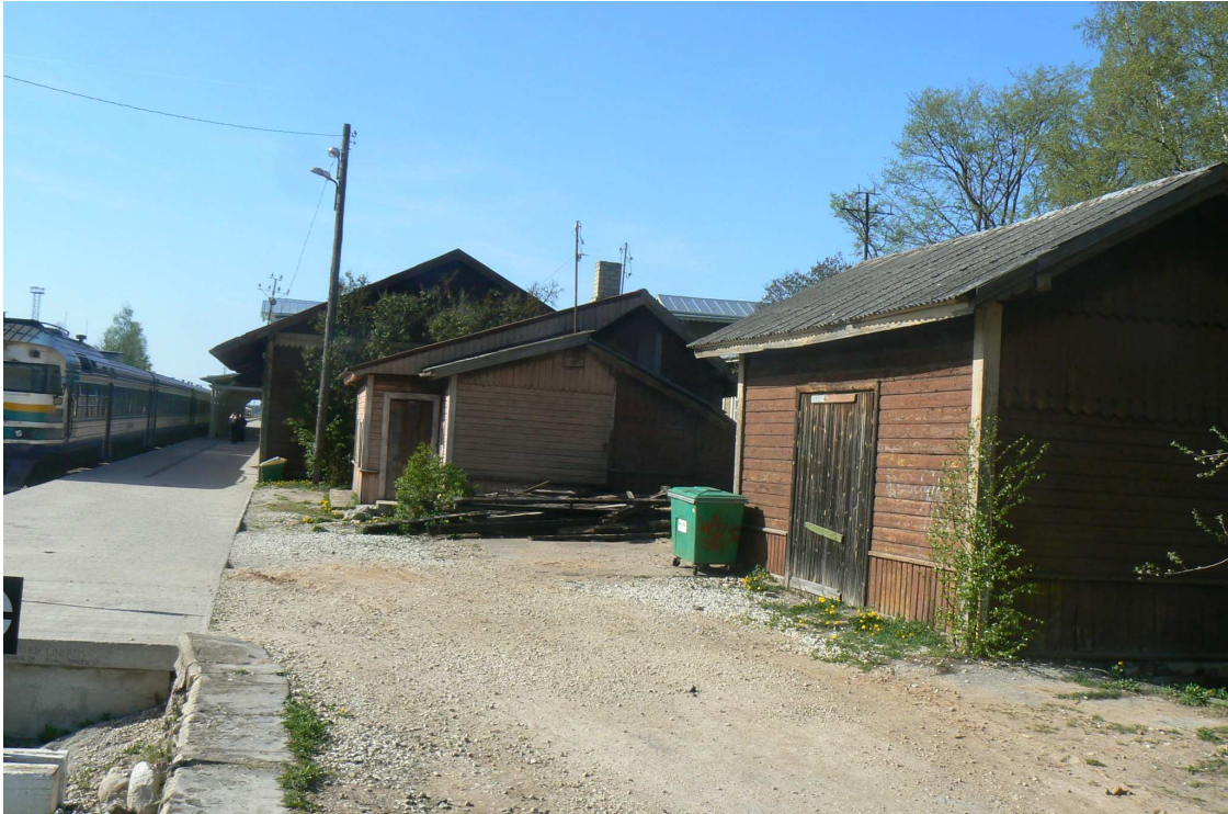
Foto 1: Vaade Raudteejaama perooni poole veetorni ja raudtee vahelt (autori foto)
