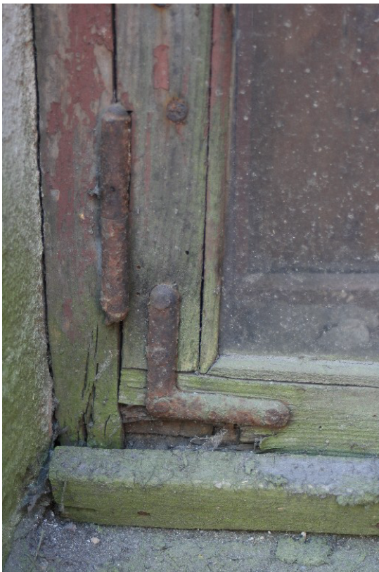
Joonised 3.26, 3.27 Hoovipoolse soklikorruse akna alaosa detailid ja vana pesuköögi ukse hing
