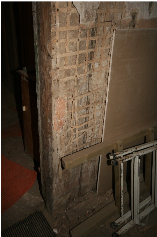
Joonised 3.59, 3.60 Krohvitud püstpalksein keldris ruumis 2 ja säilinud tuulekoda ruumis 8
