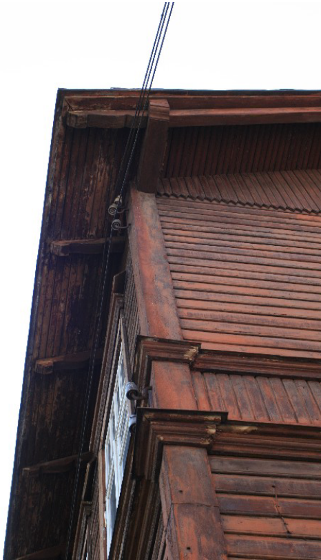
Joonised 3.17, 3.18 Fassaadi puitvahekarniisid seinä üla ja alaosas
