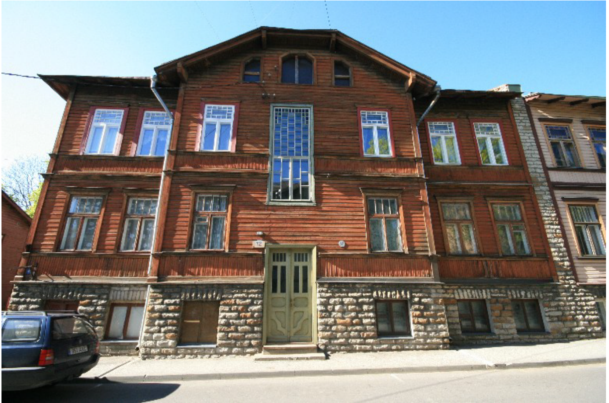
Joonis 3.3 Fassaad (vaade lõunast)
