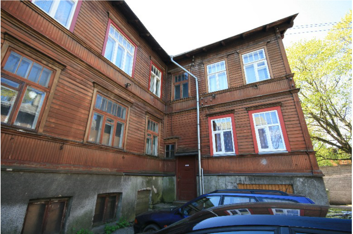
Joonis 3.7 Vaade läänest
