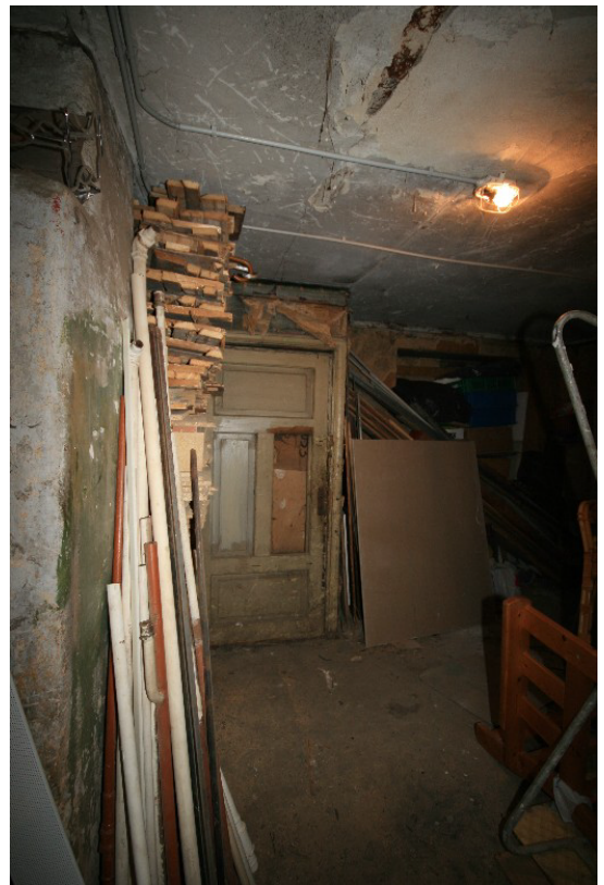
Joonised 3.59, 3.60 Krohvitud püstpalksein keldris ruumis 2 ja säilinud tuulekoda ruumis 8
