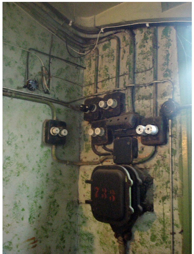
Joonis 55. Elektrikilp ja juhtmestik
