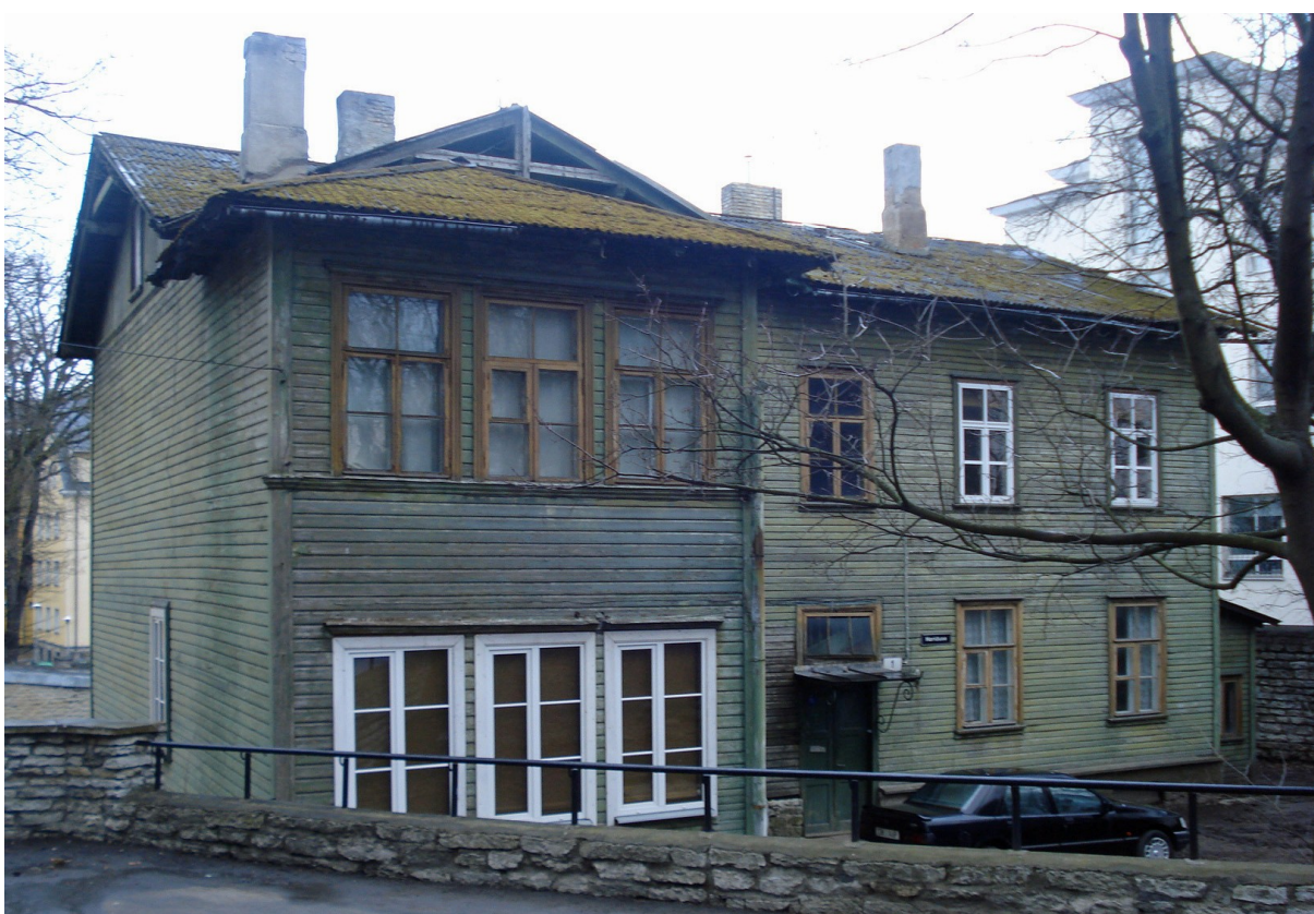
Joonis 28. Vaade Kaarli puiestee 11 hoovilt (loodest)
