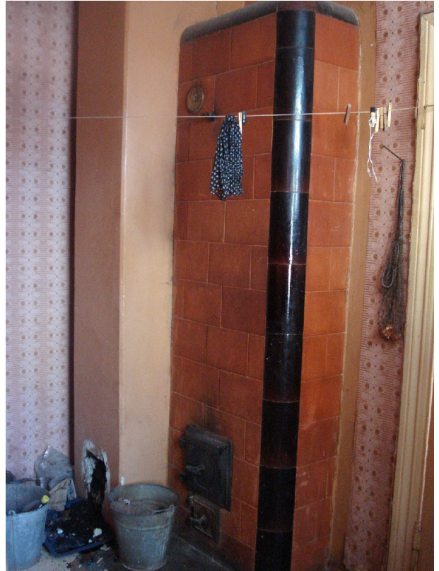
Joonis 79. 1. korruse pottahi
