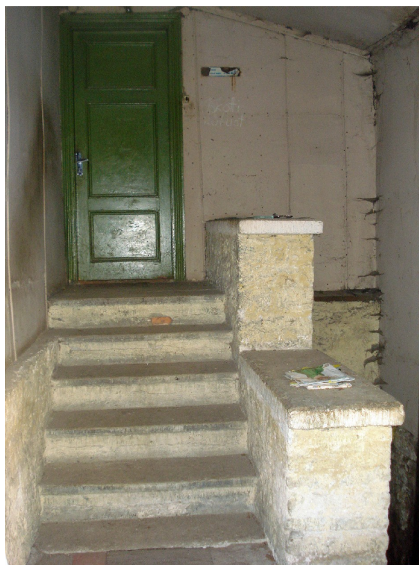
Joonis 51. Kinniehitatud kivitrepp
