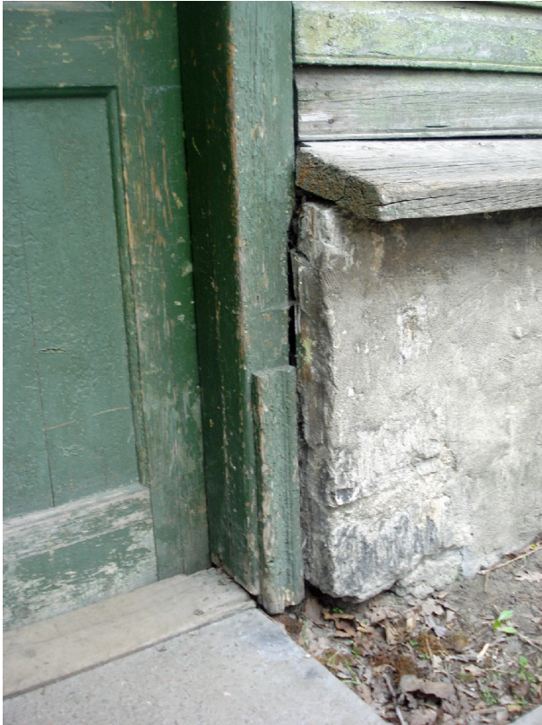
Joonis 45. Ukse piirdelaud
