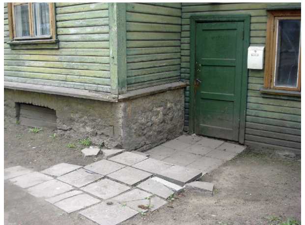
Joonis 43. Trepikoja sokkel
