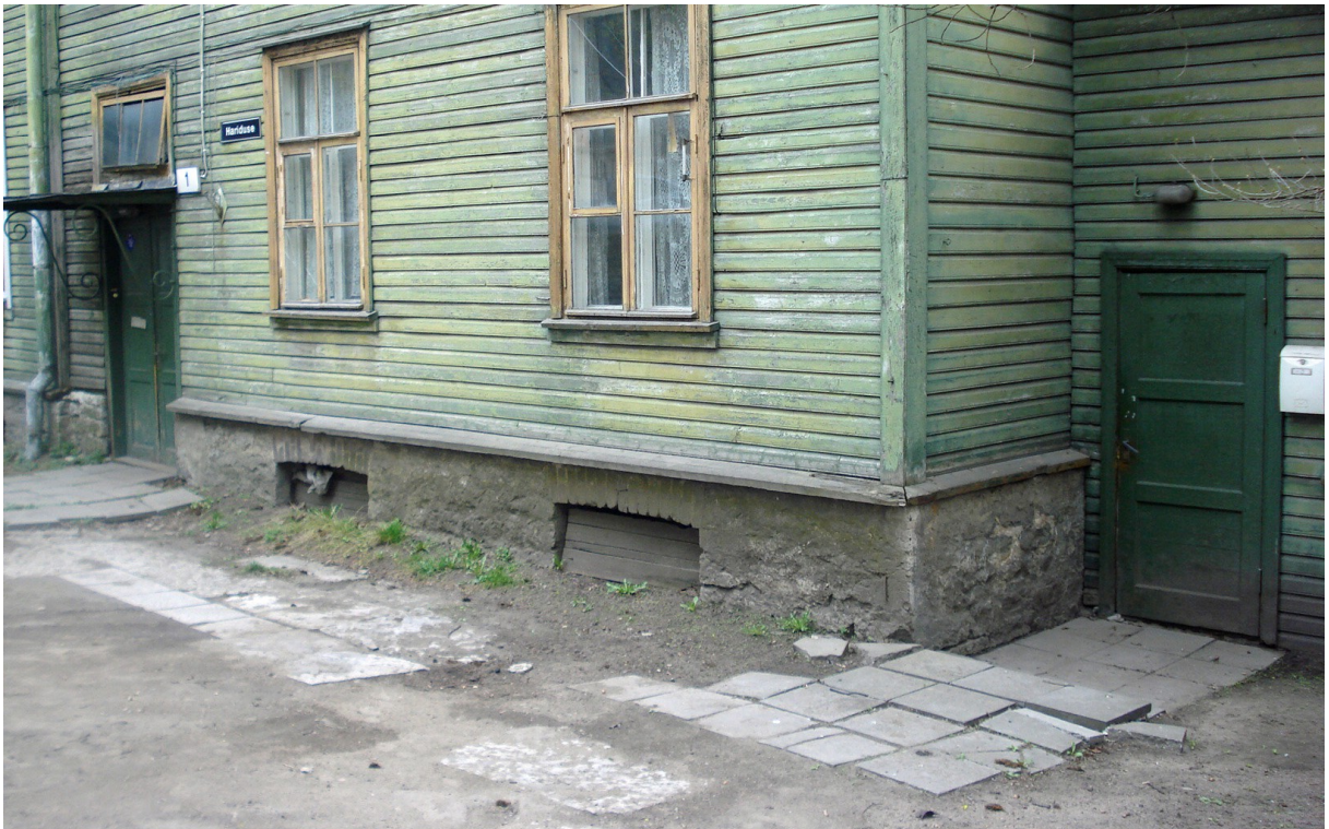
Joonis 34. paekivi- ja betoonplaatteed, esifassaadi laudis
