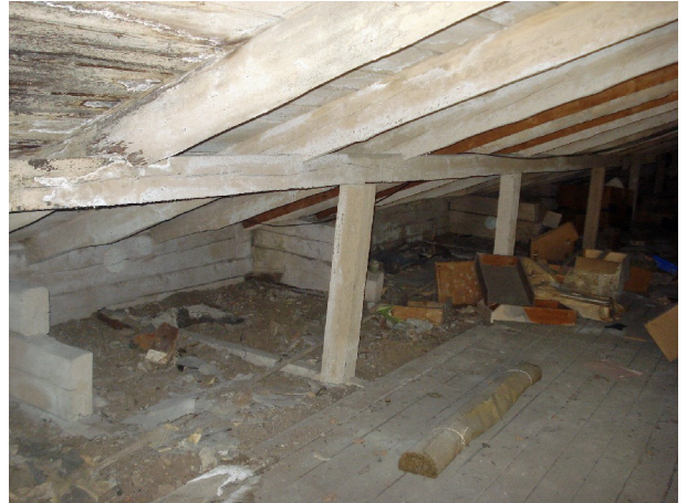
Joonis 59. Jäigastavad raiekorrad ja katuse konstruktsioon.
