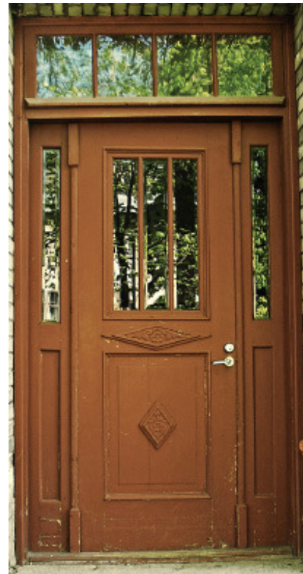
Joonis 33. Eenduv silikaattelistest puhasvuuk kivitrepikoda Joonis 34. Faasitud klaasidega peauks
