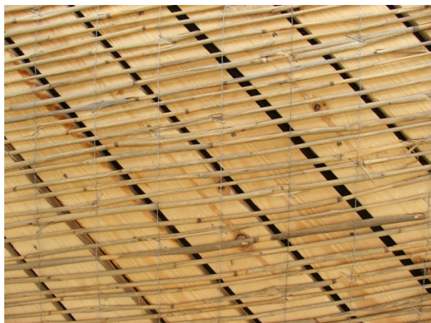
Joonis 18. Diagonaallaudisele kinnitatud krohvialune roomatt
