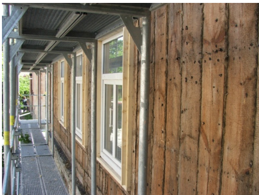
Joonis 13. Paljastatud püstplankseinad
