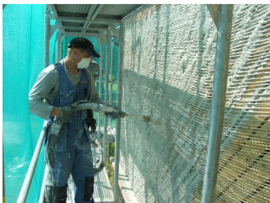
Joonis 19. Sisseviskekihi pritsimine roomatile
