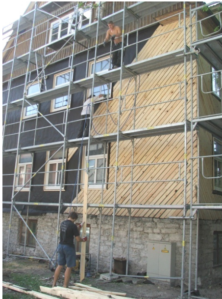
Joonis 15. ja Joonis 16. Tõrvatud tuuletõkkepaber ja diagonaalse krohivialuse laudise paigaldamine
