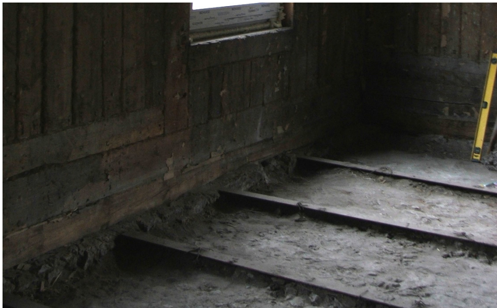
Joonis 31. Korter 3. terastaladel betoonist keldri ja esimese korruse vahelagi
