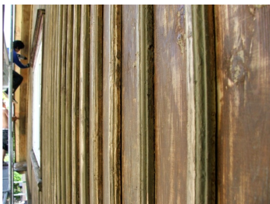
Joonis 23. Värvist puhastatud põhjapoolne otsaviil
