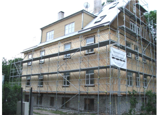
Joonis 15. ja Joonis 16. Tõrvatud tuuletõkkepaber ja diagonaalse krohivialuse laudise paigaldamine
