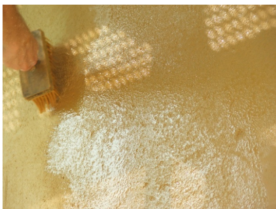
Joonis 21. Ristikujuline lubivärvimistehnika Joonis 22. Krohvi lubivärvimine tellinguvõrgu all
