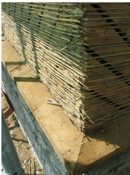
Joonis 17. Paigaldatud soklipseki alune veelaud
