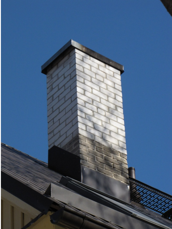
Joonis 29. Puhasvuuk silikaattellisest laotud korsten Joonis 30. Krohvist puhastatud korsten krt. nr 3
