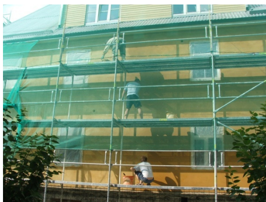
Joonis 21. Ristikujuline lubivärvimistehnika Joonis 22. Krohvi lubivärvimine tellinguvõrgu all
