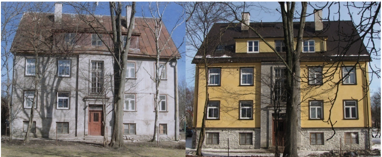
Joonis 28. Fotod Tare 7 esifassaadist 2006. aasta ja 2009 aasta kevadel
