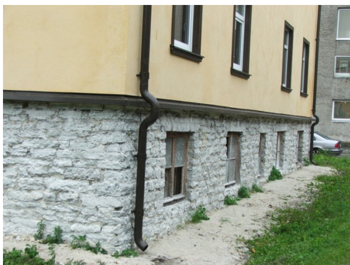
Joonis 27. Paekivist laotud sokkel, mis hiljem krohvatakse
