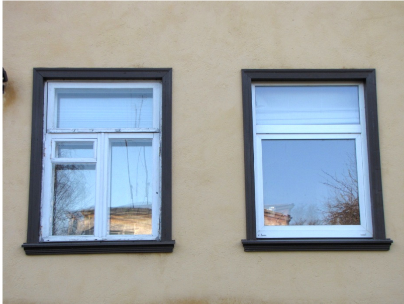
Joonis 37. Kaheraamne kolmeruudulise jaotusega ja õhutusaknaga originaal aken ja jaotust mitte järgiv plastaken
