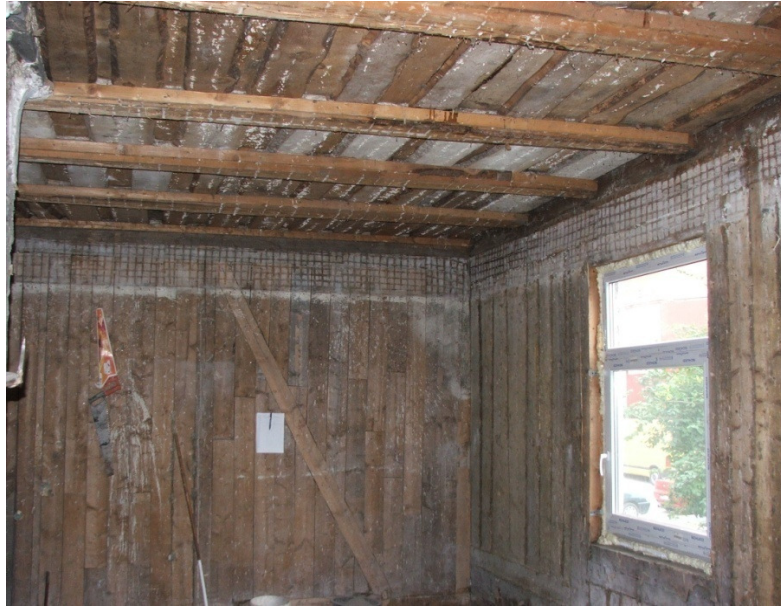
Joonis 32. Esimese ja teise korruse vahelae talad peale krohvialuse laelaudise eemaldamist
