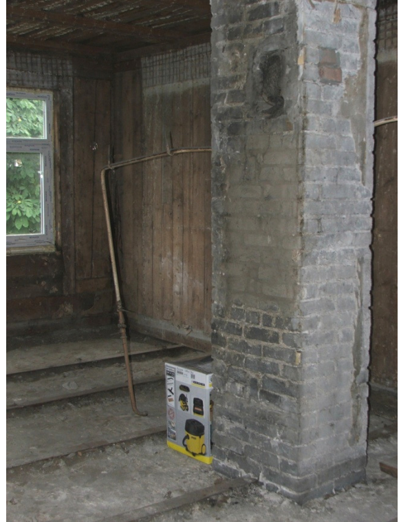
Joonis 29. Puhasvuuk silikaattellisest laotud korsten Joonis 30. Krohvist puhastatud korsten krt. nr 3
