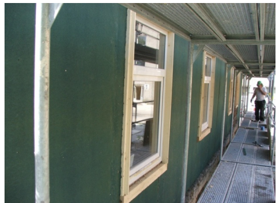
Joonis 14. Tuuletõkkeplaadiga kaetud seinapinnad
