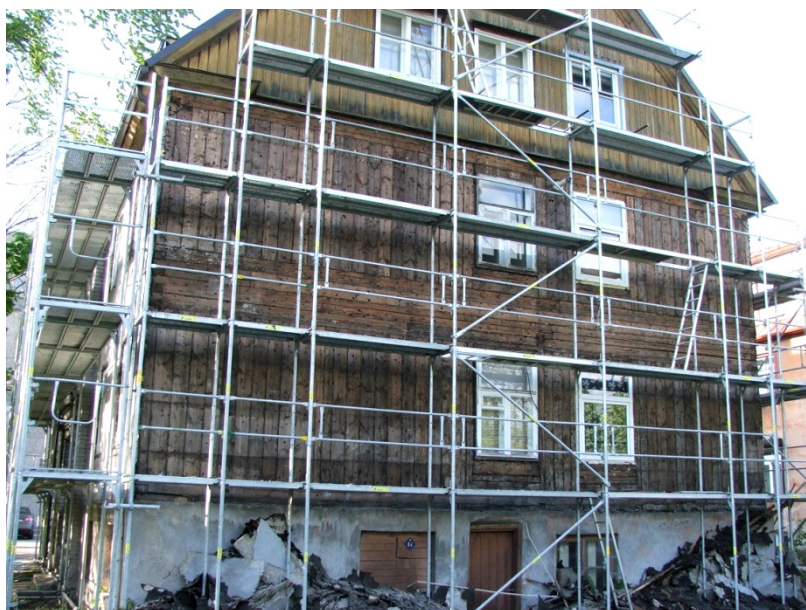
Joonis 8. Lõunapoolne püstplanksein peale vana fassaadikatte eemaldamist
