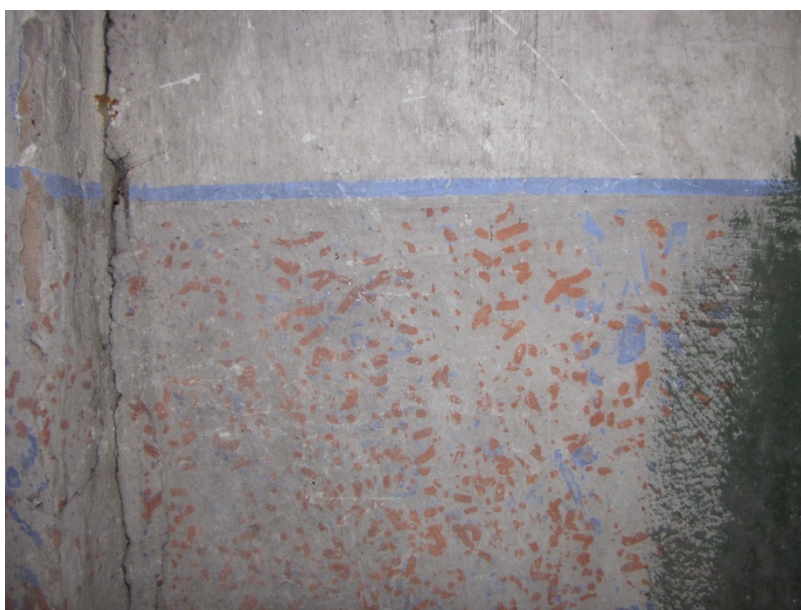
Joonis 44. Pesuköögi seinal säilinud koridori seinu katnud pinnaviimistlus
