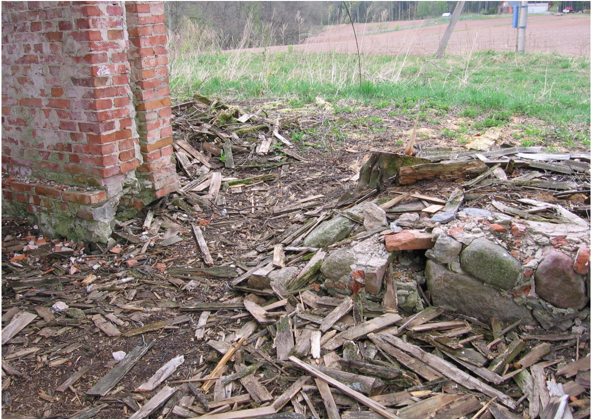
Foto 21 lõhutud vundament edelaküljel loodepoolses otsas
