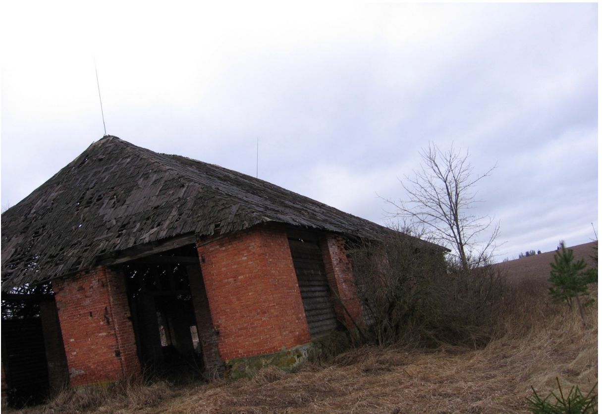
Foto 7 vaade kagust, terve katusekonstruktsiooniga veebruar 2008.
