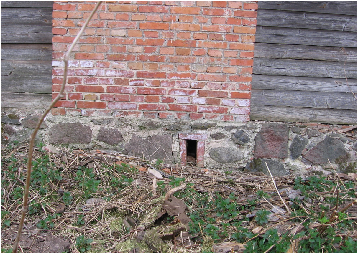
Foto 19 kirdepoolse seina vundamendi tuulutusaava
