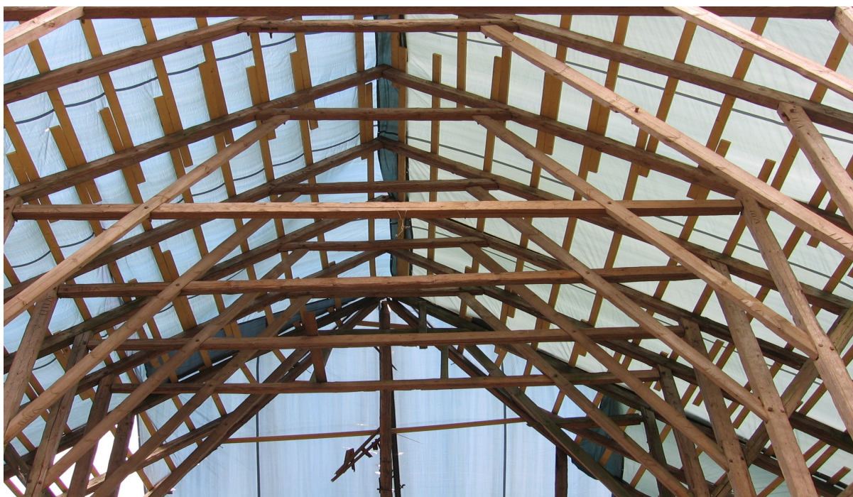
Foto 1A vaade rehe seest säilinud katusekonstruktsioonile
