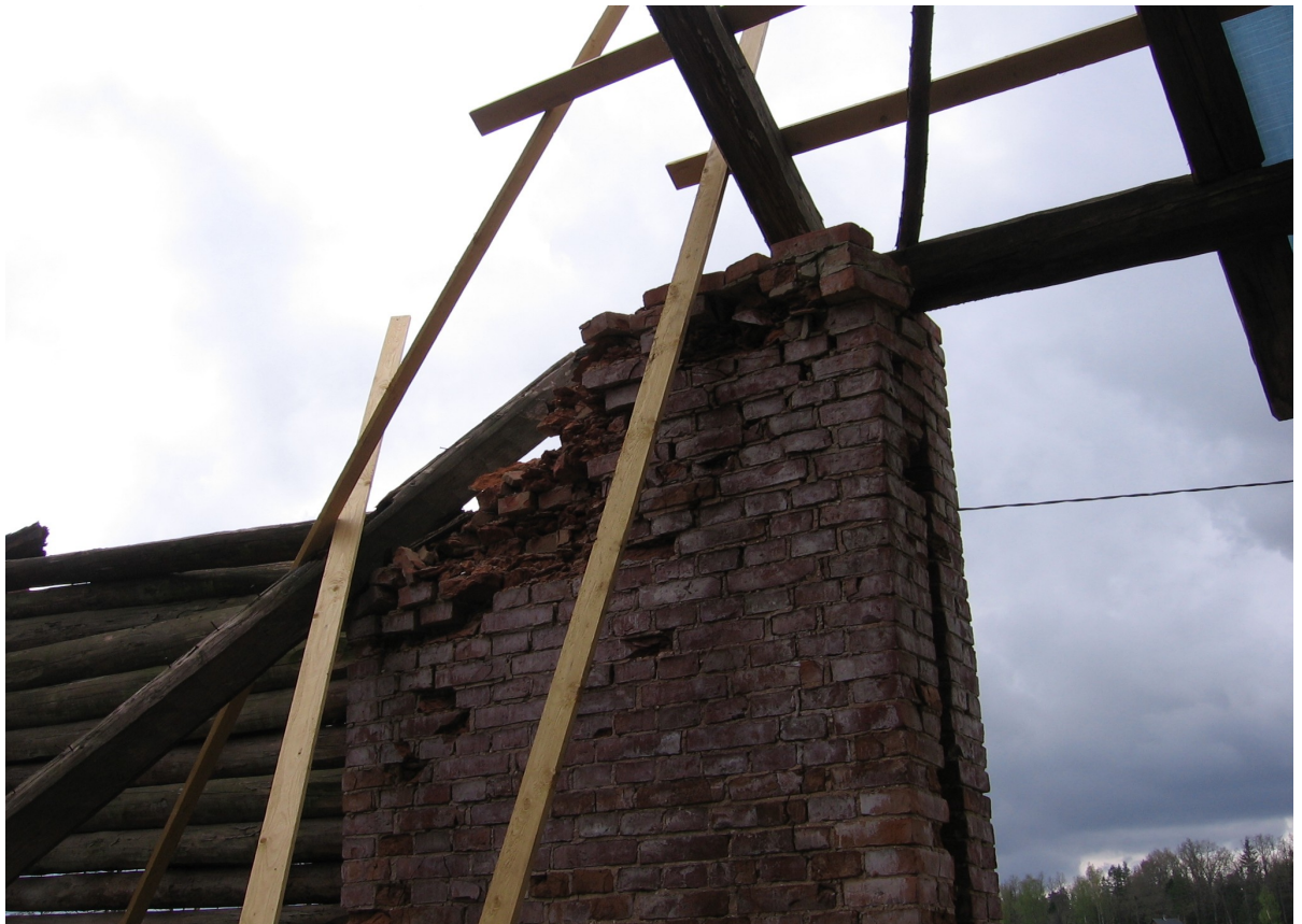
Foto 13 vaade seest edelasuunas lagunevale posti otsale.
