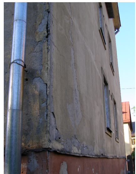
Joonis 9: Murenev fassaadikrohv.
