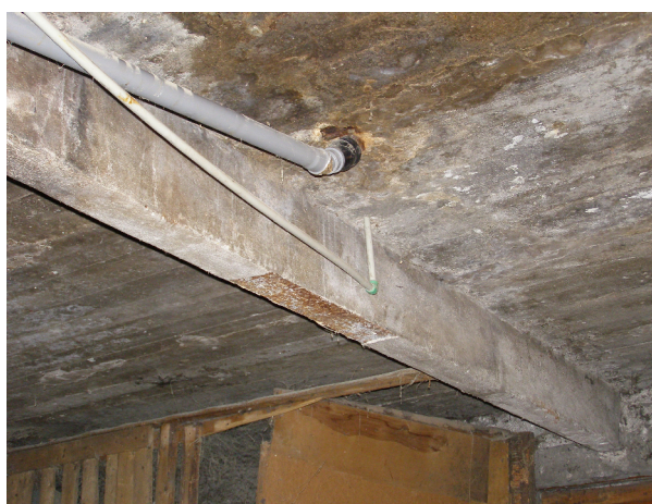
Joonis 8: Keldri betoonlagi.
