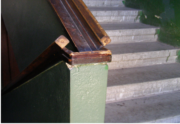
Joonis 11: Purunenud trepipiire.
