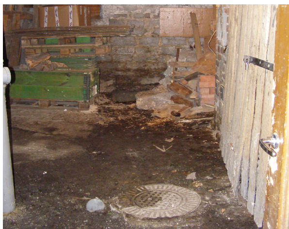
Joonis 7: Hävinenud keldri põrand.
