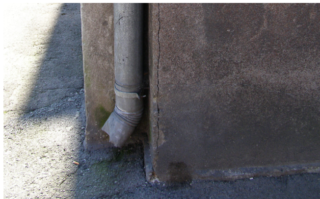
Joonis 5: Pragunenud lahtine soklikrohvi.
