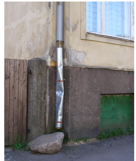
Joonis 25: Deformeerunud vihmaveetoru.
