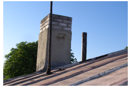
Joonis 24: Osaliselt krohvitud korsten.
